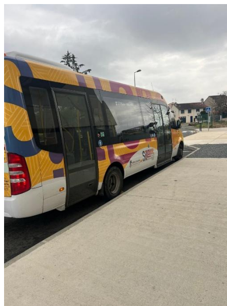
Arrêt récent avec un quai insuffisamment réhaussé
