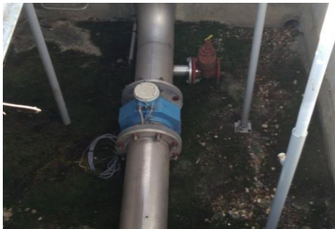
Regard Bypass amont dégrilleur
