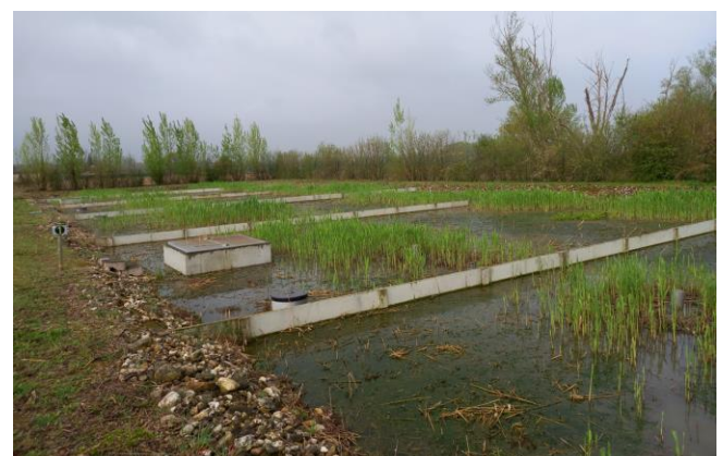
Lits plantés avec regards de noyage et regards de répartition
