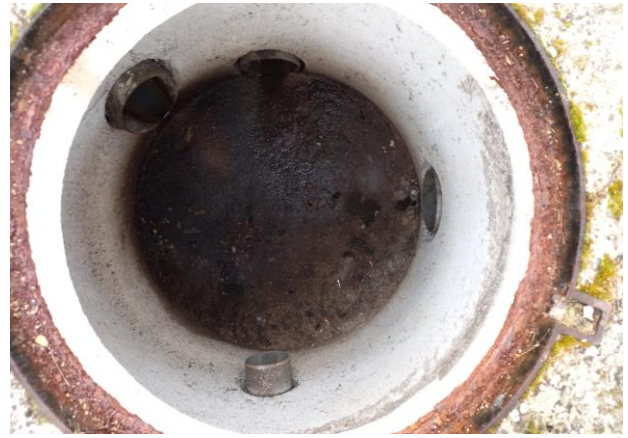
Regard by-pass amont dégrilleur
