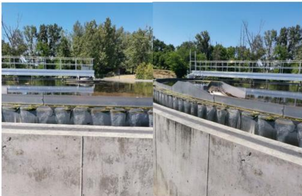
Vue d'ensemble du clarificateur-goulotte de débordement – pont racleur-saut à ski
