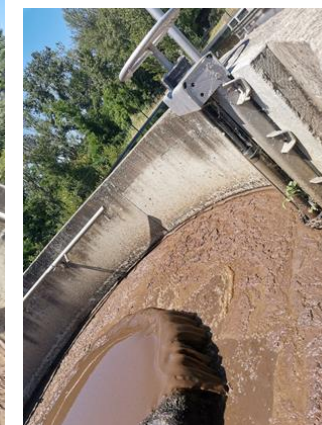
Vue d'ensemble du dégazeur - vasque à débordement - système d'aspersion et vanne à pelle
