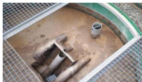
Ouvrage de bâchée
