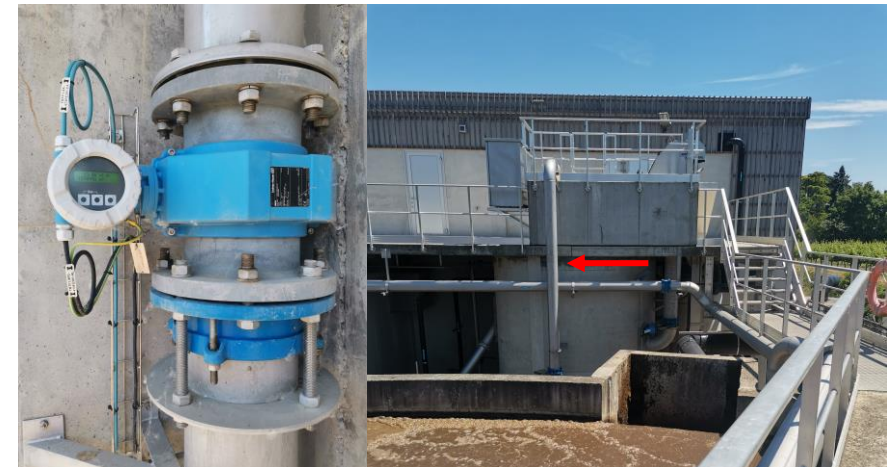
Débitmètre électromagnétique et conduite d'alimentation dégrilleur
