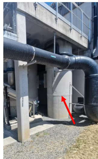
Chambre d'aération avant traitement
