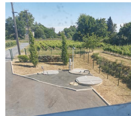
Regards de DTS (à gauche) – PR station (à droite) et CV (à l'avant)
