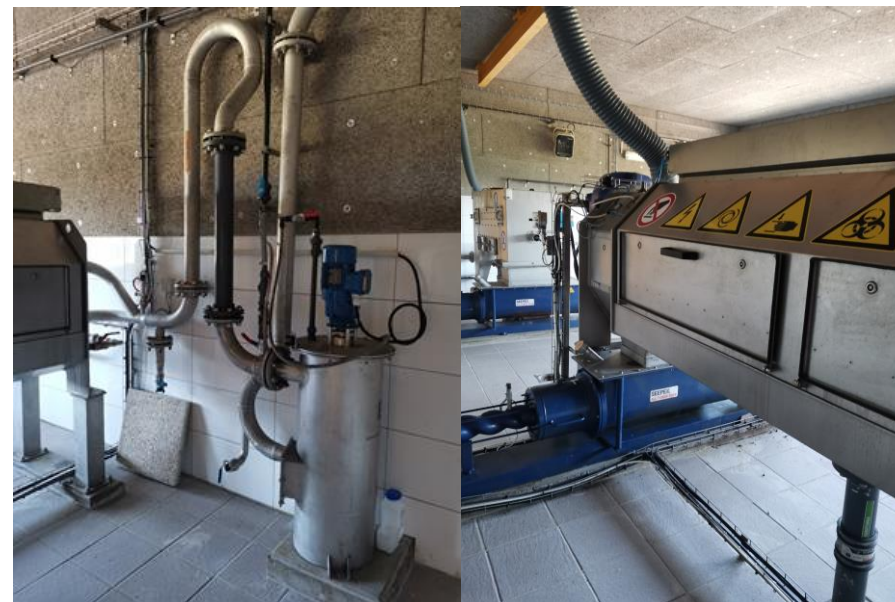
A gauche mélangeur du polymère, à droite, presse à vis
