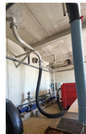
Remplissage des bennes
