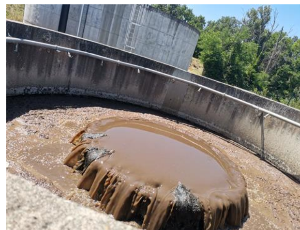
Vue d'ensemble du dégazeur - vasque à débordement - système d'aspersion et vanne à pelle
