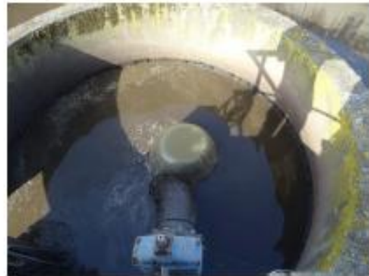
Zone de contact arrivée conduite de recirculation
