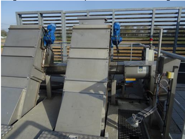
Dégrilleurs automatique et dessableur dégraisseur :
