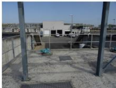
Accès aux dégazeurs et puis de recirculation
