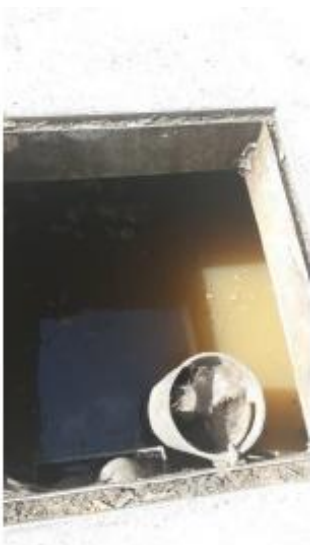
Dégraisseur statique avec siphon
