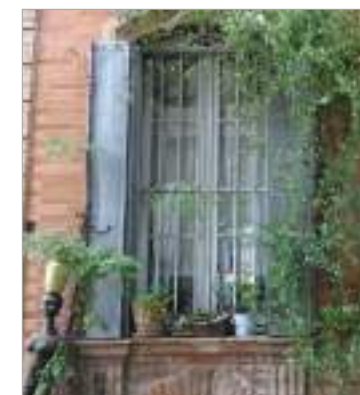
Contrevent se repliant dans le tableau.
