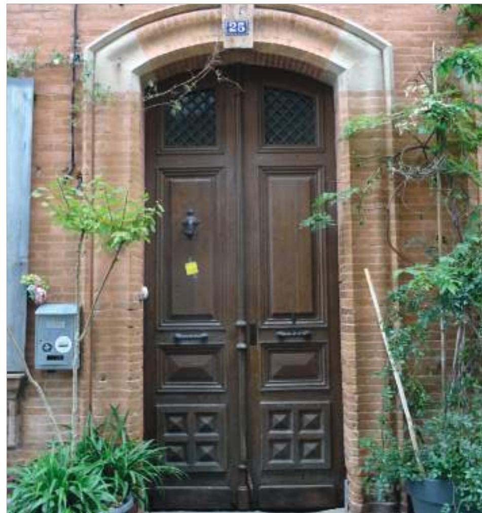
Porte à panneaux, les panneaux hauts vitrés sont protégés par des grilles en fonte moulée, motif de treille.
