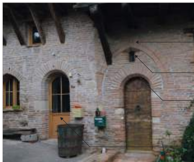
Structure mixte avec RdC et entresol bâtis en brique de terre cuite et pan de bois en encorbellement à l'étage. Place du Pont du Moulin.
