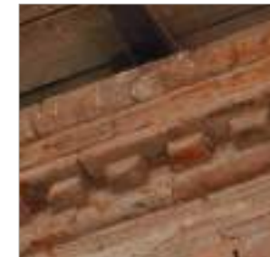
Corniche à denticules et chevrons avec abouts en quart-de-rond. Rue du Consistoire.
