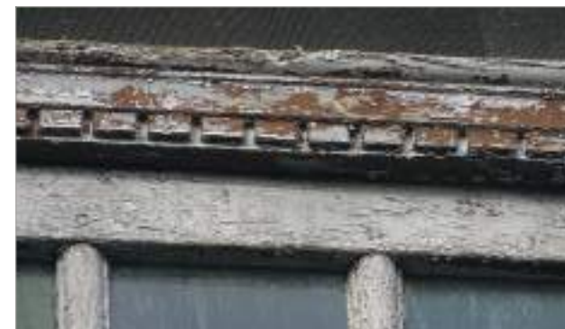
Imposte à denticules et châssis à petit bois de la fin du XVII ème siècle - Revel, Haute-Garonne.
