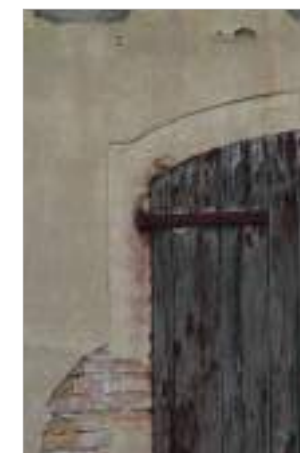
Enduit de l'encadrement plus fin et de la même teinte.
