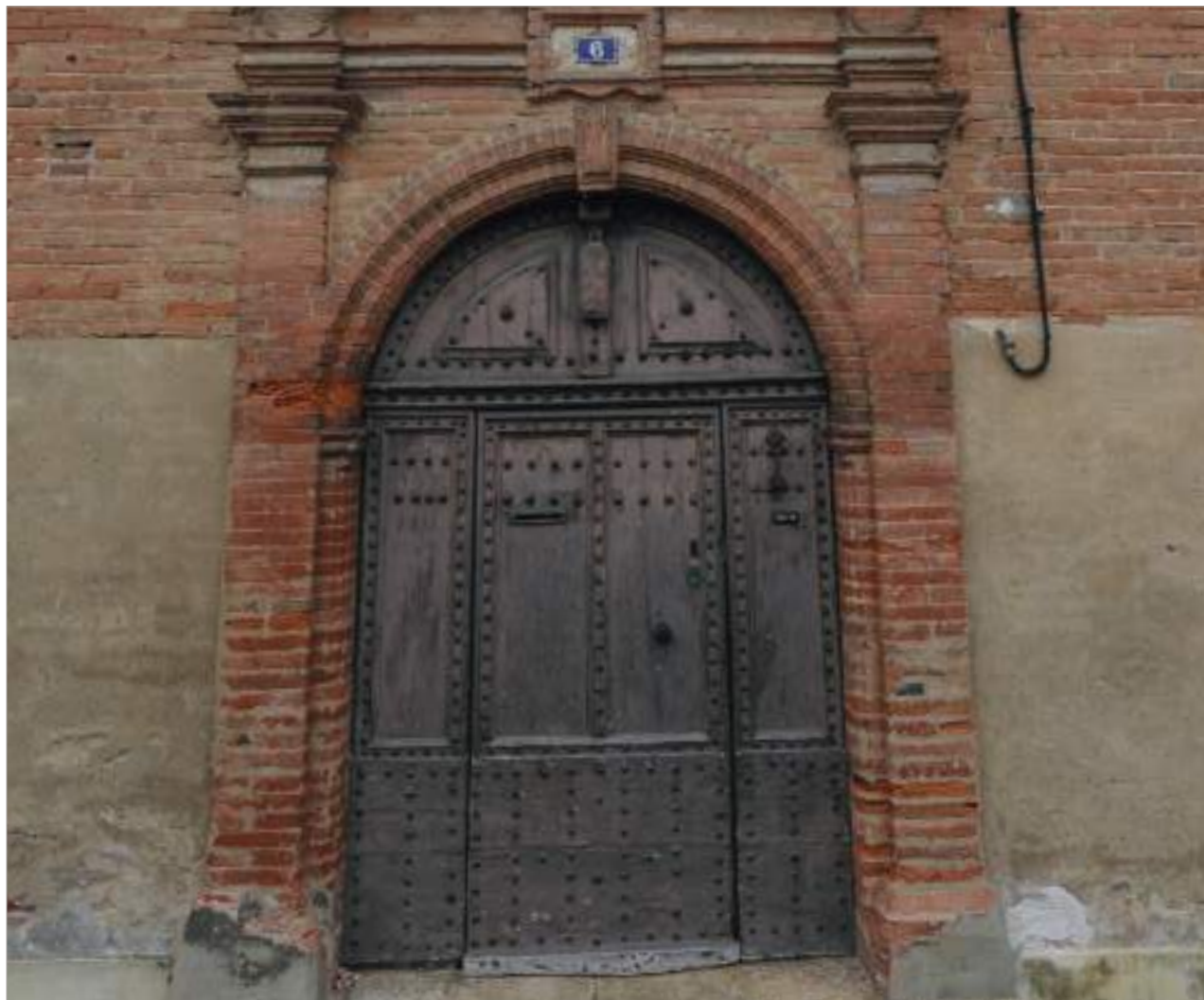
Deux menuiseries du XVII ème siècle avec un décor de clous en fer forgé à tête ronde, certaines parties du vantail sont sculptés. Quai du Descargadou.
