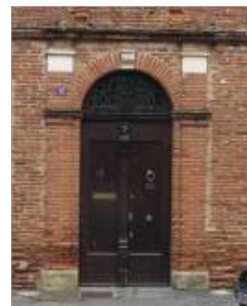
Même principe de pilastres soutenant un corniche mais la porte est en arc plein cintre. Utilisation de la pierre de taille.
