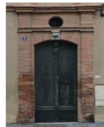
Sur cet exemple la corniche se décompose en trois strates horizontales, au centre prend place un oculus ovale.
