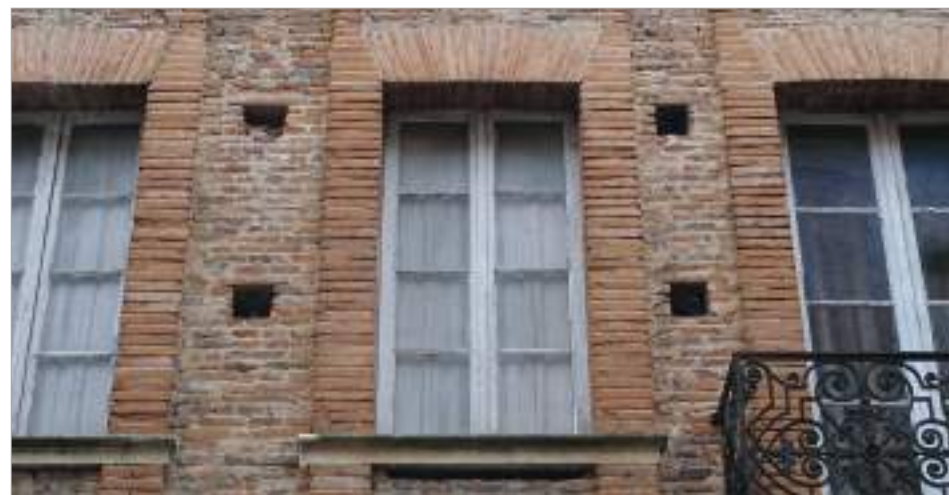
Châssis ouvrant à la française à petit bois. la proportion des vitres est proche du carré. L'occultation est assurée par des volets.
