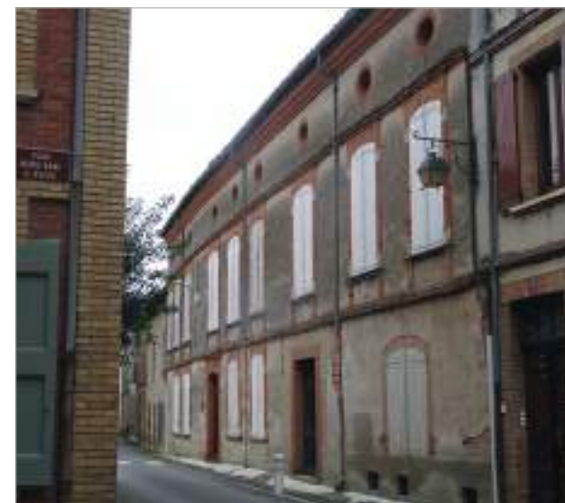
Fenêtre à encadrement saillant à crossettes (motif utilisé au niveau de l'arc et de l'appui). Rue Gabriel O'Byrne.
