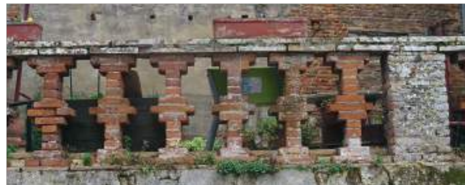
Barreaudage en brique de terre cuite.
