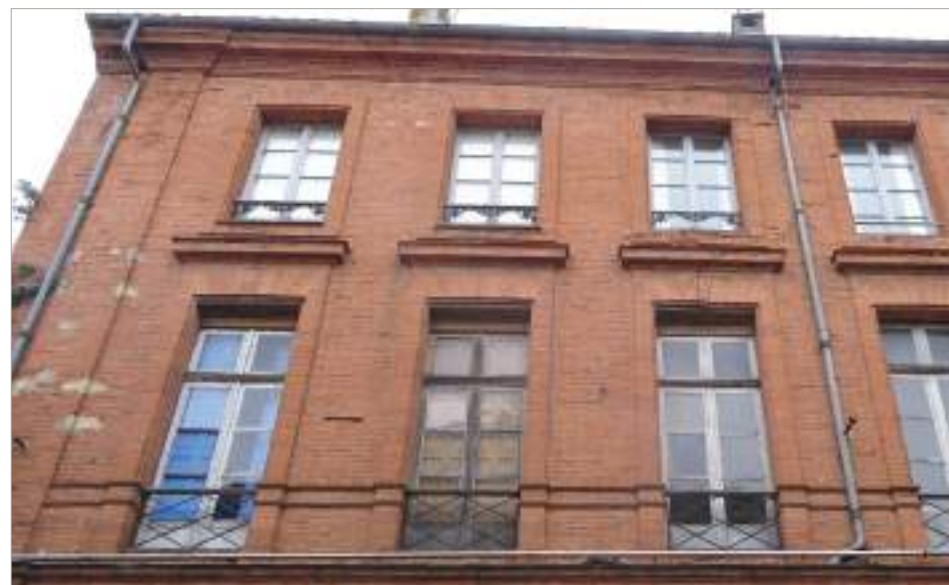
Châssis ouvrant à la française à grandes vitres du XIX ème siècle. La menuiserie de la porte-fenêtre est redécoupée par une imposte. L'occultation est assurée par des volets.
