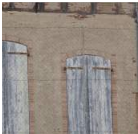
Enduit à la chaux teinté avec un sable blond.
