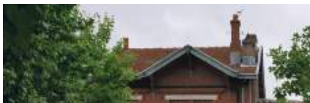
Pigeonnier, toiture à croupe habillée de tuile plate, arêtier en tuile canal et bel épi de faîtage vernissé.
