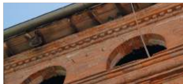
Corniche à denticules et chevrons avec abouts en quart-de-rond. Rue du Consistoire.
