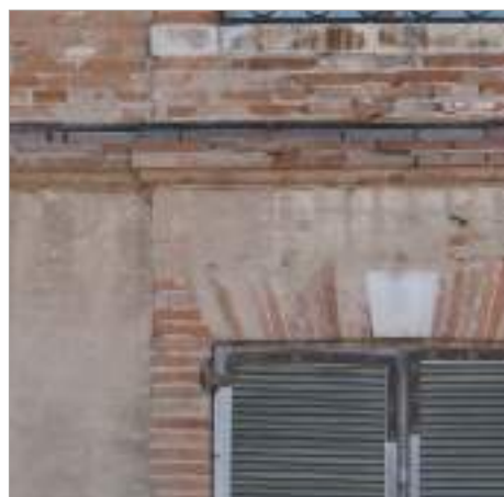
Encadrement recouvert d'un enduit fin de la même teinte que celui du mur.
