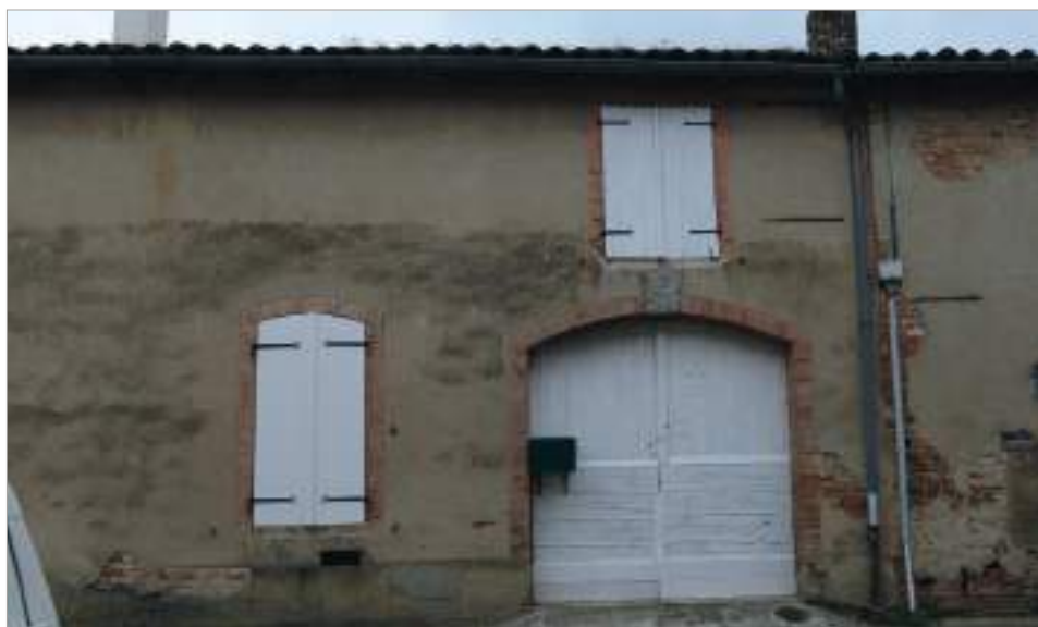
Les encadrements en brique sont masqués par un enduit similaire à celui couvrant le mur. Il est moins épais pour redessiner l'encadrement.
