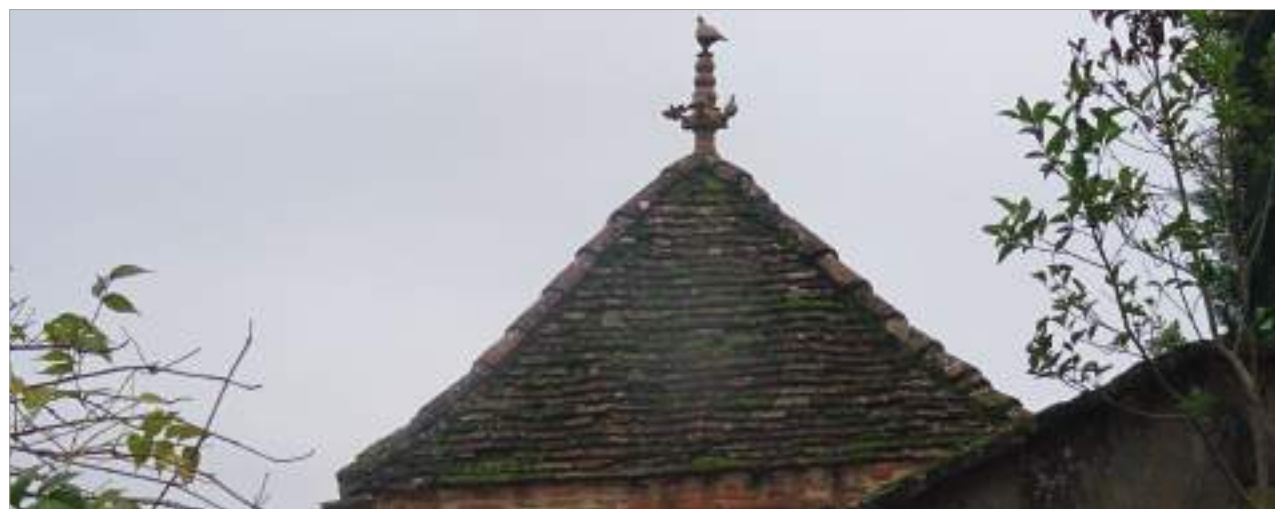
Pigeonnier, toiture à croupe habillée de tuile plate, arêtier en tuile canal et bel épi de faîtage vernissé.
