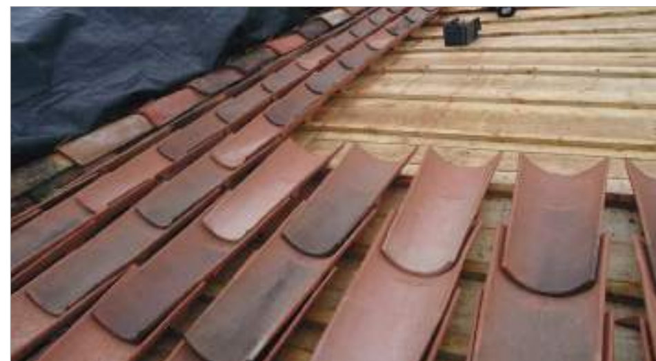
Tuiles de courant : accrochage des tuiles neuves à talon sur des liteaux.
