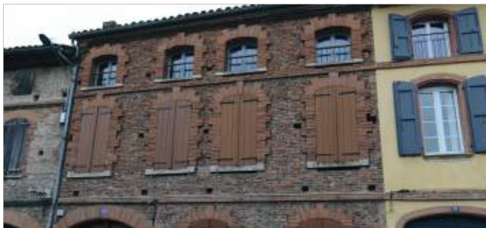
La brique utilisée sur cette façade n'est pas de bonne qualité et n'est pas bien appareillée. Elle était destinée à être enduite. Rue des Cordeliers.
