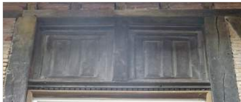
Imposte à denticules, meneau et châssis mobiles à panneaux de la fin du XVII ème siècle. Place Notre-Dame du Bourg.
