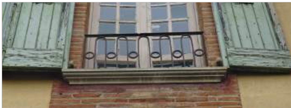
Garde-corps de fenêtres reprenant un motif d'épingle.
