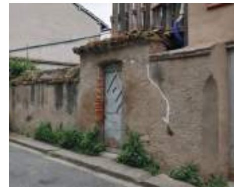
Deux murs avec un couronnement en pointe avec deux modèles de porte.
