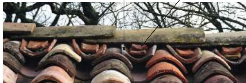
Deux tuiles de couvert superposées
