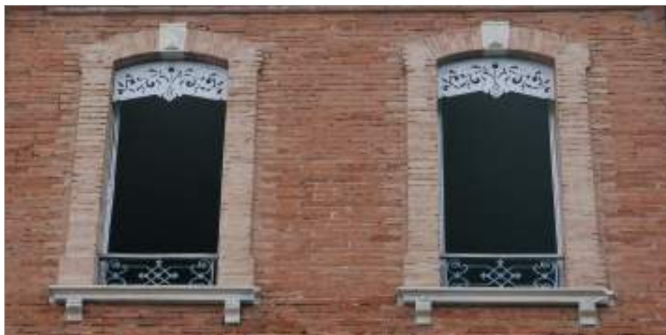
Barre d'appui en fonte moulée. Promenade des Lisses.
