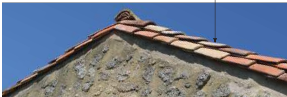
Deux tuiles de couvert superposées
