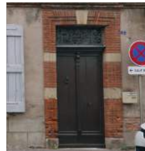
Encadrement rectangulaire à moulures planes surmonté d'une corniche. Quai des Escoussières.
