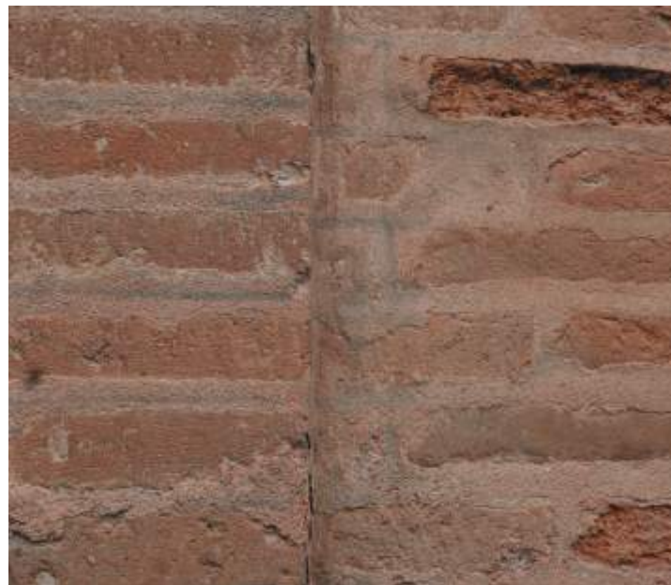
Détail des faux joints au badigeon gris.
