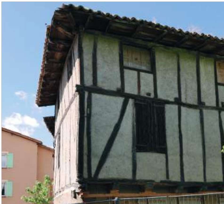
Toiture à croupe avec un important débord de toit. Place du Plo des Chevaliers.
