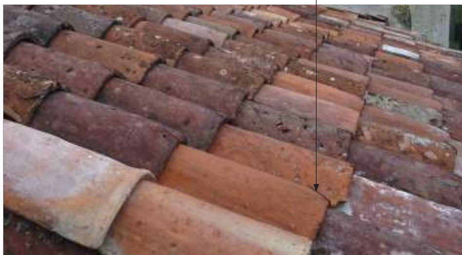
Tuiles de couvert : utilisation de tuiles anciennes qui sont fixées entre elles par des crochets.
