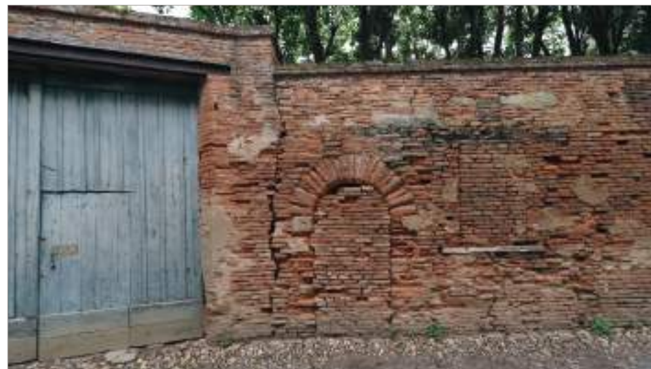
Vestige d'un rez-de-chaussée médiéval conservant une porte en arc plein cintre à l'encadrement chanfreiné. Rue du Consistoire.
