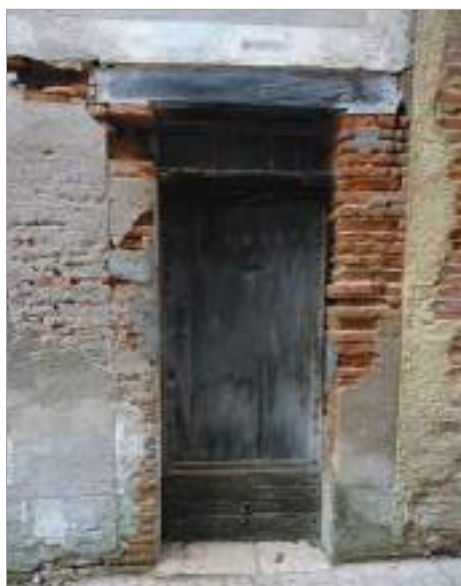
Porte piétonne d'une maison modeste : vantail à cadre avec imposte vitrée protégée par des barreaux verticaux en fer de section ronde.
