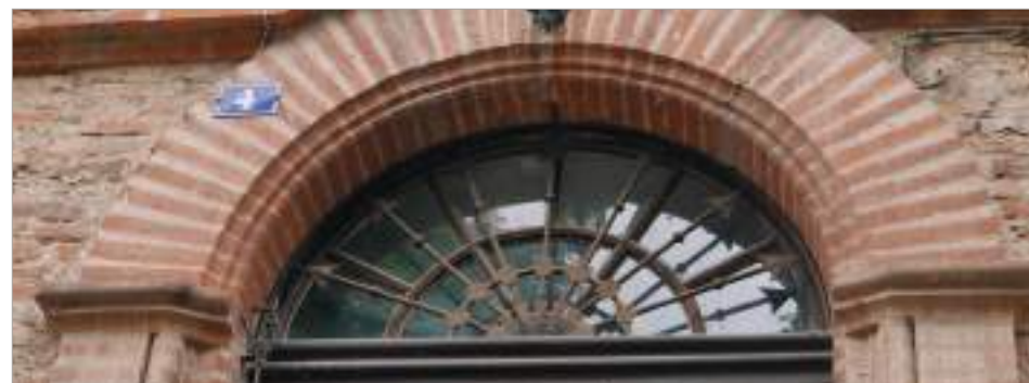
Grille d'imposte ouvragée : motif rayonnant avec des flèches pour les barreaux.
