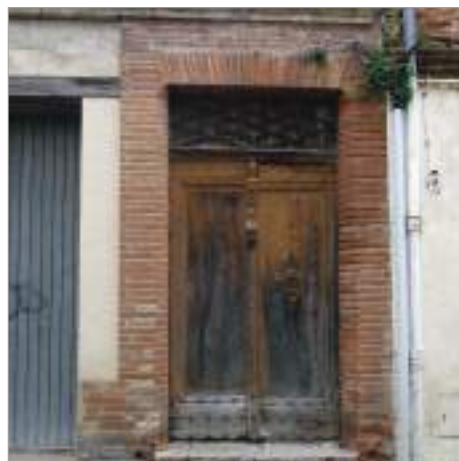
Même modèle, l'imposte vitrée est protégée par une grille en treille.
