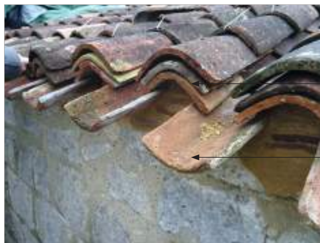
Mise en œuvre des tuiles à l'égout.
