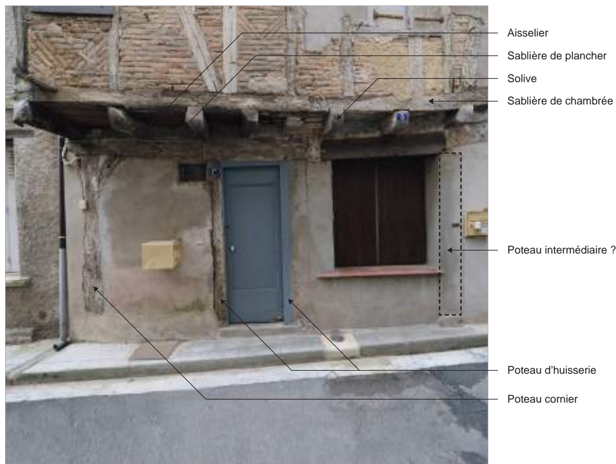
Maison en pan de bois à encorbellement dont le rez-de-chaussée était à ossature bois. Rue des Delherm.
