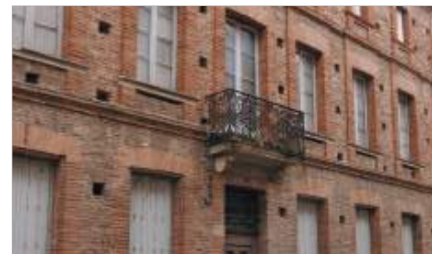
Balcon supporté par des consoles signalant l'entrée. Rue Raymond de Toulouse Lautrec.
