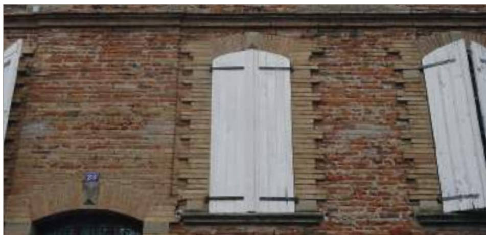
Détail d'un parement de brique destiné à être enduit. Quai de la Libération.
