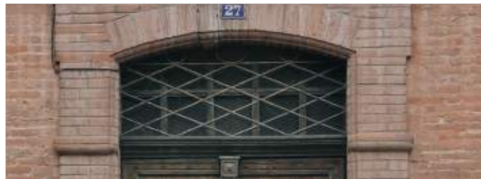
Grille d'imposte ouvragée : treillage.
