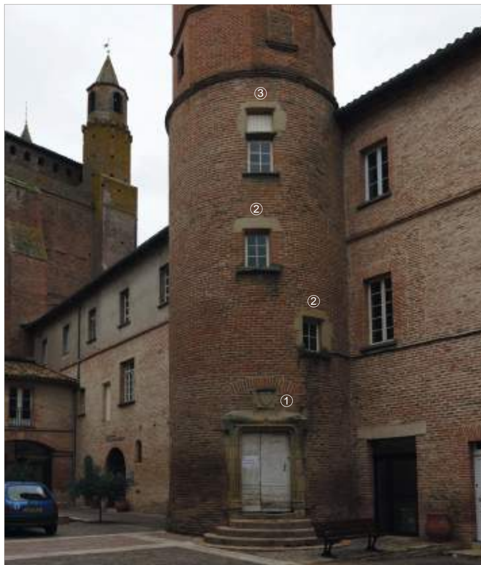
Escalier en vis hors œuvre de l'ancienne abbaye datant de la fin du Moyen Age. Il conserve une porte (1) dont le décor est caractéristique de cette période : encadrement mouluré à baguettes croisées aux angles et linteau droit recevant un décor en accolade. Également des jours (2) et une demi-croisée (3) dont les encadrements, bâtis en brique et pierre de taille, sont chanfreinés.
