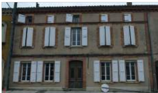
Jambage harpé en brique, pierre pour le linteau et l'appui des fenêtres, corniche à modillons.
