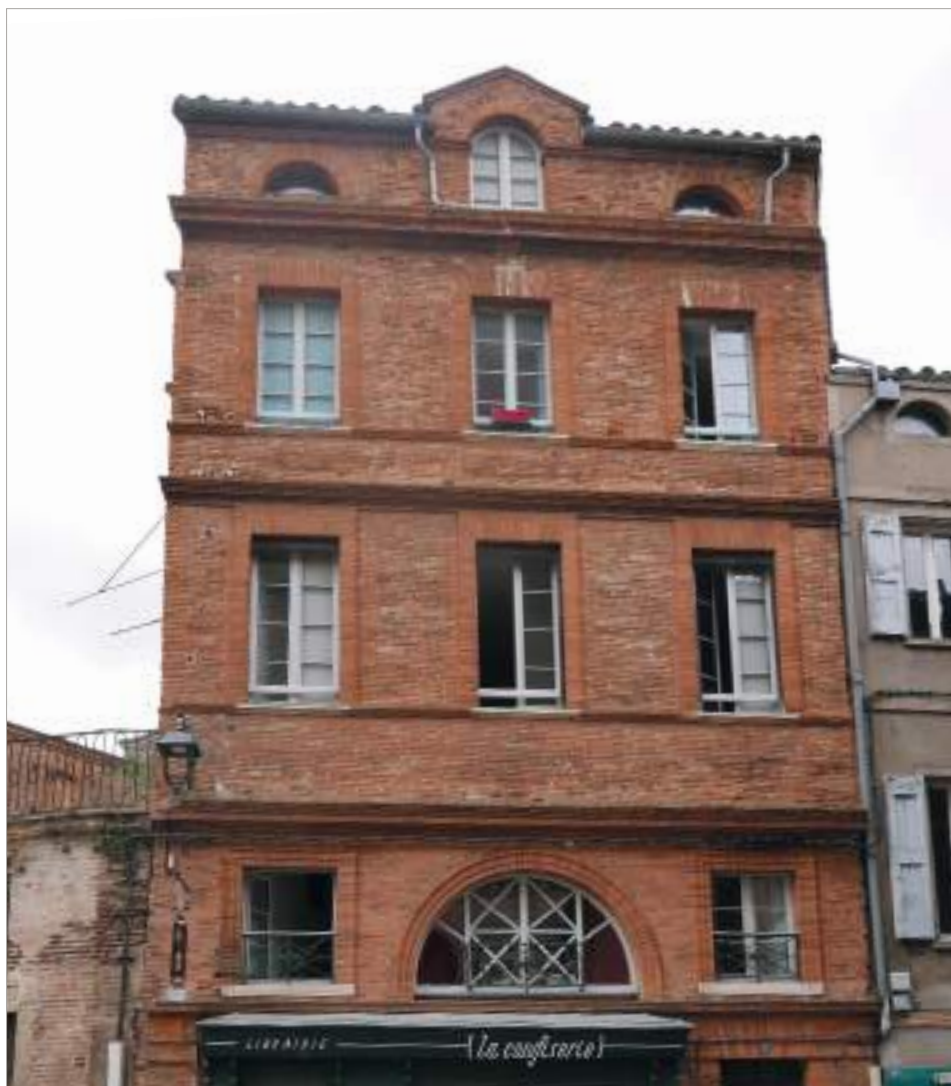
Arcade en arc plein cintre masquée par une devanture en applique. Rue du Pont del Pa.
