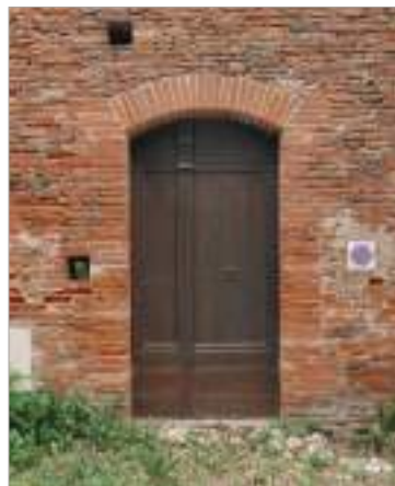
L'arc segmentaire et les piédroits de ces deux portes sont au nu du mur, le seul décor est le chanfrein de l'encadrement.
