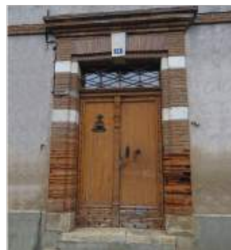
Emploi de la pierre comme élément décoratif : clé, assises et soubassement des jambages. Quai du Descargadou.
