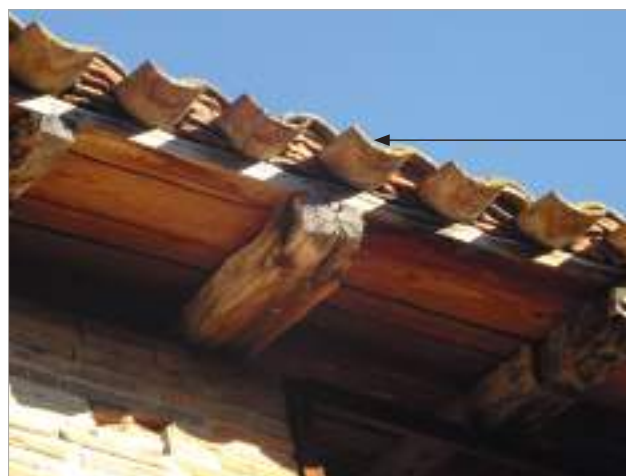
Mise en œuvre des tuiles à l'égout.
