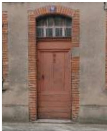
L'arc segmentaire et les piédroits de ces deux portes sont au nu du mur, le seul décor est le chanfrein de l'encadrement.
