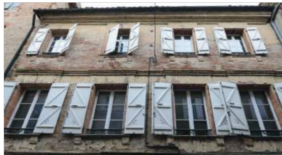
Le même badigeon ocre jaune vient couvrir le mur, la corniche, les cordons et les encadrements saillants.
