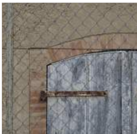
Encadrement laissé en brique, les joints sont de la même teinte que celle de l'enduit.
