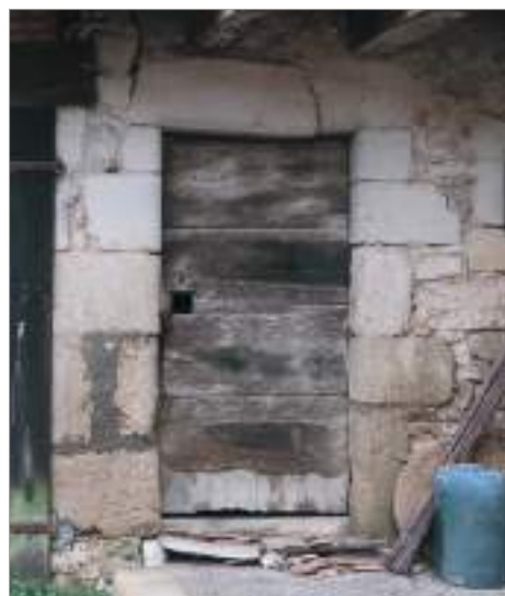
Vantail à lames croisées. Castelnaud-de-Montmirail, Tarn.
