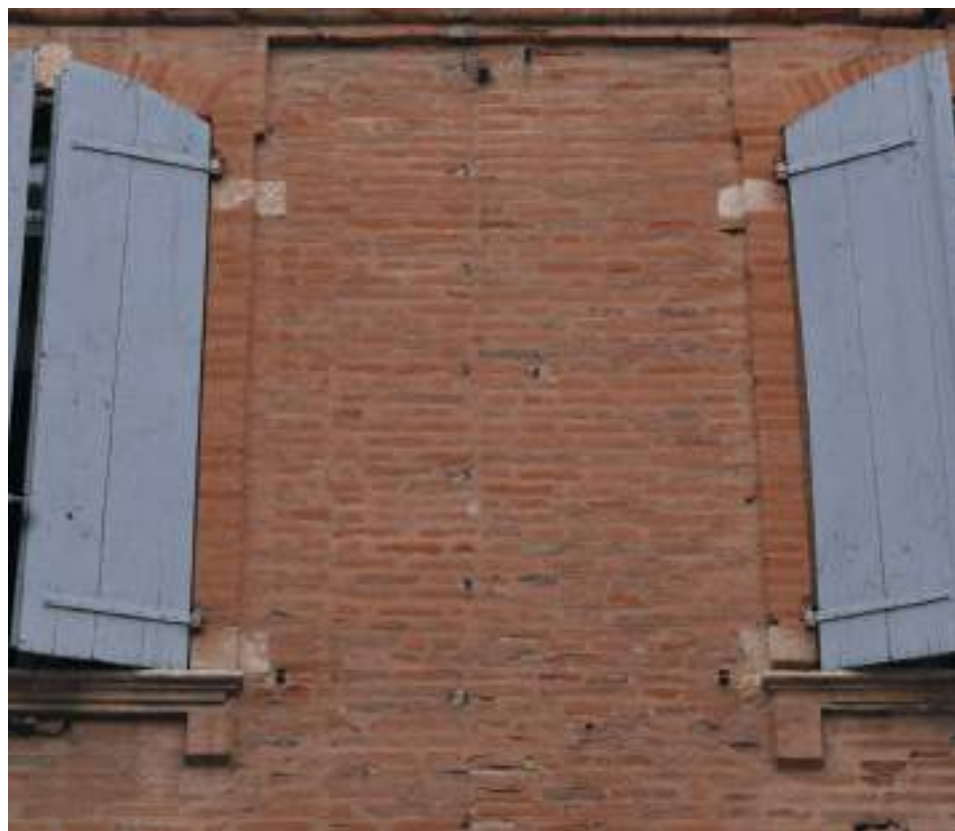
Finition à la chaux teintée avec de la poudre de brique.
