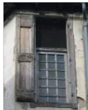
Imposte à denticules et châssis à petit bois de la fin du XVII ème siècle - Revel, Haute-Garonne.
