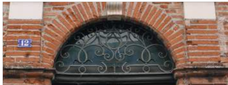
Grille d'imposte ouvragée : motifs avec volutes, les fers forment des courbes et contre-courbes.
