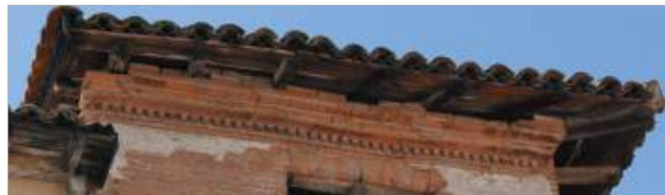
Corniche à denticules et chevrons d'angle rayonnants. Place Dauphine.
