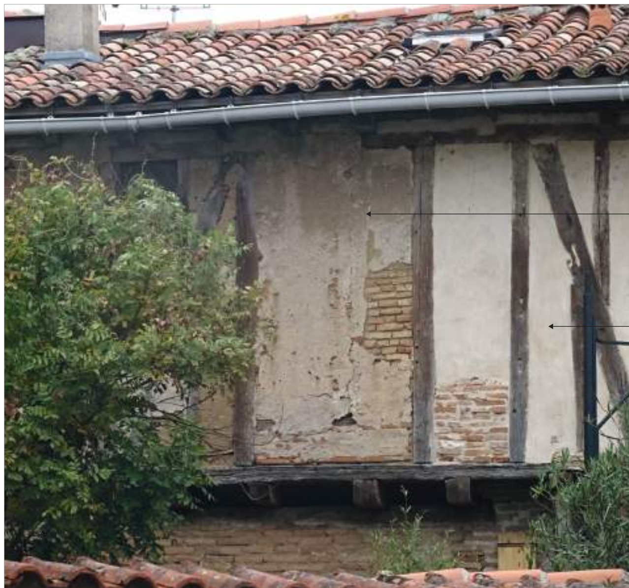
Détail d'un pan de bois. Place du Pont du Moulin.
