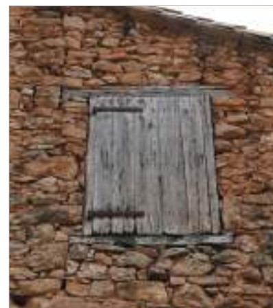
Les linteaux et appuis sont en bois, les jambages en moellons de pierre.
