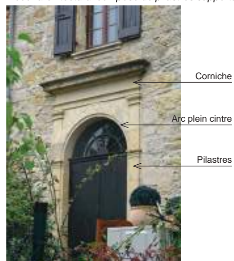
Décor architectural composé de pilastres supportant une corniche.
