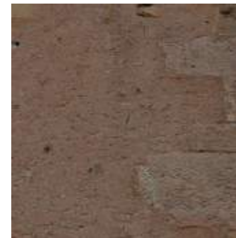
Enduit suivant le tracé des pierres.
