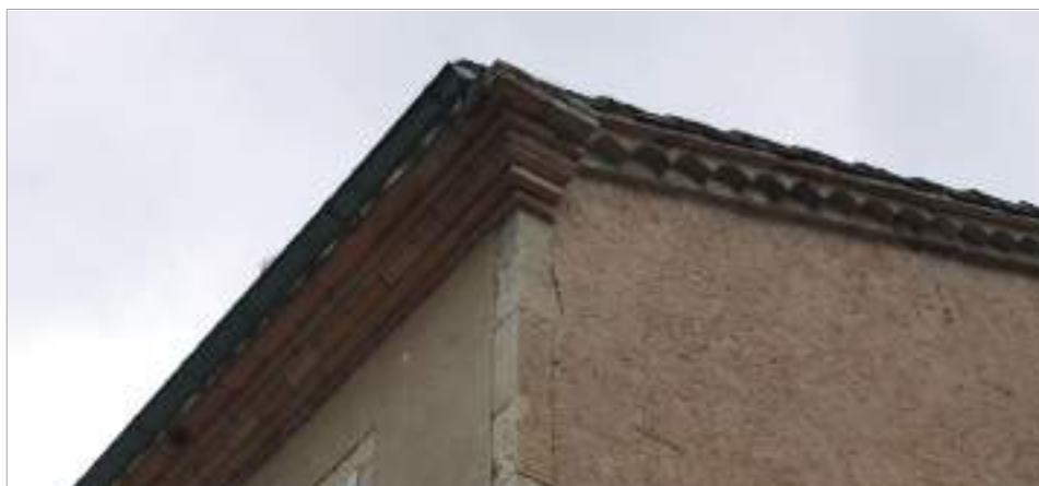
Corniche en brique foraine sur l'élévation sur rue, le pignon est couronné d'une génoise rampante à un rang de tuile.
