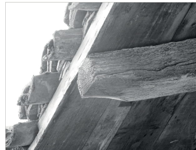
Détail d'un bec de flûte, Lisle-sur-Tarn.
