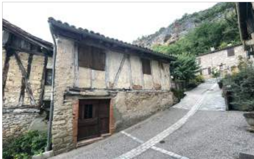
La structure médiévale a été déposée et remontée sans débord (parcelle 1084 partie 2).
