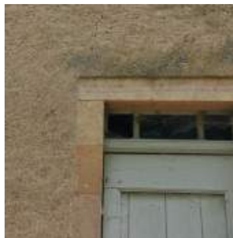
Arrêt droit de l'enduit, saillant.
