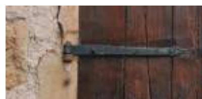
Organes de rotations : pentures évasées ou en flèche.
