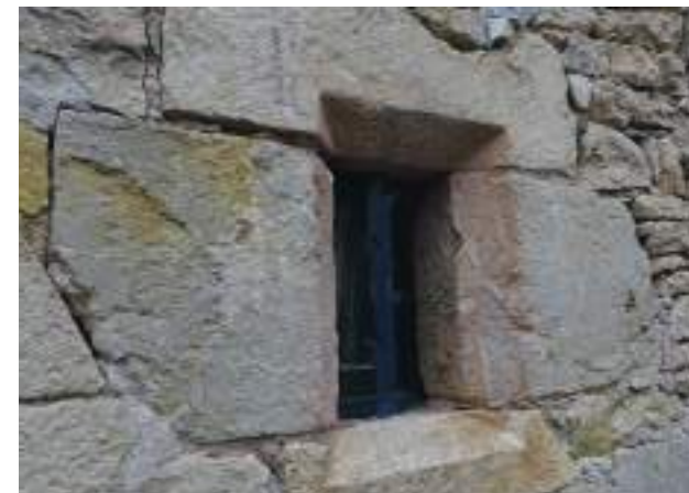
Porte et jour du RdC haut datant de l'époque médiévale. L'arête des deux encadrements est taillée en chanfrein.
