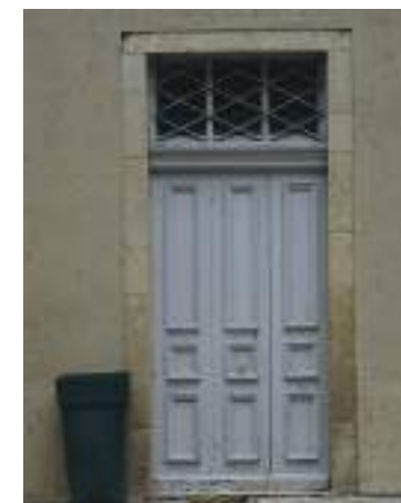
Porte bâtarde, vantail à panneaux.
