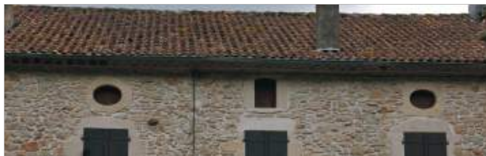
Au centre une baie rectangulaire dont le linteau est taillé en arc segmentaire.
