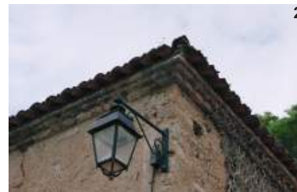
Génoise à un rang de tuile alternant avec des rangs de brique foraine. Les angles sont entièrement bâtis en brique foraine (1) ou avec des tuiles canal rayonnantes (2)
