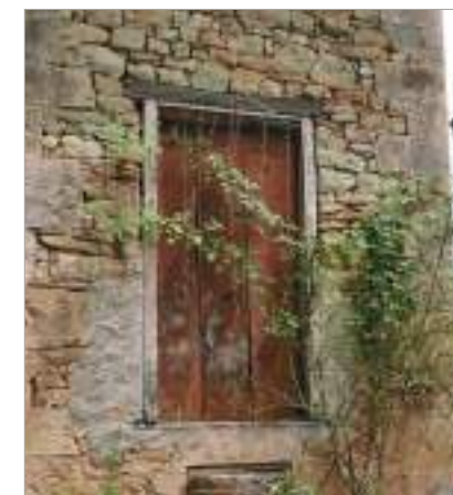
Certaines portes ou fenêtres ont des encadrements entièrement en bois.
