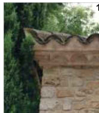
Génoise à un rang de tuile alternant avec des rangs de brique foraine. Les angles sont entièrement bâtis en brique foraine (1) ou avec des tuiles canal rayonnantes (2)
