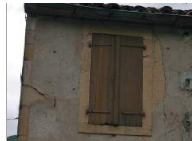
Encadrement en pierre de taille saillant.
