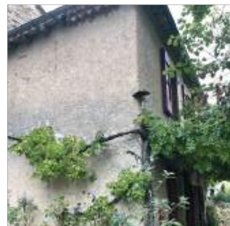
Enduit masquant l'angle.
