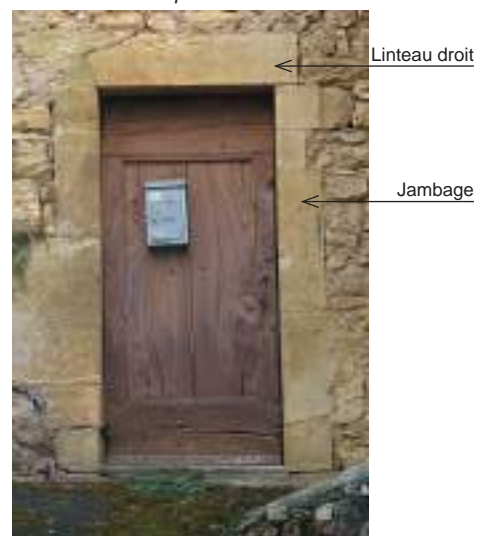
Encadrement en pierre de taille saillant.
