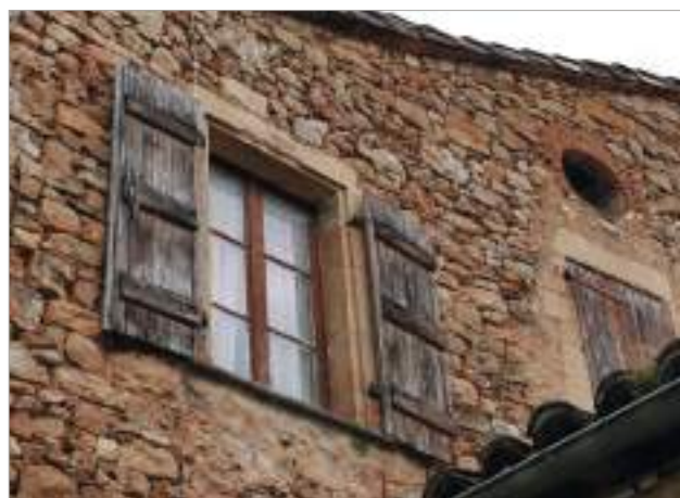
Encadrement en pierre de taille affleurant.
