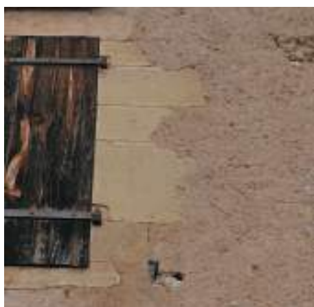
Enduit épousant la forme des pierres.
