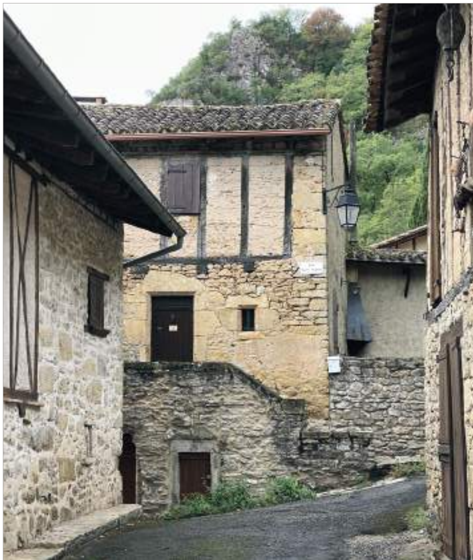
Maison en pan de bois à encorbellement de l'époque médiévale. La structure semble avoir été remontée au XVIIIème siècle (parcelle 231).
