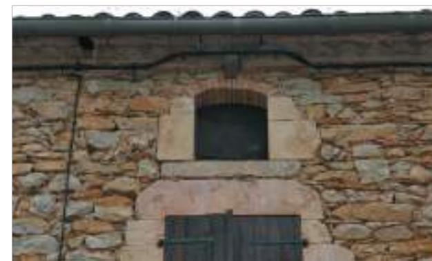
Arc segmentaire pour cet autre percement d'un grenier.
