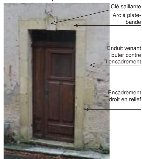
Encadrement en pierre de taille saillant.
