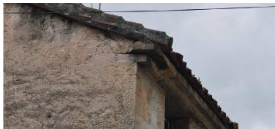
La corniche de cette maison modeste est constituée de deux assises de dalles en pierre de taille. D'autres édifices du village ont ce type de couronnement.
