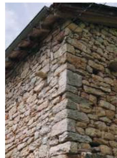
Chaîne d'angle en moellons de pierre.
