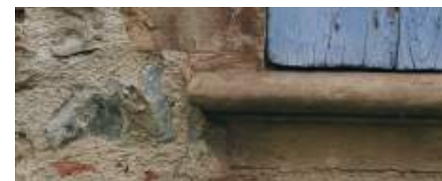
Encadrement en pierre de taille saillant.
