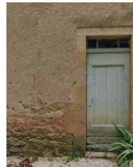
Enduit teinté avec un sable rose.
