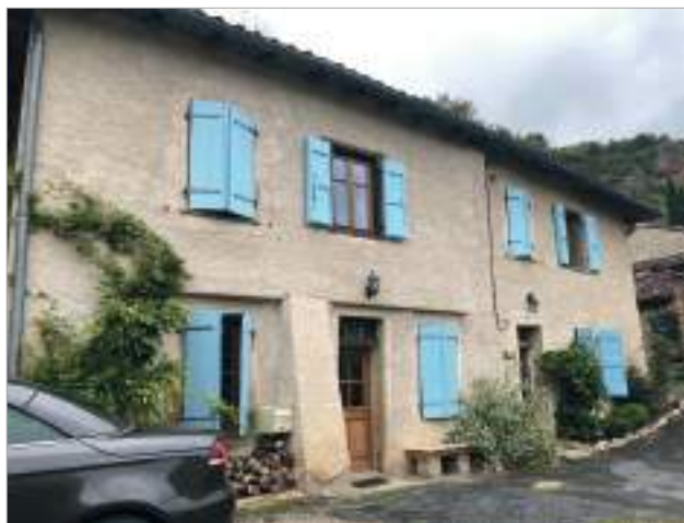
Maisons modestes avec un débord de toit charpenté.
