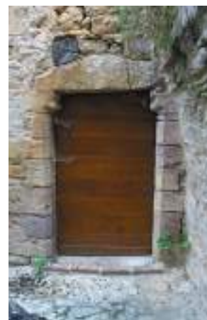
Porte et jour du RdC haut datant de l'époque médiévale. L'arête des deux encadrements est taillée en chanfrein.
