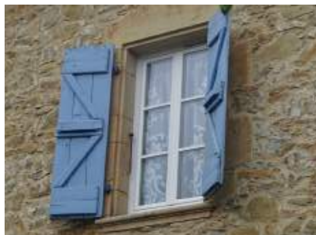
Encadrement en pierre de taille affleurant avec appui mouluré.
