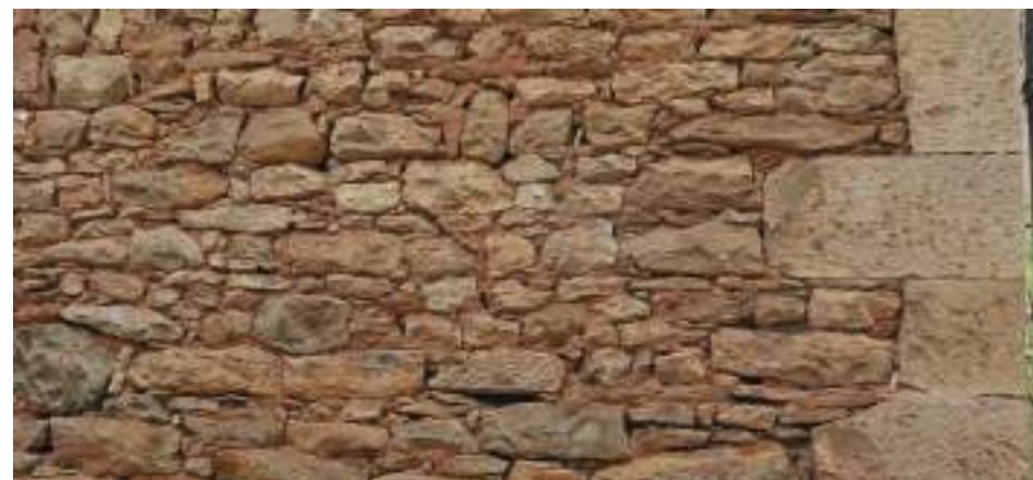
Détail d'un appareillage de moellons.
