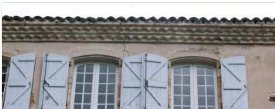
Détail d'une génoise à deux rangs de tuile alternant avec des rangs de brique foraine
