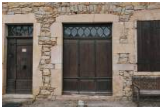
Deux devantures en retrait, fermées par des ais
