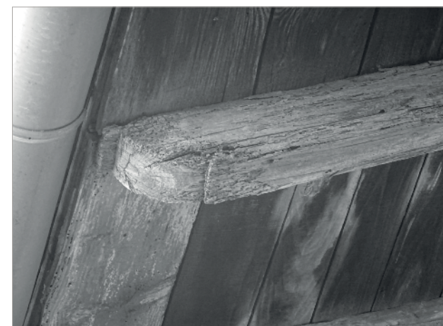
Détail d'un quart-de-rond, Lisle-sur-Tarn.
