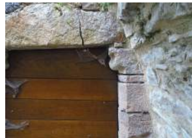
Porte et jour du RdC haut datant de l'époque médiévale. L'arête des deux encadrements est taillée en chanfrein.
