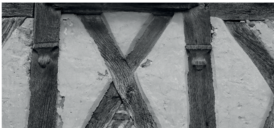
Détail de l'arrêt d'enduit en chanfrein, Touget (Gers).
