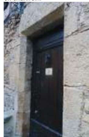
Porte et jour du RdC haut datant de l'époque médiévale. L'arête des deux encadrements est taillée en chanfrein.
