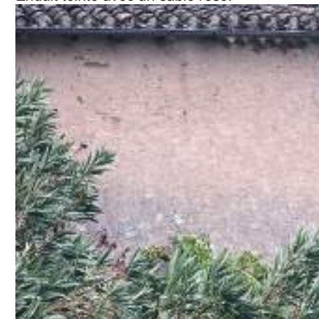
Enduit teinté avec un sable rose.
