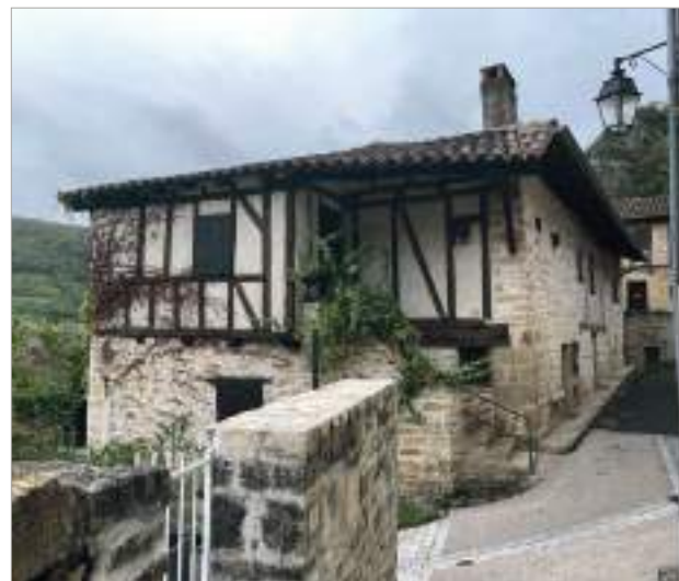
La structure médiévale a été déposée et remontée sans débord (parcelle 1084 partie 2).
