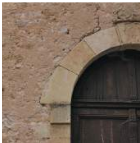
Arrêt droit de l'enduit, affleurant.
