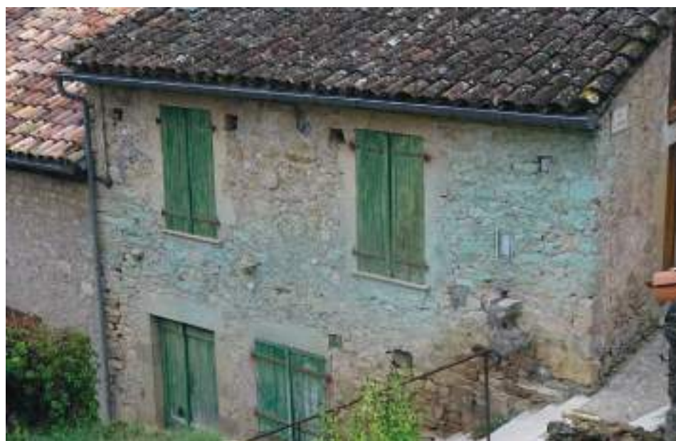
Les moellons étant de tailles variées, les assises de pose sont irrégulières.
