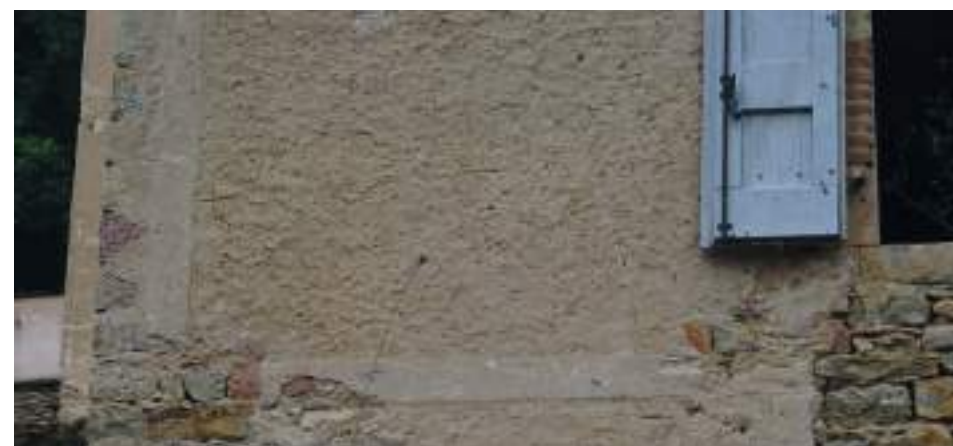
Différence de texture, enduit brossé pour le fond et lissé pour le décor.
