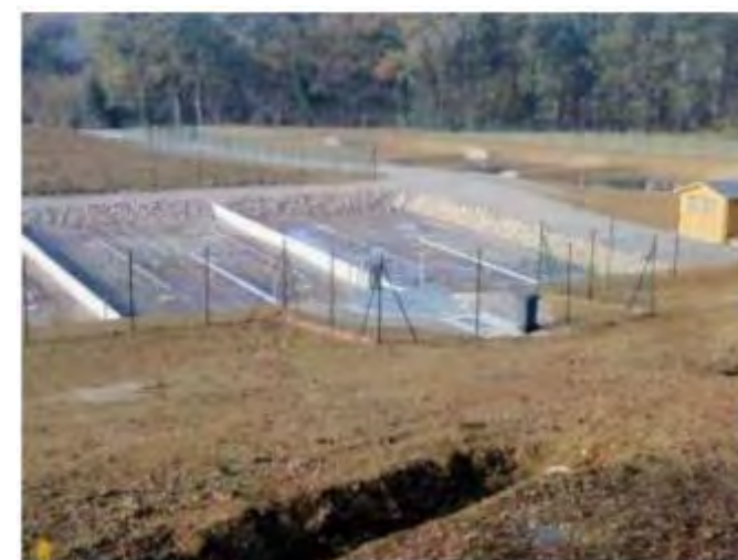
Photographie de la station d'épuration (Source : site internet de Giroussens)
