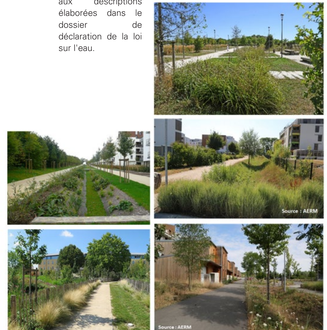
Figure 3 : Exemples d'aménagements de voies douces, de noues végétalisées et de bassins d'orage
