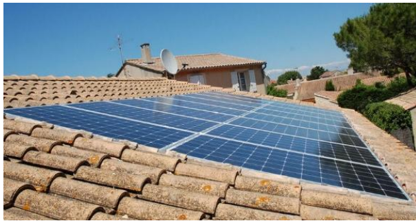
Intégration sur le plan de toiture
