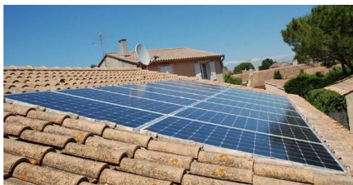
Intégration sur le plan de toiture
