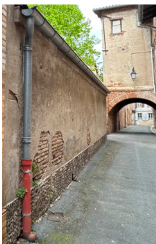
Exemples de chéneaux en zinc et dauphin en fonte
