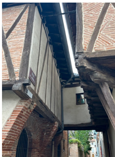
Pontet depuis la rue de l'Hirondelle
