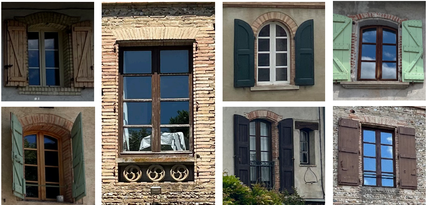
Exemples de menuiseries d'origine restaurées ou de menuiseries neuves respectueuses des dispositifs d'origine (formes et matériaux).
