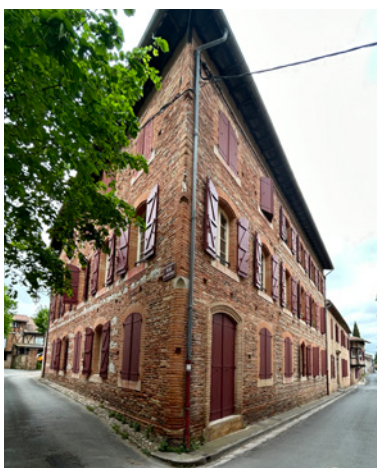
Beaux exemples de modes constructifs en pan de bois, maçonnerie de brique de terre cuite ou maçonnerie mixte avec galets typiques de Lisle-sur-Tarn
