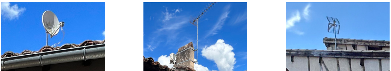
Quelques exemples d'éléments techniques en toiture visibles depuis l'espace public
