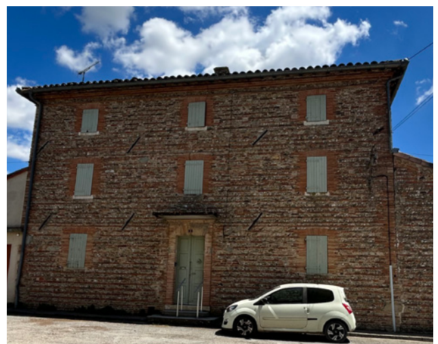
Beaux exemples de modes constructifs présents dans la zone 2 des faubourgs (pan de bois, maçonnerie brique de terre cuite, maçonnerie briques et galets).
