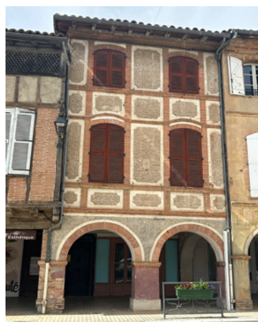
Beaux exemples de modes constructifs en pan de bois, maçonnerie de brique de terre cuite ou maçonnerie mixte avec galets typiques de Lisle-sur-Tarn
