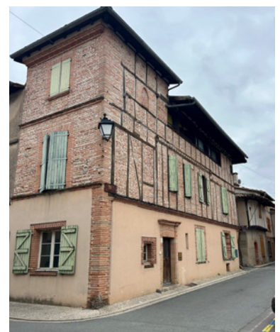
Beaux exemples de modes constructifs en pan de bois, maçonnerie de brique de terre cuite ou maçonnerie mixte avec galets typiques de Lisle-sur-Tarn
