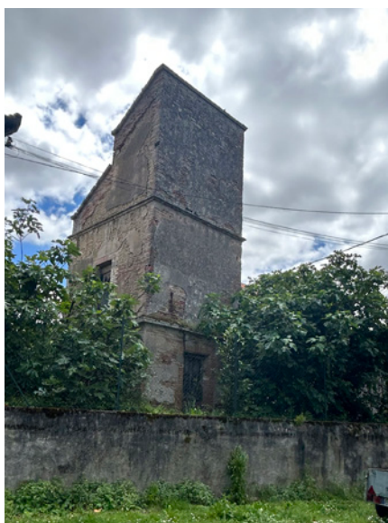
Pigeonnier visible depuis la rue des Promenades
