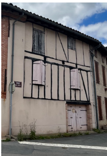
Beaux exemples de modes constructifs présents dans la zone 2 des faubourgs (pan de bois, maçonnerie brique de terre cuite, maçonnerie briques et galets).
