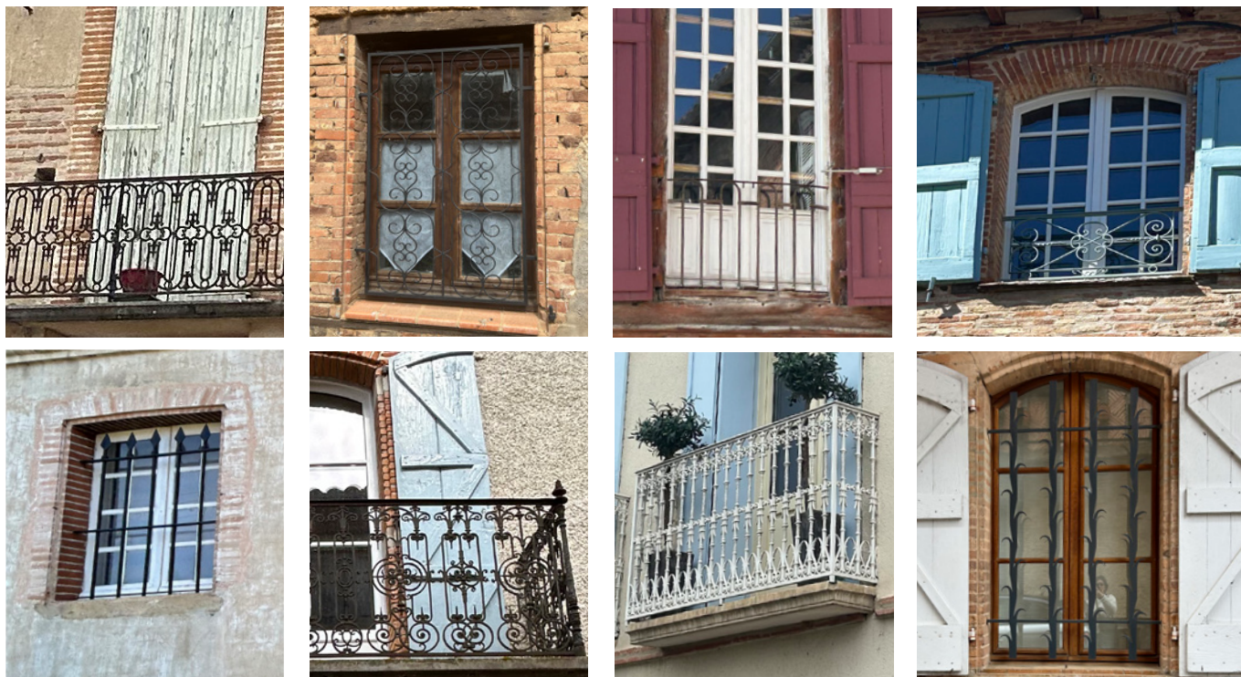
Exemples de ferronneries en garde-corps de balconnets et balcons et en grilles de protections de baies qui participent aux valeurs patrimoniales remarquables et intéressantes dans la bastide.
