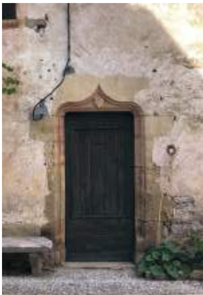
Des portes anciennes de qualité, dont la menuiserie s'adapte à la forme du linteau à préserver. Le bois nécessite une finition peinte
