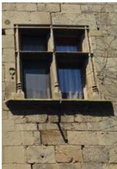
Deux exemples de baies dont la menuiserie respecte la forme du linteau et la date de construction de l'édifice
