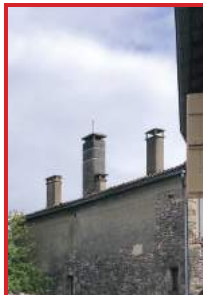
Cheminées avec enduit ciment : à éviter
