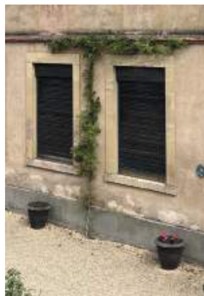
Volets roulants et coffres apparents en PVC : proscrit
