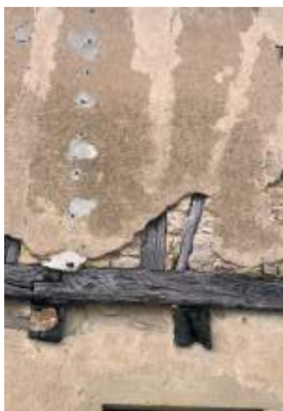
Des pans de bois avec des traces d'enduit ancien : à préserver et restaurer
