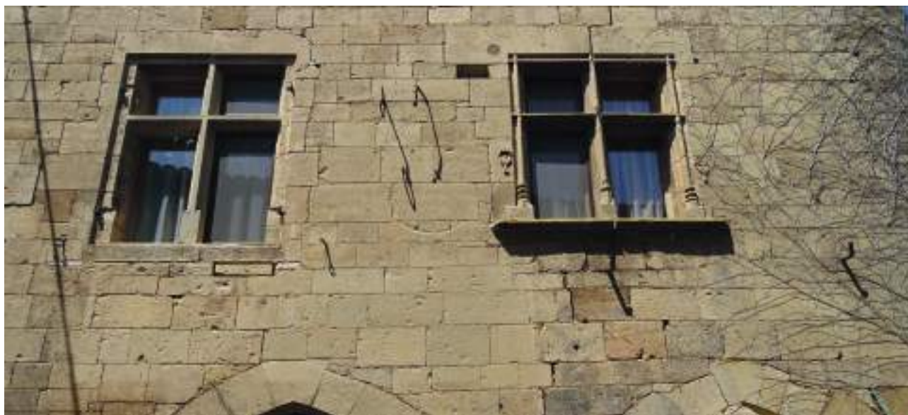
Maçonnerie en pierre de taille, destinée à rester apparente
