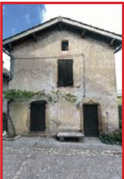
Des exemples de planches de rives en métal ou en bois brut : à éviter
