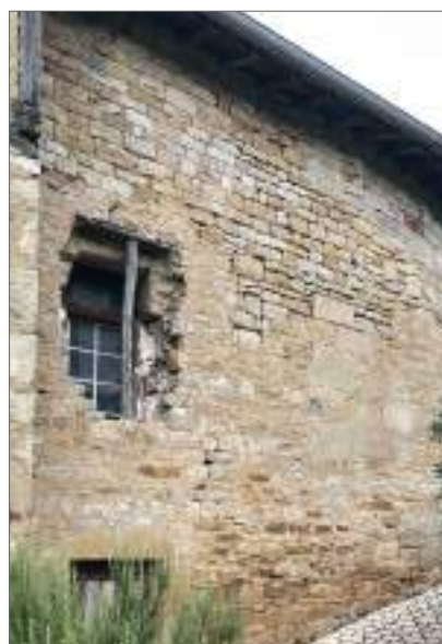
Des traces d'enduit ancien, prouvant que la maçonnerie en moellons de pierre était bien destinée à être enduite : à préserver et restaurer
