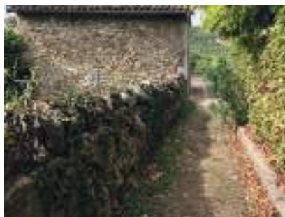
Les murs et murets en pierres sèches dans le bourg de Larroque
