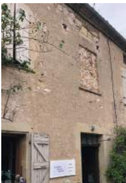
Exemples de baies anciennes comblées à ré-ouvrir
