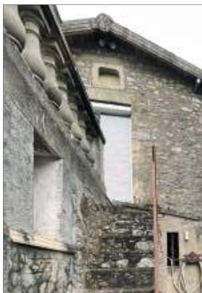
Volets roulants et coffres apparents en PVC : proscrit
