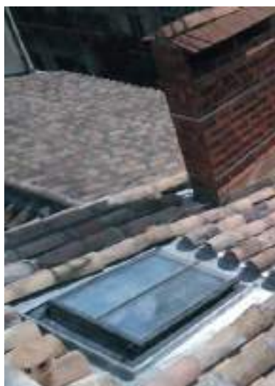
Insertion de châssis de toiture de dimensions réduites dans une toiture en tuile canal (Bordeaux et Montpellier)
