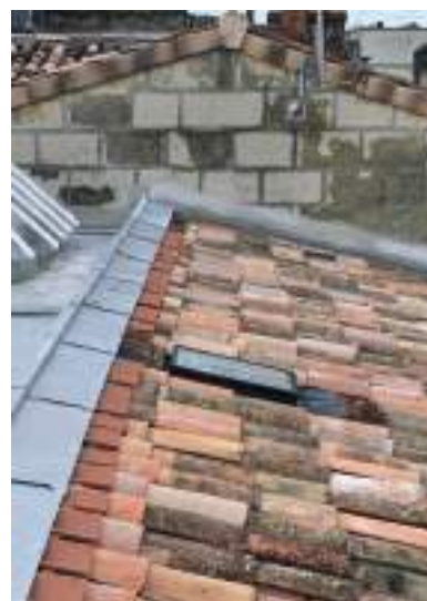
Insertion de châssis de toiture de dimensions réduites dans une toiture en tuile canal (Bordeaux et Montpellier)
