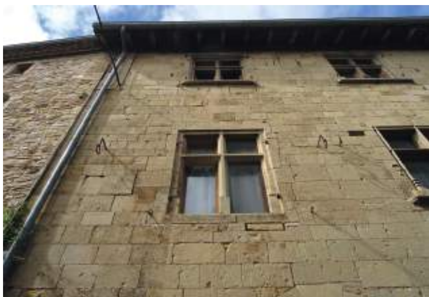
Maçonnerie en pierre de taille, destinée à rester apparente
