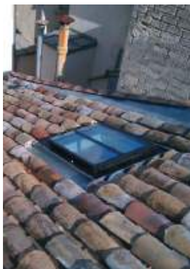
Insertion de châssis de toiture de dimensions réduites dans une toiture en tuile canal (Bordeaux et Montpellier)
