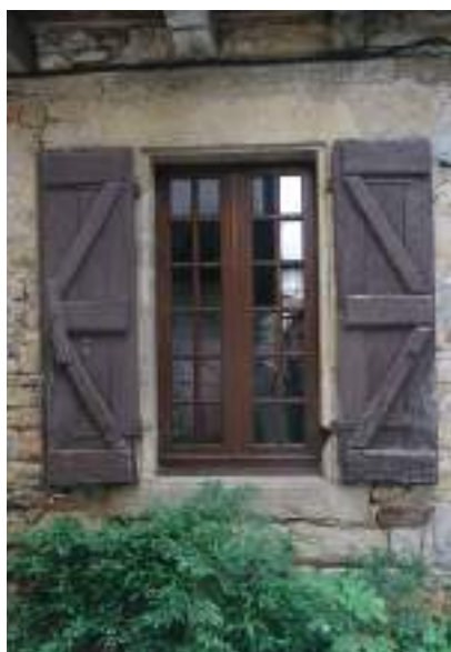
Contrevent à écharpes en bois avec menuiseries à petits carreaux
