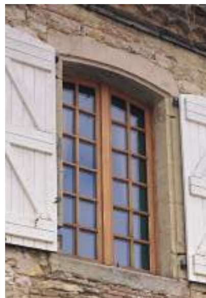
Une menuiserie à petits carreaux et respectant l'arc segmentaire mais dont le bois doit être peint
