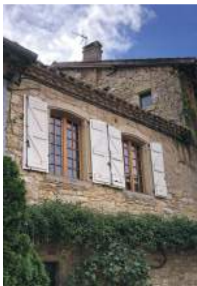
La génoise, un dispositif de couronnement à préserver
