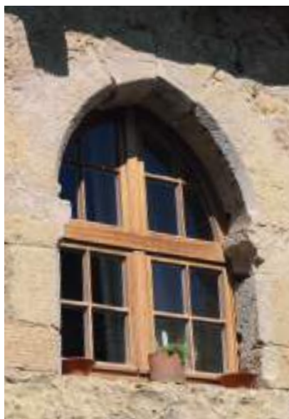
Deux exemple de menuiseries respectant la forme de la baie mais dont le bois doit être peint
