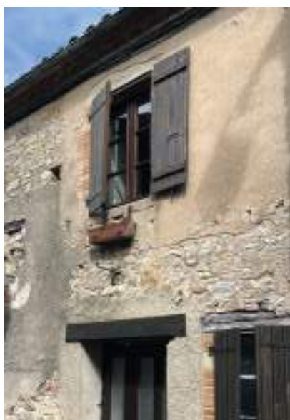
Des traces d'enduit ancien, prouvant que la maçonnerie en moellons de pierre était bien destinée à être enduite : à préserver et restaurer
