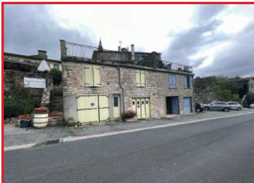
Un exemple de toiture-terrasse sur du bâti ancien : proscrit sur les constructions remarquables et intéressantes
