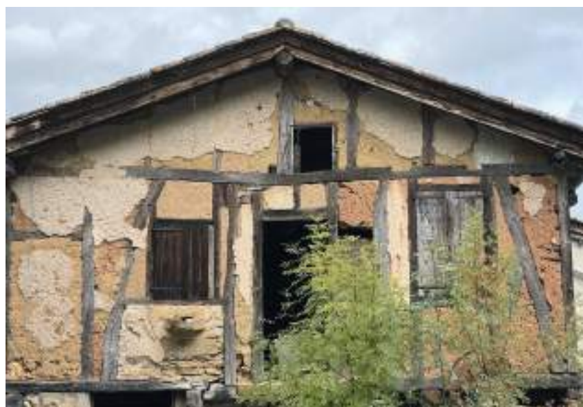
Des pans de bois avec des traces d'enduit ancien : à préserver et restaurer
