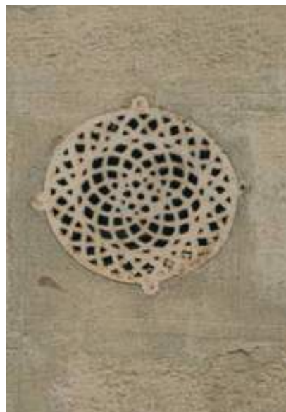
Exemples de bouches de ventilation en façade dissimulée par une grille ouvragée
