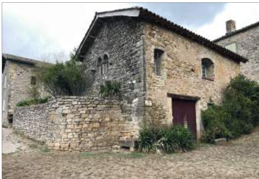
Maçonnerie en moellons de pierre avec des traces d'enduit ancien
