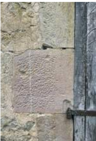
Encadrement des baies en pierre de taille
