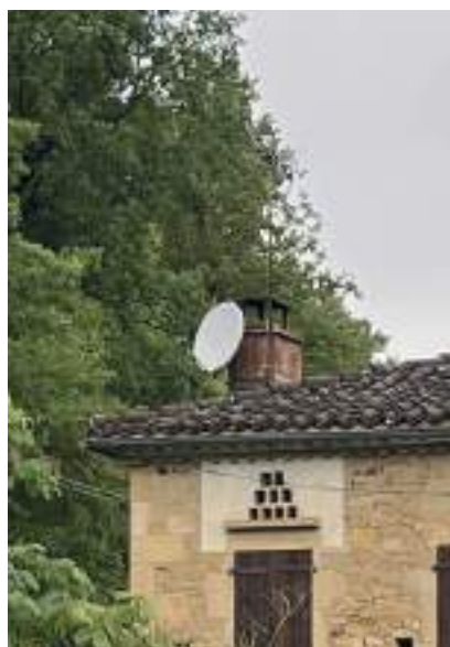
Conduit de cheminée ancien à préserver
