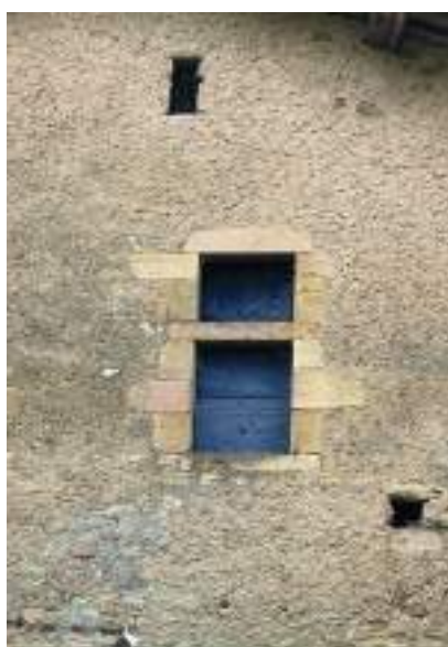
Encadrement en pierre de taille et enduit ancien d'une maison forte
