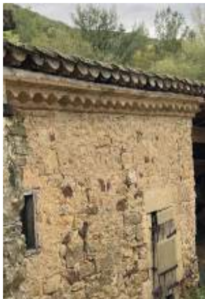
Conduit de cheminée ancien à préserver
