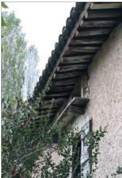
Des débords de toit à préserver
