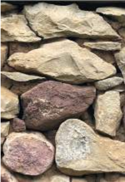
Maçonnerie en moellons de pierre
