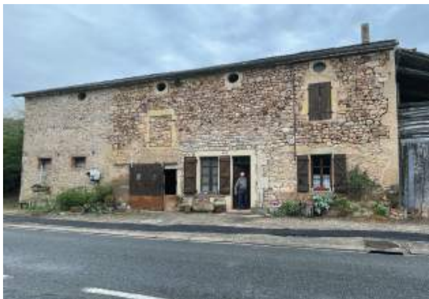
Une ferme du XIXe siècle destinée à être enduite, en témoignent les traces d'enduit ancien autour des encadrements en pierre de taille
