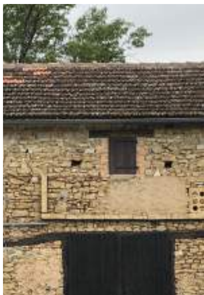
Toit avec tuiles à emboîtement
