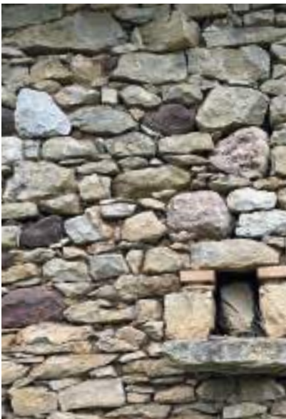
Maçonnerie en moellons de pierre
