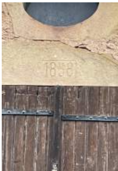
Une ferme du XIXe siècle destinée à être enduite, en témoignent les traces d'enduit ancien autour des encadrements en pierre de taille
