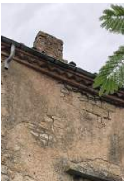
Ancienne cheminée en briques à préserver et restaurer
