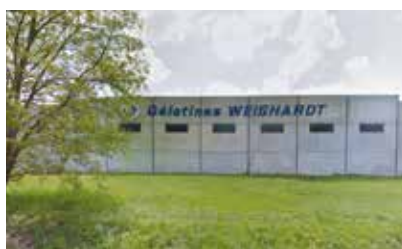
Réduction des consommations d'énergies Centrale de cogénération au gaz naturel de l' entreprise Weishardt pour produire : • Chaleur et vapeur d'eau pour les besoins de l'entreprise • Électricité en réutilisant la vapeur d'eau pour la consommation du site et revente à EDF
