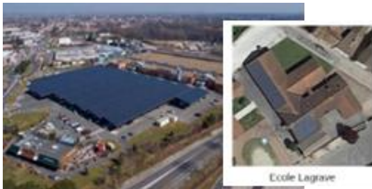
Parking du centre commercial de Gaillac École de Lagrave
