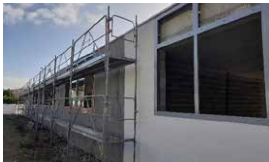
Isolation thermique par l'extérieur
