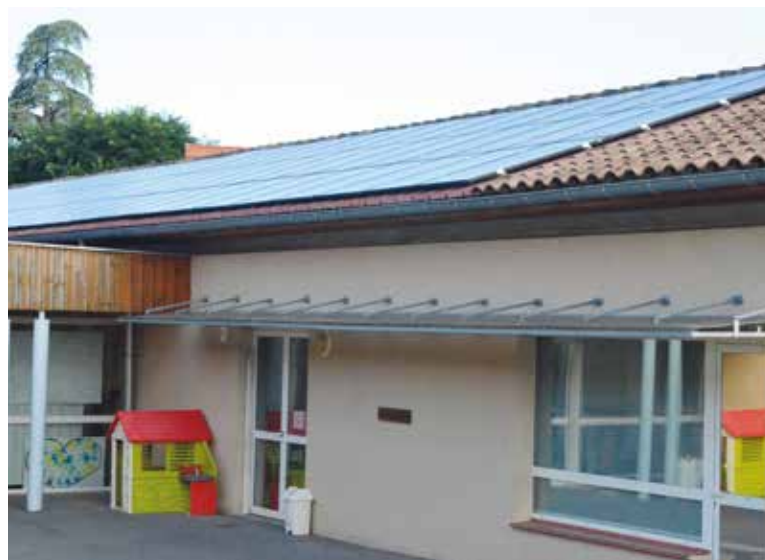
Panneaux photovoltaïques école de Cahuzac
