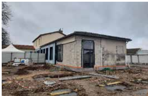
Réalisation des fondations du futur préau
