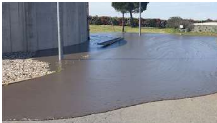
Ecoulement des boues dans la station
