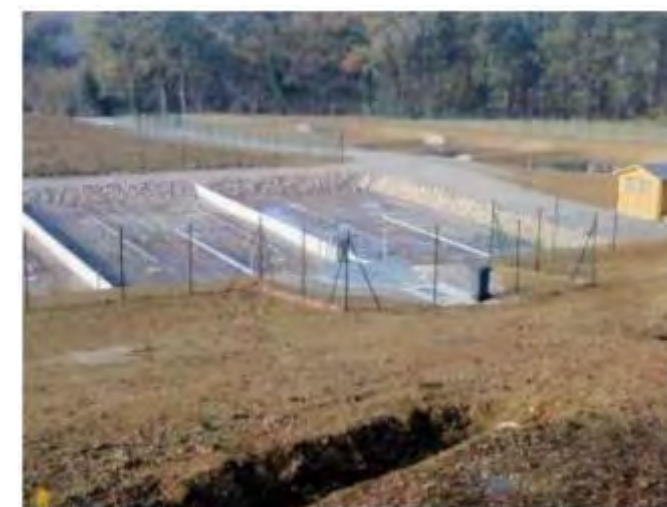
Photographie de la station d'épuration (Source : site internet de Giroussens)
