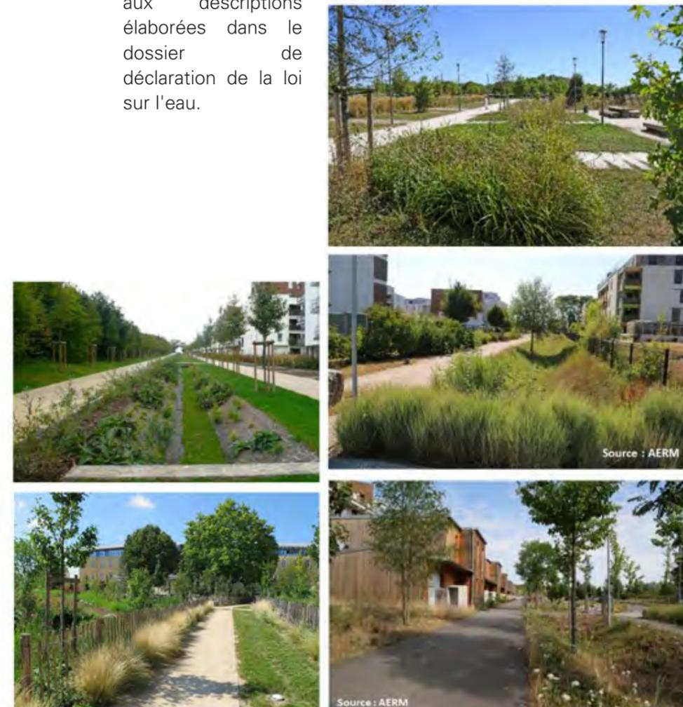
Figure 3 : Exemples d'aménagements de voies douces, de noues végétalisées et de bassins d'orage
