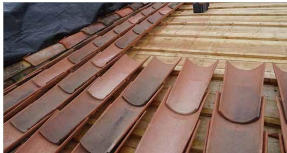
Tuiles de courant : accrochage des tuiles neuves à talon sur des liteaux.
