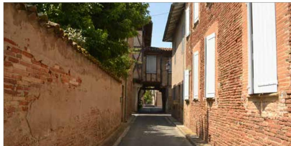
Mur en briques enduit avec couronnement en tuile canal mono-pente
