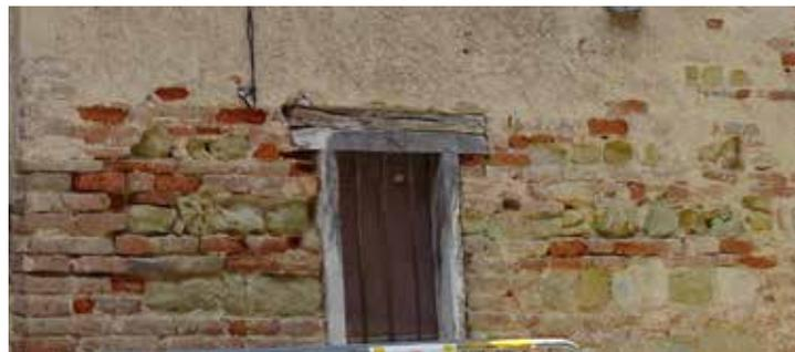
Remplissage mixte en briques de terre cuite et de moellons de galets. Les assises semblent régulières avec une alternance de briques et de galets.
