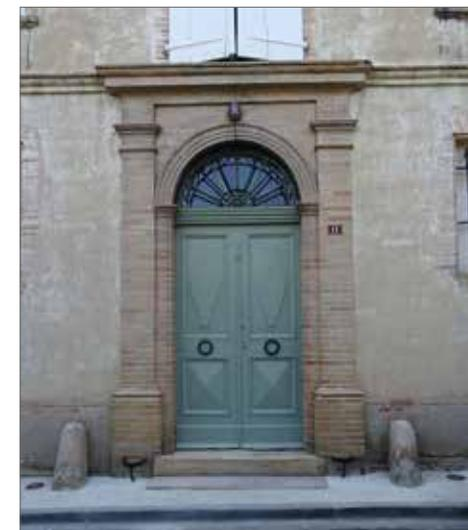
Enduit à la chaux ton sable. Les éléments en relief ont un badigeon plus foncé
