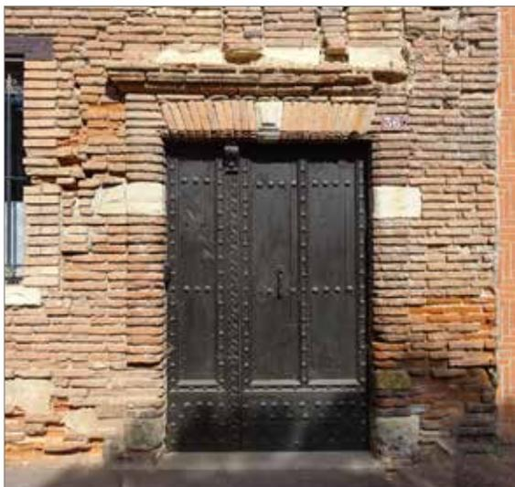
Encadrement saillant surmonté d'une corniche, clé en pointe de diamant en pierre de taille, rue Etienne Compayre
