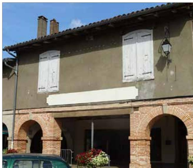
La façade en pans de bois de l'étage est totalement enduite avec un recouvrement de l'ossature en bois
