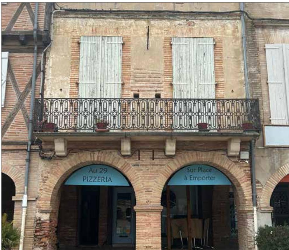
Balcon filant à l'étage noble avec garde-corps en fonte moulé à motifs
