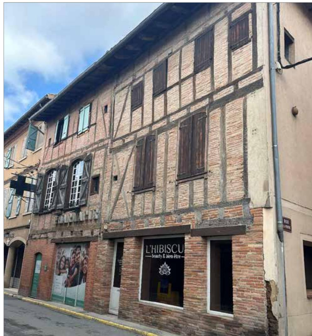
Maisons remontées au XIXème siècle. La façade des étages alignée au rez-de-chaussée maçonné semble avoir été remaniée à cette époque avec la suppression des encorbellements probablement par sciage des solives et reconstruction en retrait d'une façade à ossature à grille
