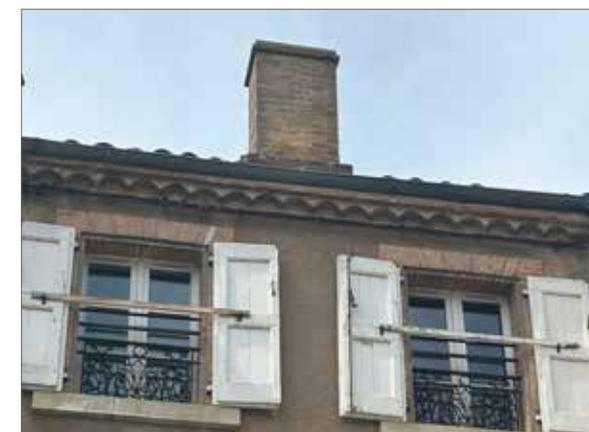
Débord de toiture sur façade maçonnée avec généoise à un rang
