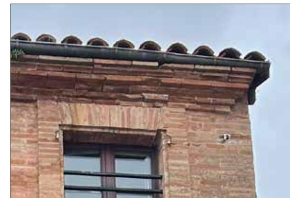
Débord de toiture sur façade maçonnée avec corniche à cinq rangs de briques
