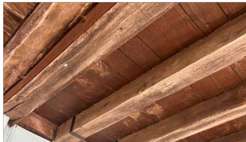
Sous-face de portique et d'encorbellement en platelage bois à lames perpendiculaires aux solives
