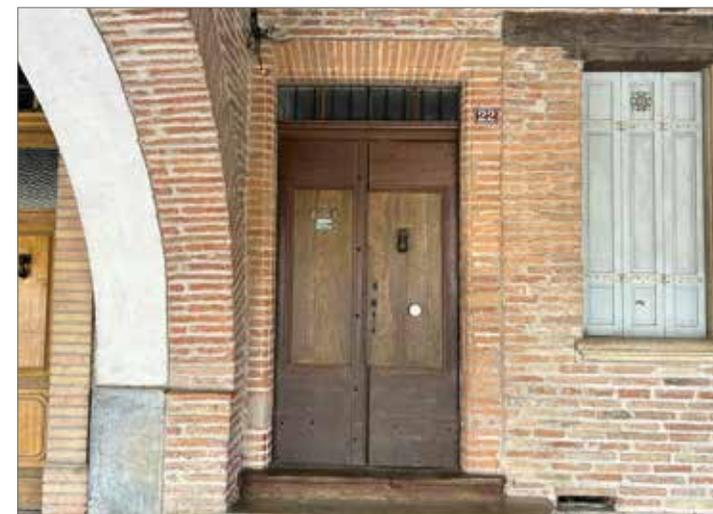
Porte bâtarde : vantaux à cadre avec imposte vitrée protégée par des barreaux en fer verticaux
