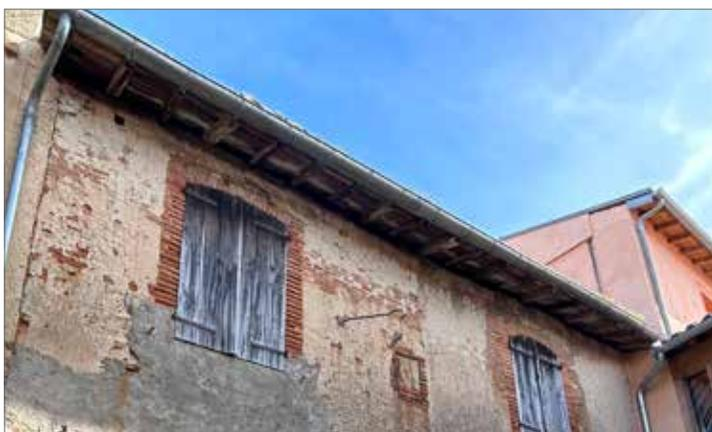
Simple débord de toiture sur chevrons posés sur panne sablière ou encastrés dans le mur maçonné
