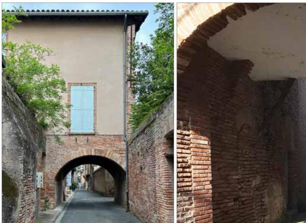
Pontet en maçonnerie au niveau de la rue Achille Gaillac Consoles en briques portant le plancher
