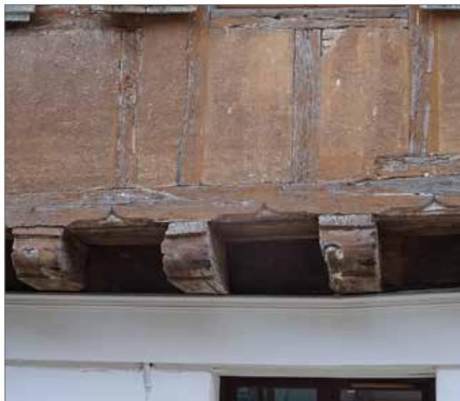
Façade en pans de bois totalement enduite avec une différence de traitement entre le remplissage et l'ossature. Le remplissage entre les éléments de structure reçoit un enduit couvrant tandis que l'ossature en bois semble avoir été badigeonnée dans la même teinte ou recouvert d'une épaisseur moins importante d'enduit
