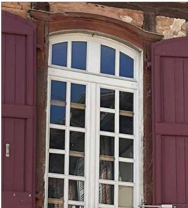
Encadrement de fenêtre de demi-croisée avec moulures à bagues de section circulaire, appui mouluré taillé en biseau
