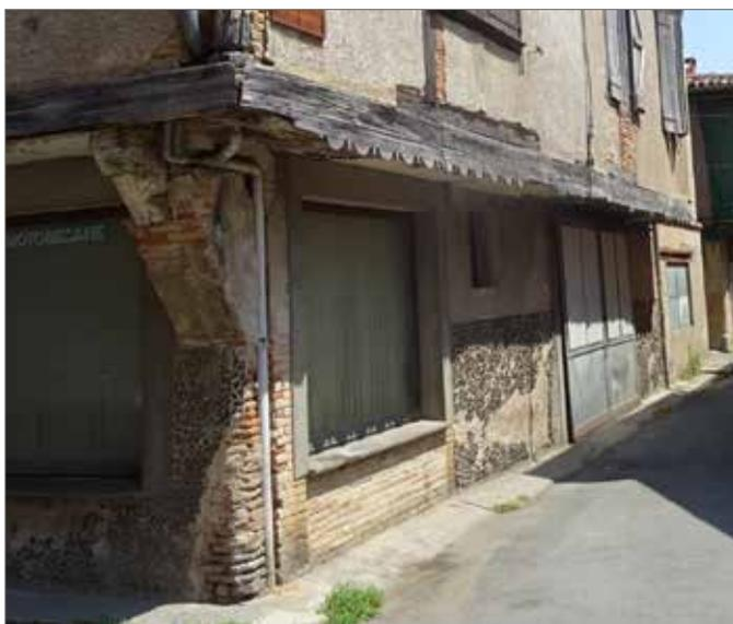
Incrustation de petites pierres dans un enduit à la chaux sur le socle maçonné de la maison.
