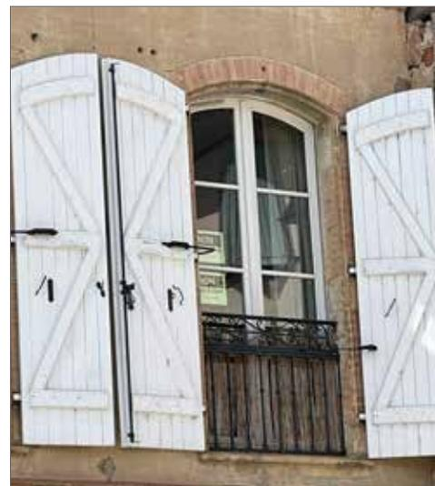
Garde-corps de porte-fenêtre à barreaux et barre d'appui en fonte mouluré à motifs à courbes
