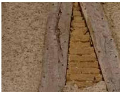
Remplissage en adobe, briques de terre crue, mis à mal par un enduit ciment projeté à la tyrolienne
