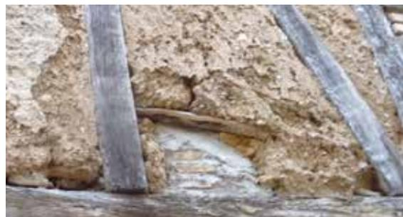
Paillebart : remplissage en torchis composé d'un mélange de terre et de paille sur une ossature à traverses bois, reste d'un enduit ciment
