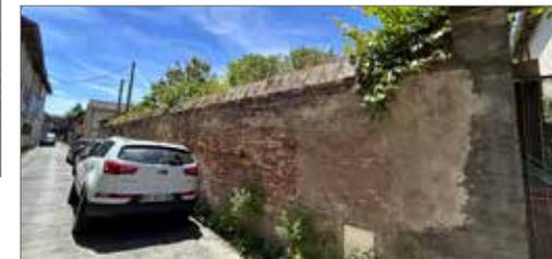
Mur en briques à chaperon en en briques à deux pans symétriques
