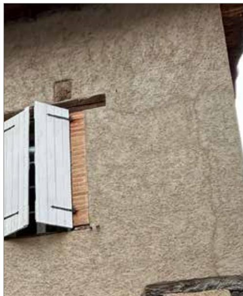
Enduit à la chaux ton sable à finition granuleuse. A gauche : arrêt droit de l'enduit avec mortier de finition de la même couleur que l'enduit. A droite : arrêt droit de l'enduit autour des chambranles en bois de l'étage
