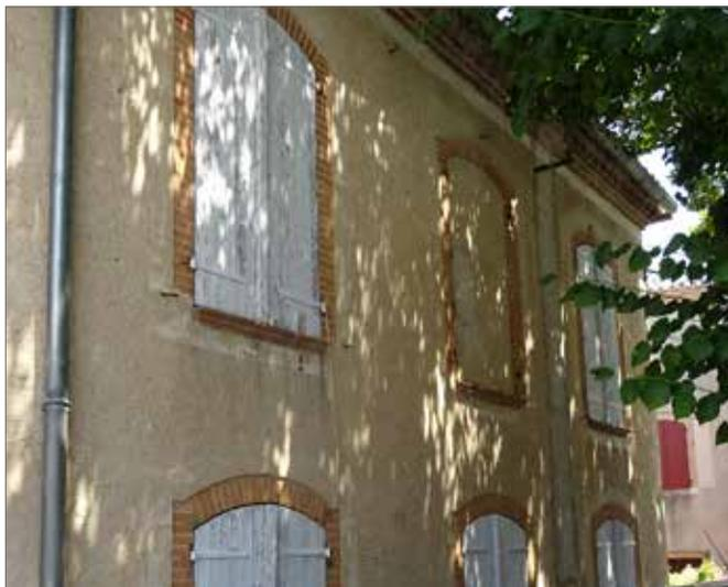
Musée Lafage : Le parement en brique est couvert d'un enduit ton sable rehaussé d'un badigeon crème pour marquer le bandeau, les chaînes d'angle et les encadrements des baies. Ce traitement avec un premier cadre laissé en brique et un second tracé au badigeon est caractéristique de la ville
