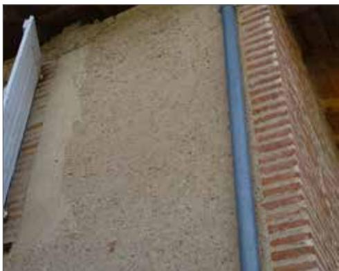
Enduit granuleux avec arrêt droit à l'angle du mur. Le mortier et l'enduit sont de la même teinte
