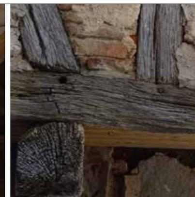
Assemblage à tenon et mortaise laissant apparaître les chevilles. A gauche : liaison entre le poteau cornier et les aisseliers. A droite : liaison entre la sablière de plancher et un potelet et décharge à écharpe
