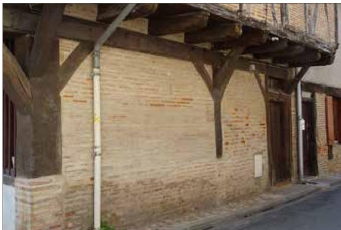
Badigeon clair non couvrant sur la surface maçonnée du rez-de-chaussée de la façade
