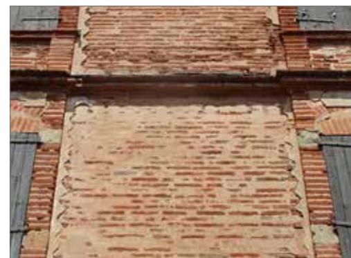
Restes de décor d'enduit en relief des pleins de travée. Arrêt droit de l'enduit autour de l'encadrement
