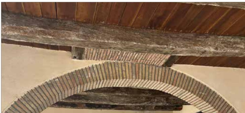
Deux exemples de traitement des dessous de chevêtre de cheminée : mise en œuvre d'un remplissage maçonné en briques / en pierre.
