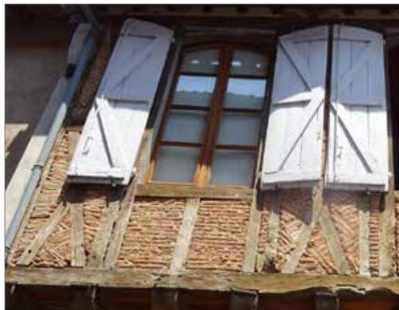
Exemples de constructions avec un remplissage soigné en briques de terre cuite formant des motifs de chevrons, façades n'étant pas destinées à être enduites
