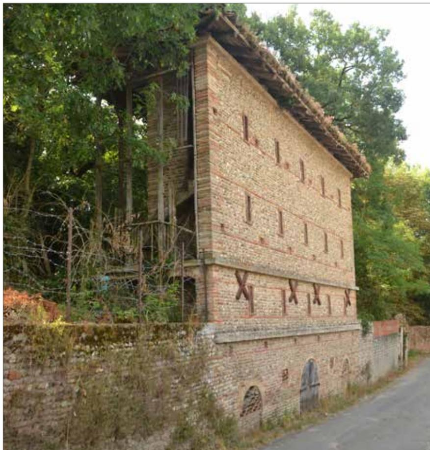
Pigonier construit en maçonnerie mixte de briques et galets avec claustras en tuiles canal, Rue de l'Enclos
