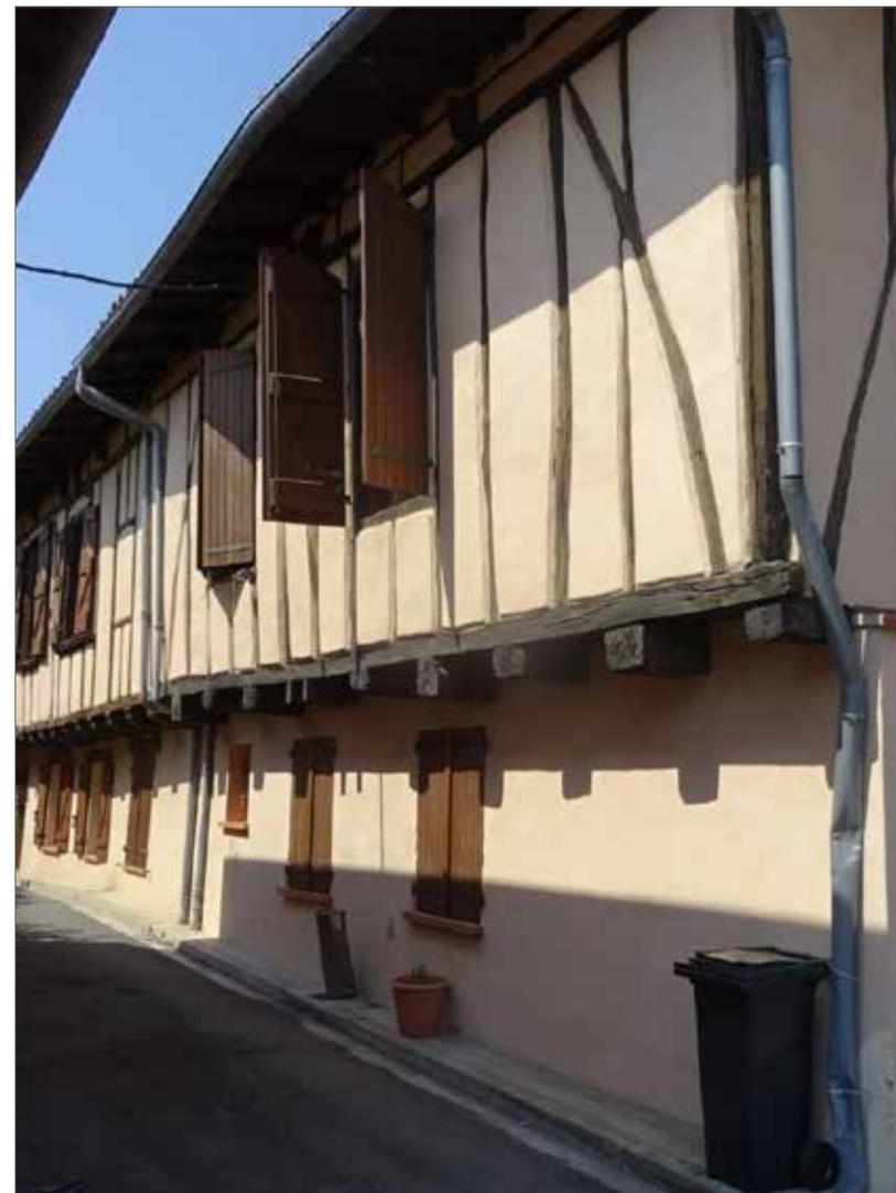
Façades totalement enduites (RDC et étages en pans de bois), l'enduit est appliqué à l'étage uniquement sur le remplissage entre les éléments de l'ossature en bois.
