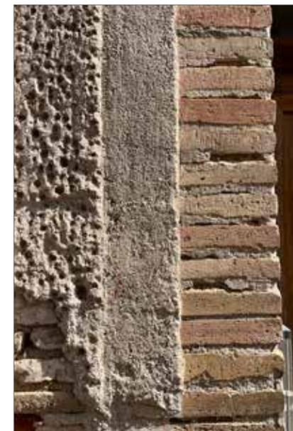
Enduit crème des travées et motifs de table réalisés avec un enduit ton sable texturé avec des sarments de vigne se détachant sur un enduit lissé plus clair.
