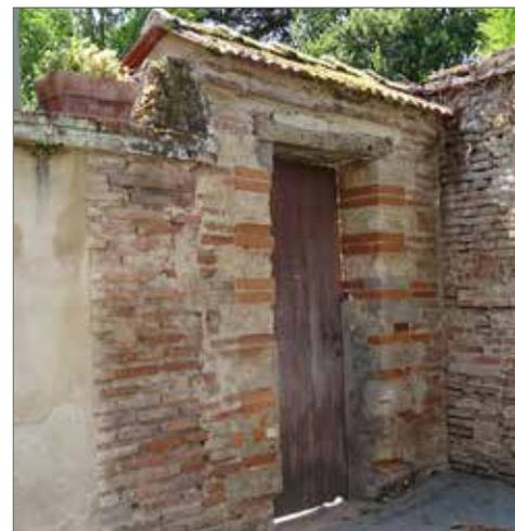
Mur de clôture en briques avec chaperon à deux rangs de briques en débord. La porte d'entrée a un encadrement brique / pierre et linteau en bois. Elle est couverte d'un chaperon en tuile à deux pans symétriques
