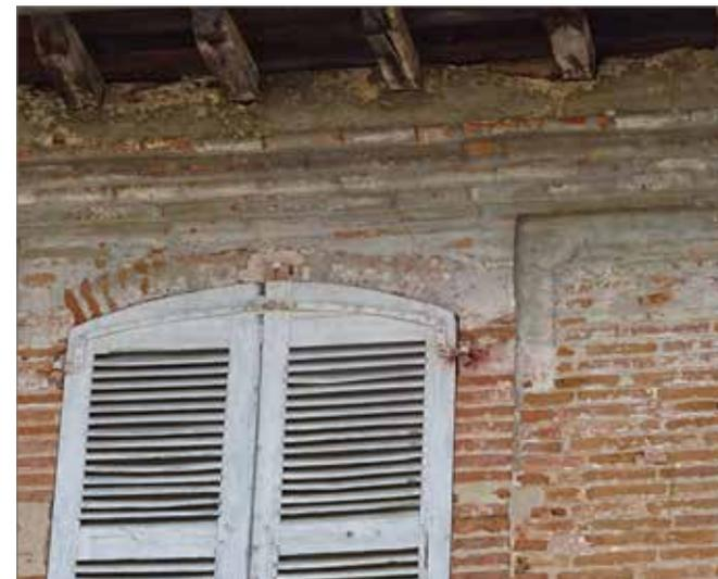
Les traces d'un décor d'enduit en relief avec un motif en quart de rond aux angles des pleins de travées sur la demeure Place Paul Saissac. Un badigeon gris venait masquer l'enduit et les parements en brique
