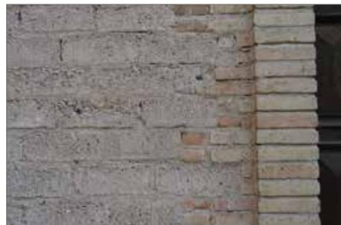
Maçonnerie en briques de béton de chaux redécouverte dans le Tarn dans le 2<sup>ème</sup> quart du XIX<sup>ème</sup> siècle
