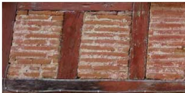
Remplissage entre poteaux en briques de terre cuite destinées à être enduite or recevant un badigeon, construction remontée au XVIIIe
