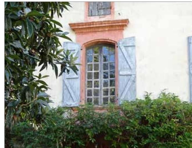
Maison viticole ( ? ) sur l'Allée des Promenades : enduit ton sable et badigeon teinté à la poudre de brique sur les encadrements (unification de la teinte des briques et des joints)
