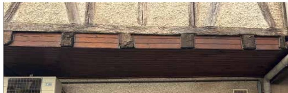
La sous-face de l'encorbellement est habillé d'un lambris couvrant les solives et masquant partiellement la lecture de la structure de l'encorbellement
