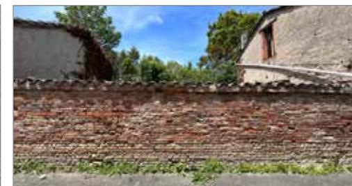
Mur en briques et galets à chaperon en tuile canal mono-pente
