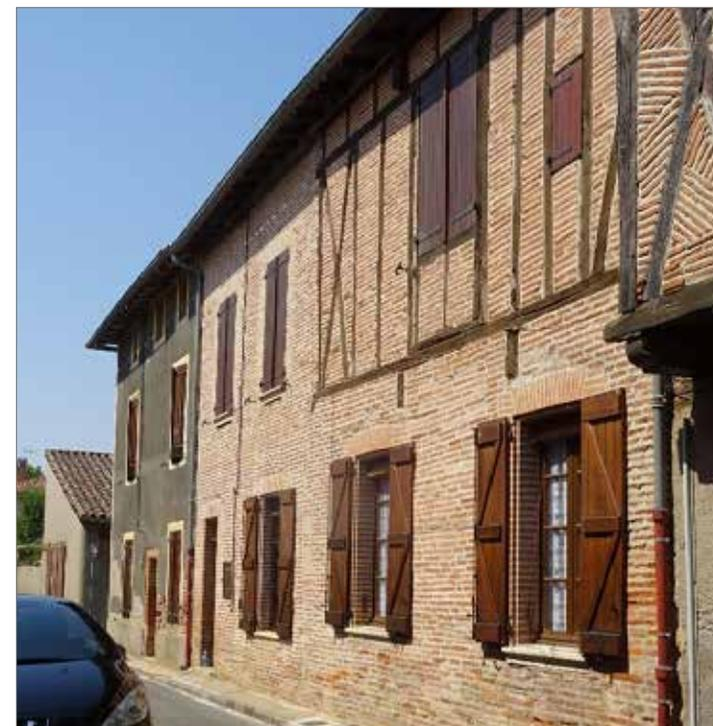
Maison rue Raymond Lafage : la façade a été reconstruite en réutilisant pour partie les bois de l'ancien colombage. Dans ce cas de figure, il semblerait que l'on soit sur une reconstruction complète de la façade avec édification d'un rez-de-chaussée maçonné et remontage du pan de bois.
