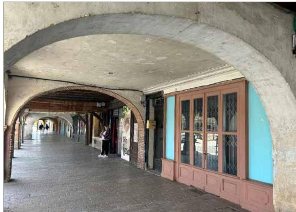
Exemple de maisons à couverts où la sous-face du portique est recouvert par un lattis plâtre de sorte à masquer la structure du plancher de l'étage et à donner une isolation à la pièce vie principale au dessus du portique
