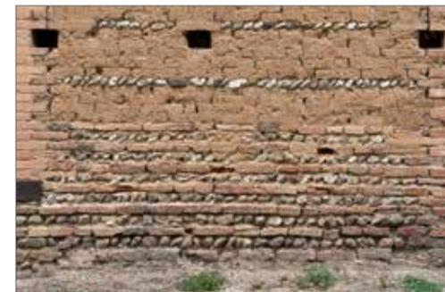
Maçonnerie mixte associant en partie basse au contact du sol en briques de terre cuite et galets, en partie haute de l'adobe
