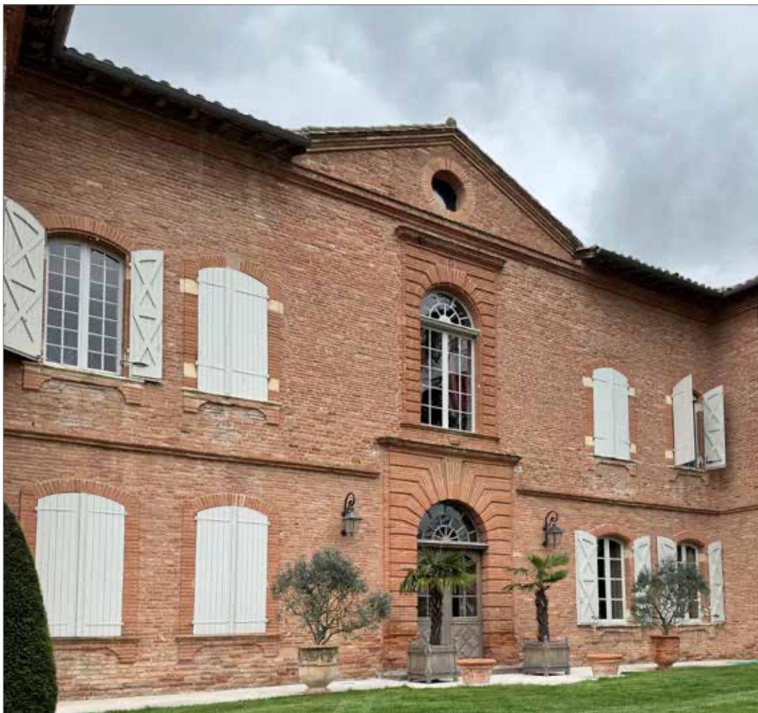
Façade début 19e maçonnerie briques destinée à être enduite
