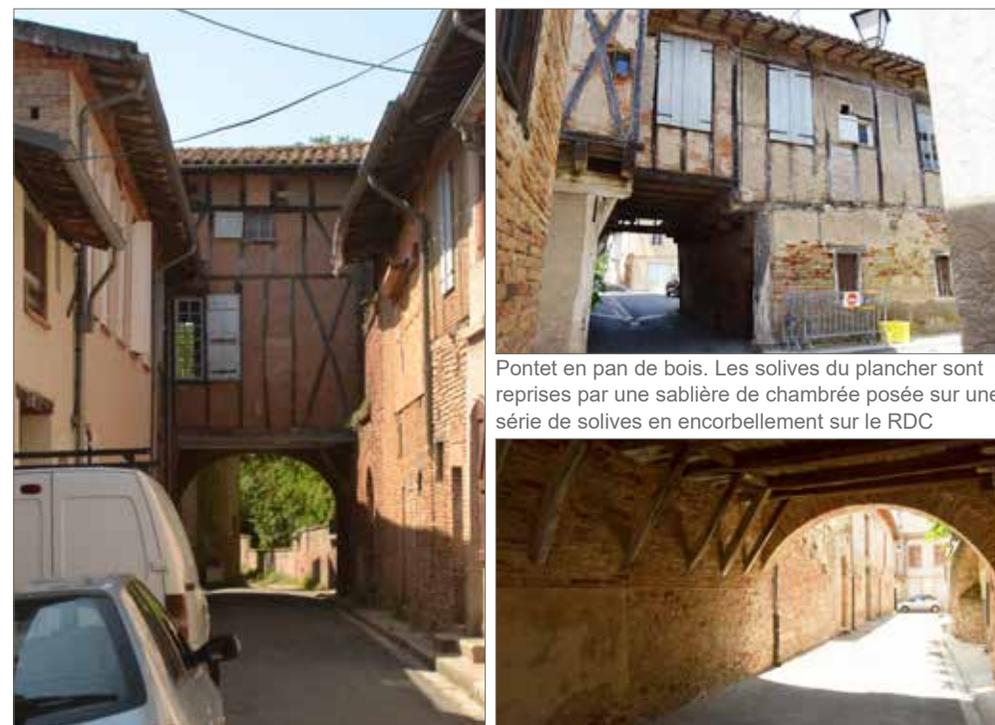
Pontet en pan de bois porté par des aisseliers en bois appuyés sur les murs du RDC maçonné
