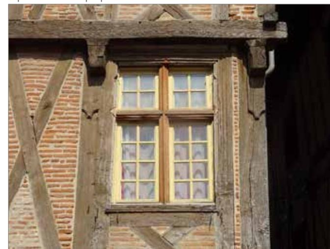
Fenêtre à croisée en bois à meneaux et poteaux de fenêtres moulurés. Pièce d'appui en bois sculpté
