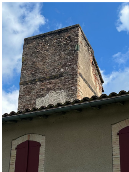
Pigeonnier visible depuis l'Allée des Promenades,
