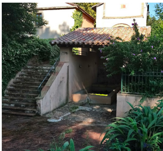
Lavoir de la place de Larmasse
