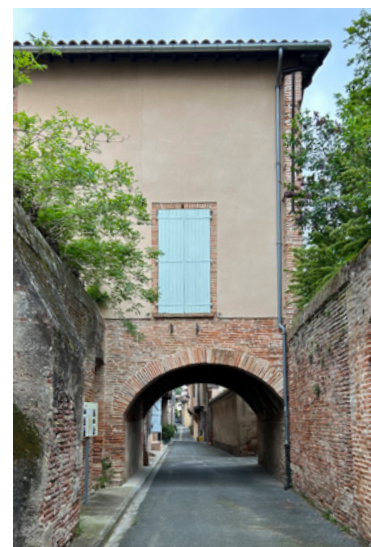
Pontet depuis la rue Achille Gaillac
