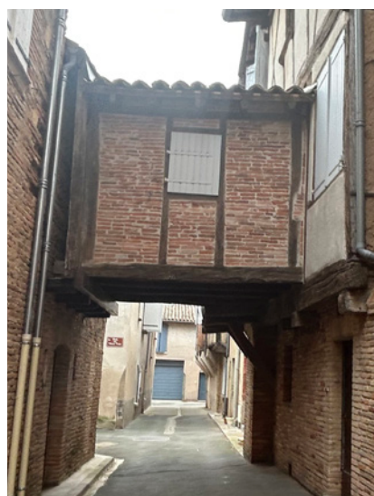
Pontet depuis la rue de la solitude
