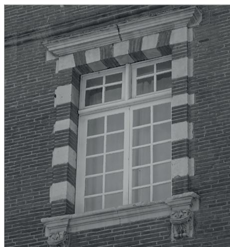
Suppression du meneau en partie basse. Gaillac, Tarn.
