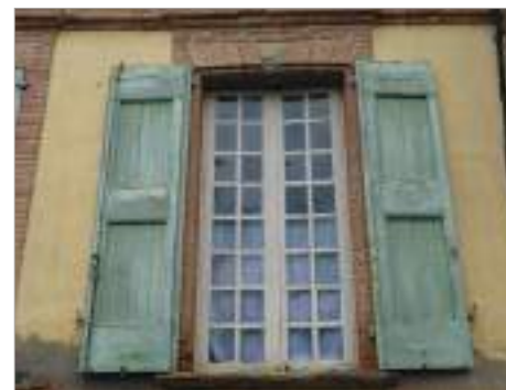
Fenêtre ouvrant à la française du XVIII ème siècle avec des verres de petite taille et contrevents à cadre.
