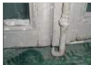
Crochet bas. L'espagnolette, organe de fermeture.
