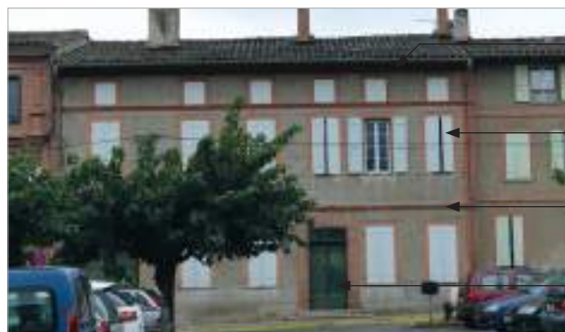
La façade est divisée par des cordons de plancher, mais les encadrements des percements sont affleurants. Place Saint-Michel.
