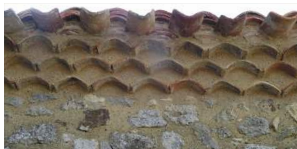
Obturation des canaux des tuiles de couvert par de la maçonnerie.
