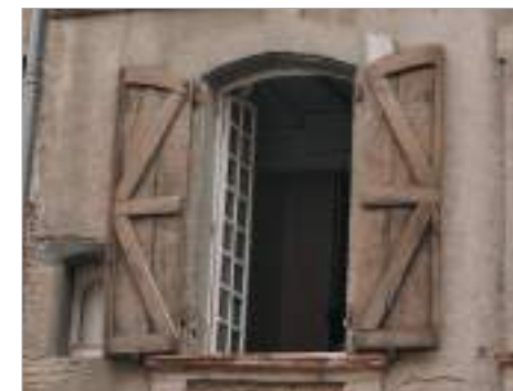
Fenêtre récente reprenant un modèle du XVIII ème siècle et contrevents à écharpes.
