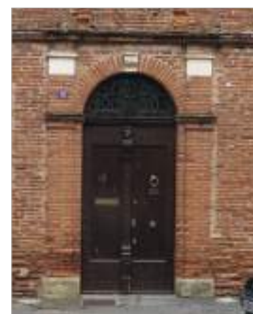
Même principe de pilastres soutenant une corniche mais la porte est en arc plein cintre. Utilisation de la pierre de taille.
