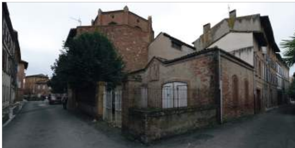
Muret en brique foraine enduite avec un chaperon horizontal formant larmier et surmonté d'une grille.
