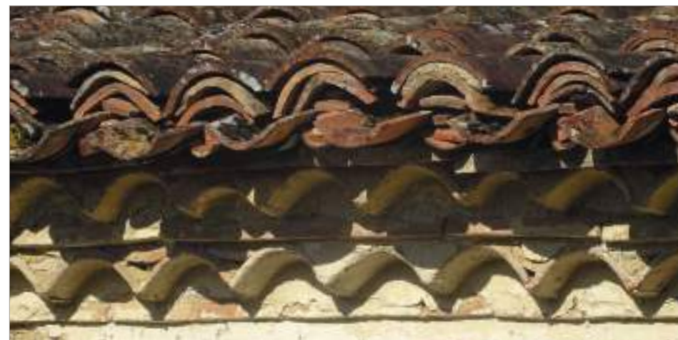
Obturation des canaux des tuiles de couvert par des casseaux de tuile.
