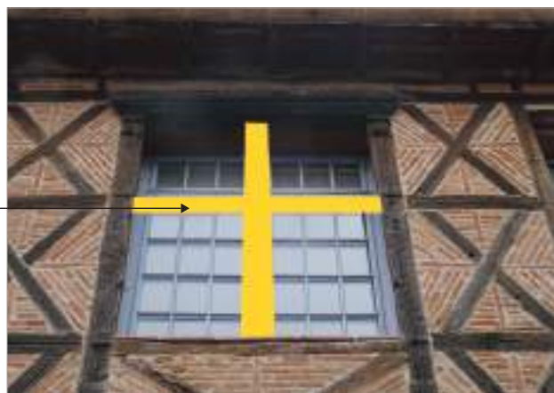
Pan de bois médiéval remonté sans encorbellement au XIX ème ou XX ème siècle. Rue des Pénitents Bleu.
