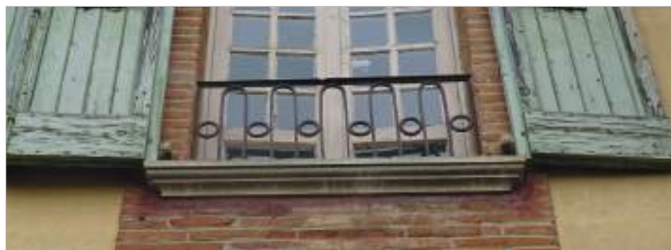
Garde-corps de fenêtres reprenant un motif d'épingle.
