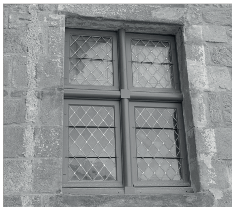
Traverse et meneau de section ½ ronde, restitution. Figeac, Lot
