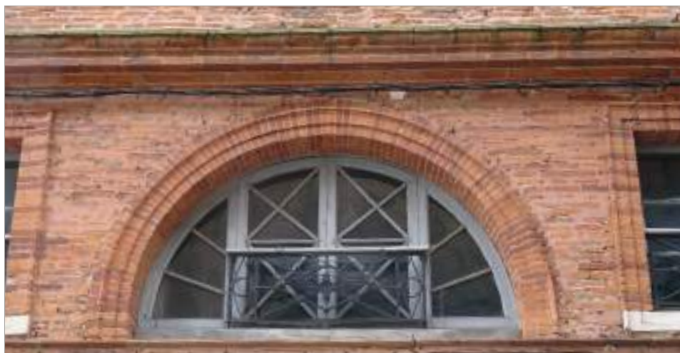
Au XIX ème siècle, les petits-bois peuvent former des motifs. Sur cette menuiserie des petits bois redécoupant le vitrage en diagonales.
