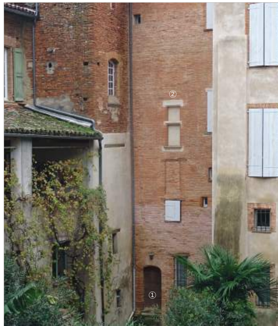
L'élévation en brique foraine conserve une porte piétonne en anse-de-panier (1) dont l'encadrement est chanfreiné. A l'étage, une demi-croisée (2) qui a été en partie refaite au XX ème siècle. L'appui, la traverse et le linteau sont bâtis en pierre de taille. L'arrête des deux compartiments est également abattue d'un chanfrein. Parcelle 1071
