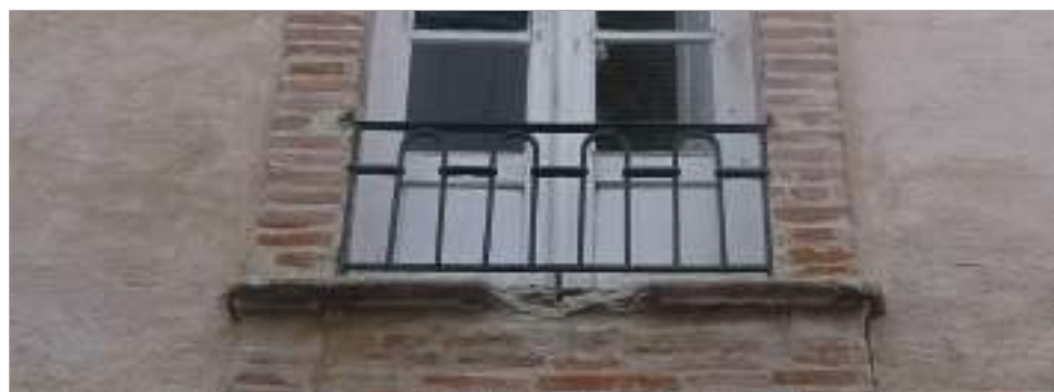
Garde-corps de porte-fenêtres reprenant un motif d'épingle.
