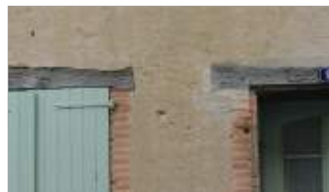
Arrêt droit de l'enduit, le mortier de finition et l'enduit sont de la même couleur.
