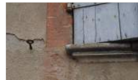
Sur ces différents exemples, l'enduit passé sur les éléments de décor architectural est badigeonné à l'ocre rouge.
