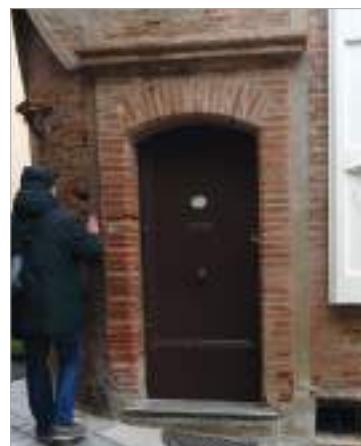
Ici, l'encadrement est saillant et le couvrement est surmonté d'une corniche.
