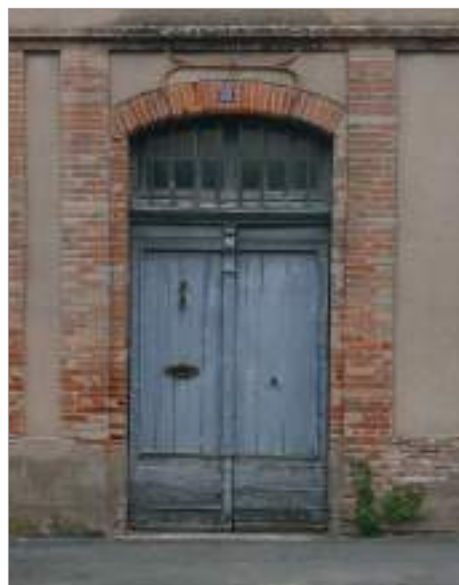
Porte bâtarde d'une maison bourgeoise : vantaux à cadre avec imposte vitrée protégée par des barreaux verticaux en fer de section carrée.
