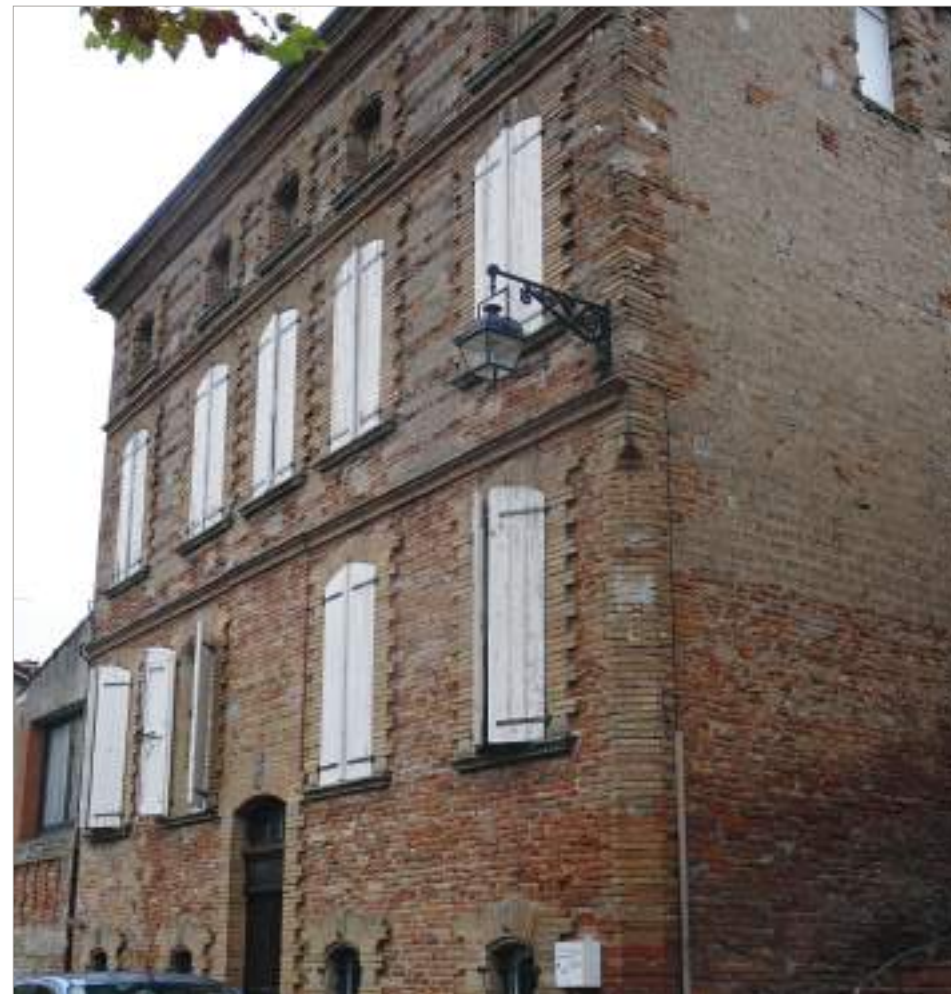
Le béton de chaux a remplacé la brique de terre cuite car c'est un matériau économique. Moins bien considéré et plus fragile il était destiné à être masqué.
