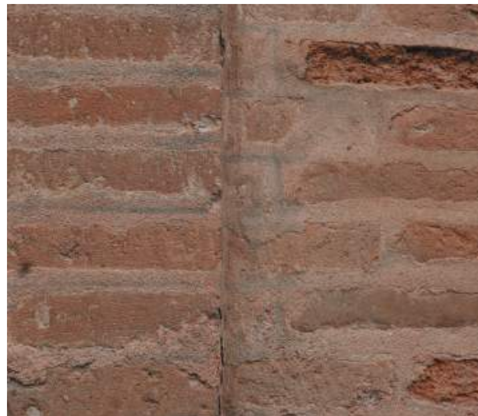
Détail des faux joints au badigeon gris.
