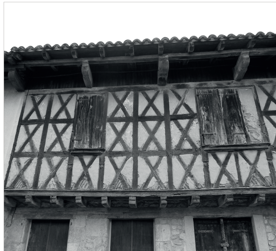
Débord de toit avec panne sablière en débord soutenue par des poutres. Touget, Gers.
