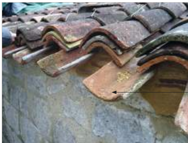
Mise en œuvre des tuiles à l'égout.
