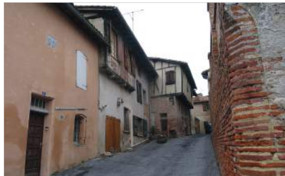
Façades rue du Plo.
