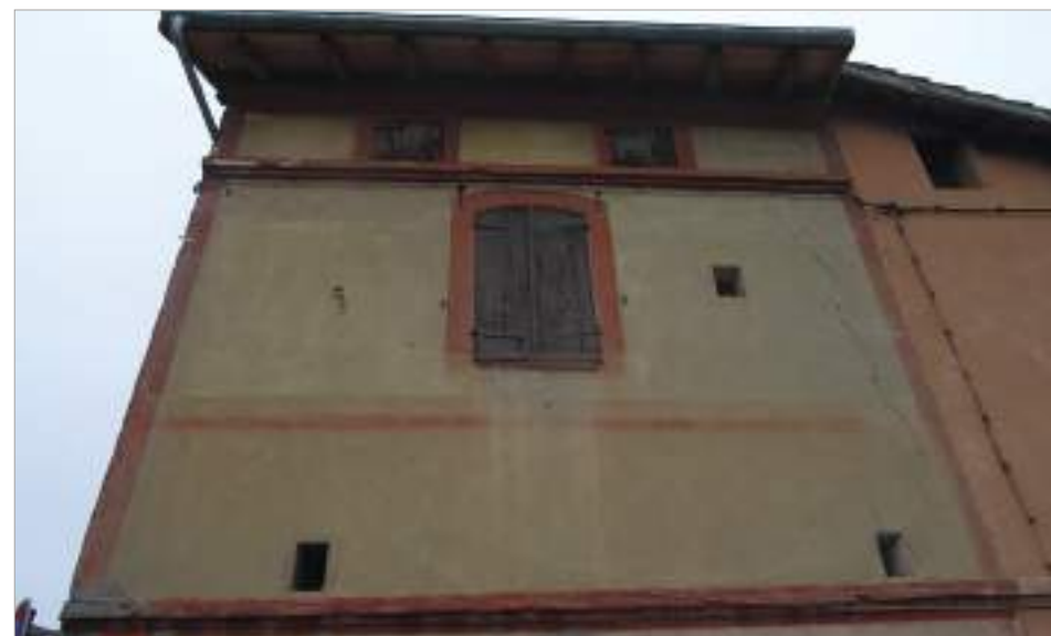
Sur ces différents exemples, l'enduit passé sur les éléments de décor architectural est badigeonné à l'ocre rouge.
