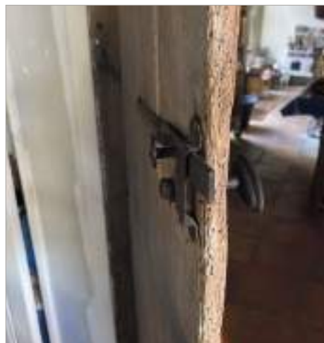
Clenche et bouton lève clenche sur platine.
