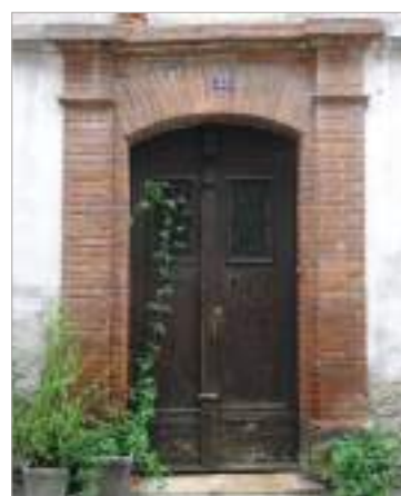
De part et d'autre de la porte des pilastres supportent une corniche. L'encadrement est simple, un abattement de l'arrête en chanfrein.
