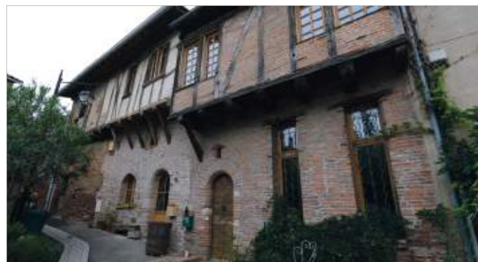
Structure mixte avec RdC et entresol bâtis en brique de terre cuite et pan de bois en encorbellement à l'étage. Place du Pont du Moulin.
