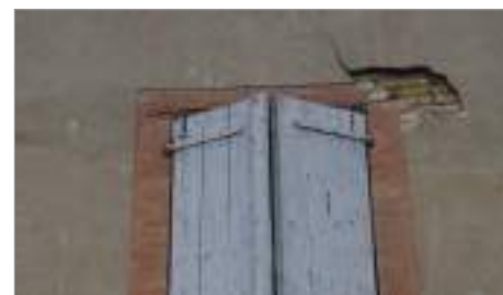
Sur ces différents exemples, l'enduit passé sur les éléments de décor architectural est badigeonné à l'ocre rouge.
