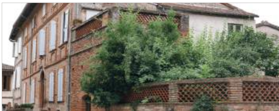
Claustra en partie haute d'un mur et comme garde-corps d'une terrasse.
