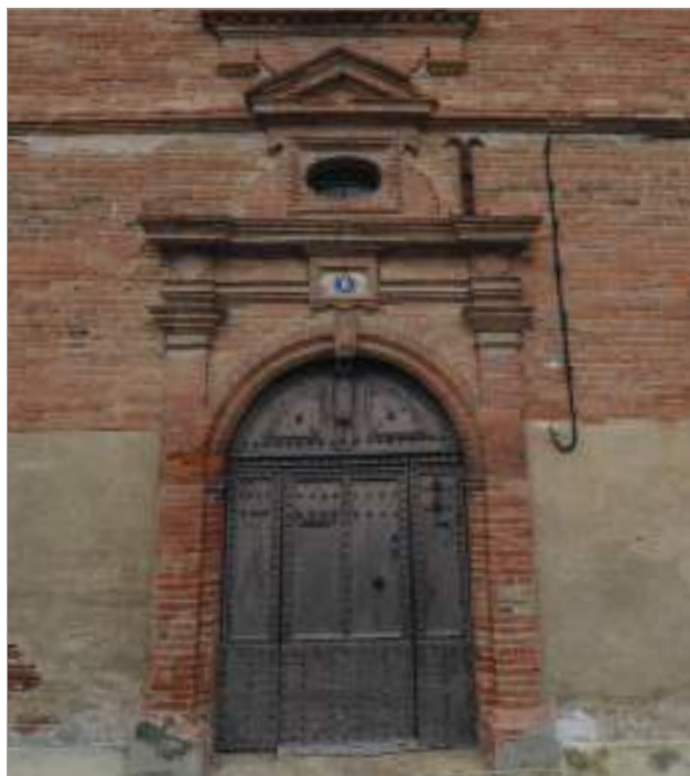
Porte. Quai du Descargadou.
