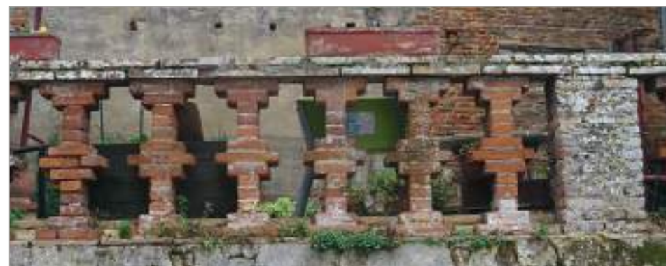
Barreaudage en brique de terre cuite.
