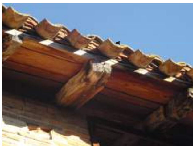
Mise en œuvre des tuiles à l'égout.
