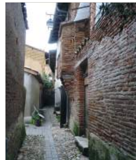
Vestige d'un rez-de-chaussée médiéval conservant une porte en arc plein cintre à l'encadrement chanfreiné. Rue du Consistoire.
