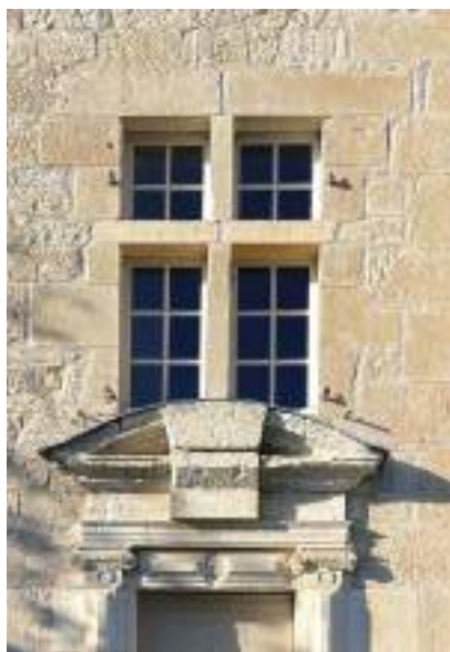
Menuiseries à petits-bois d'une fenêtre à meneaux
