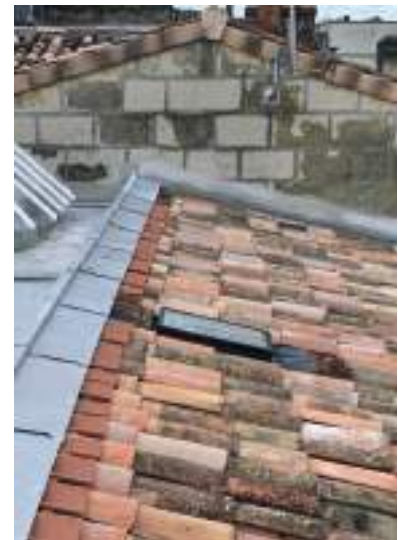
Insertion de châssis de toiture de dimensions réduites dans une toiture en tuile canal (Bordeaux et Montpellier)
