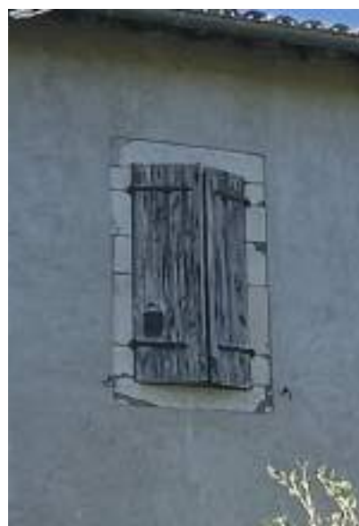
Le contrevent doit être restauré
