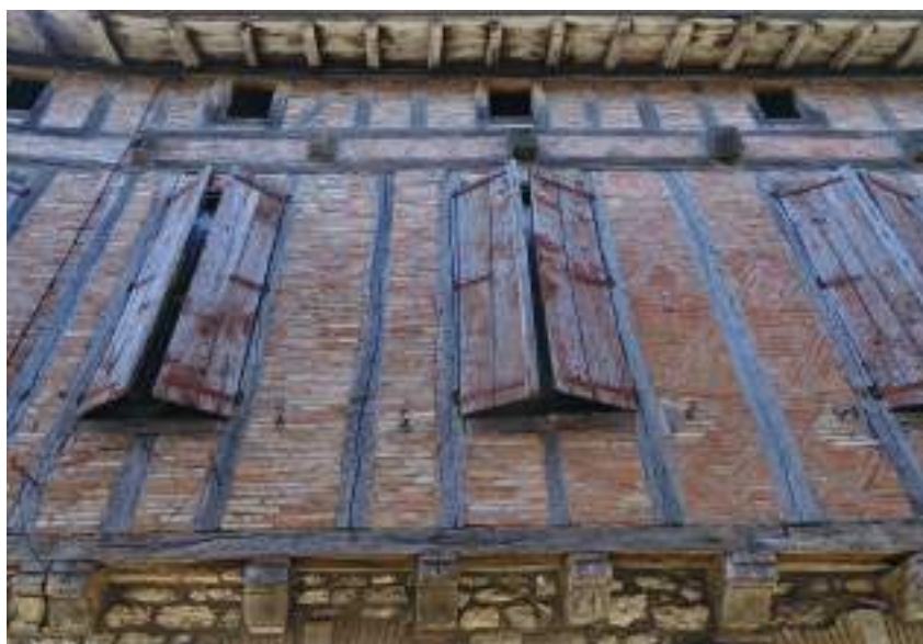
Pan de bois du XVIIIe siècle, avec hourdis en briques de terre cuite
