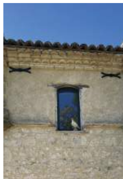
Le traitement du débord de toit par des ouvrages maçonnés, ces génénoises doivent être préservées
