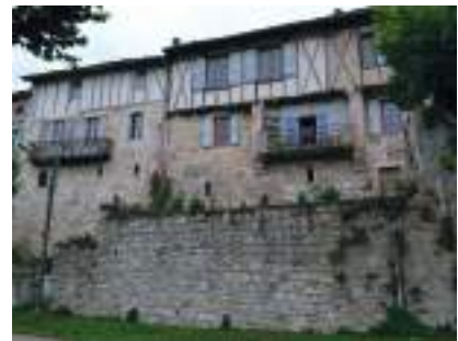
Un mur de soutènement, plus haut que les murs en pierres du bourg
