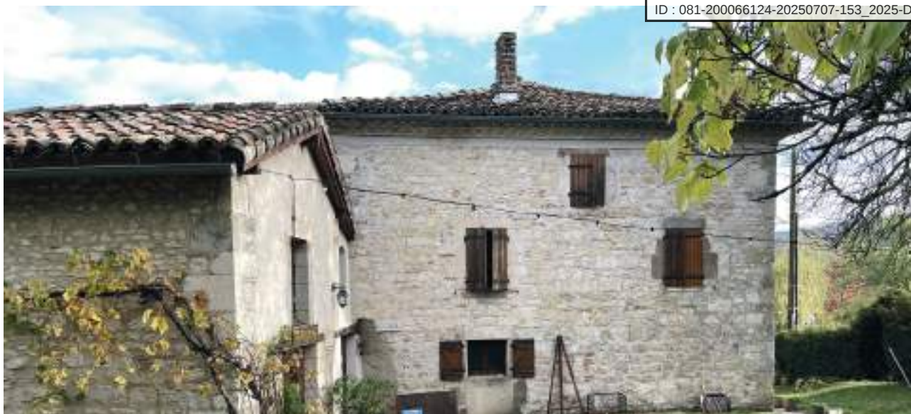
Des toitures en tuiles canal, un toit est à deux versants, l'autre à croupes
