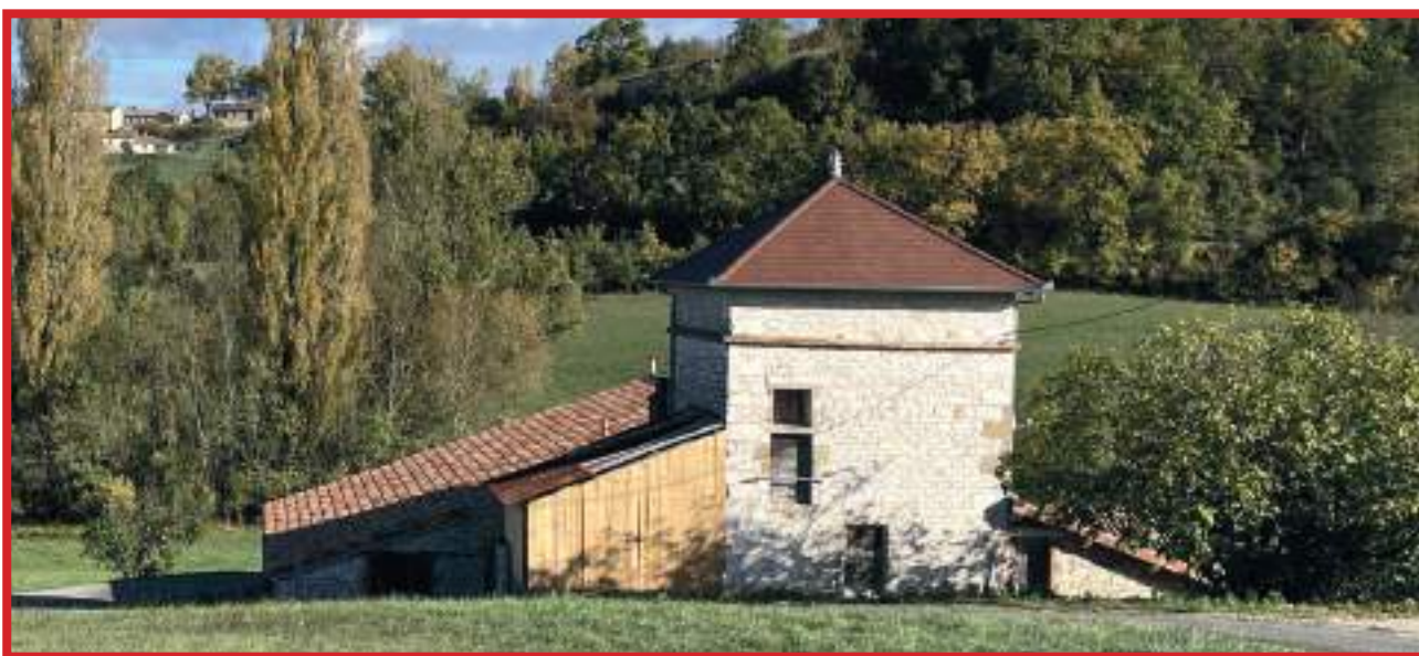
Extension en bois, toiture en tôle à éviter
