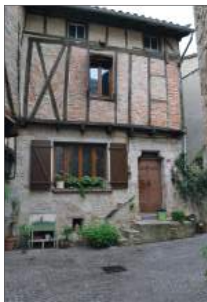
De nombreux exemples de pan de bois, avec hourdis en briques de terre cuite
