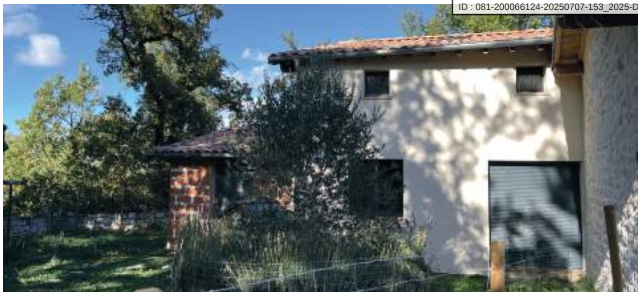
Extension maçonnée enduite. Menuiseries plein vitrage et volets roulants à éviter.
