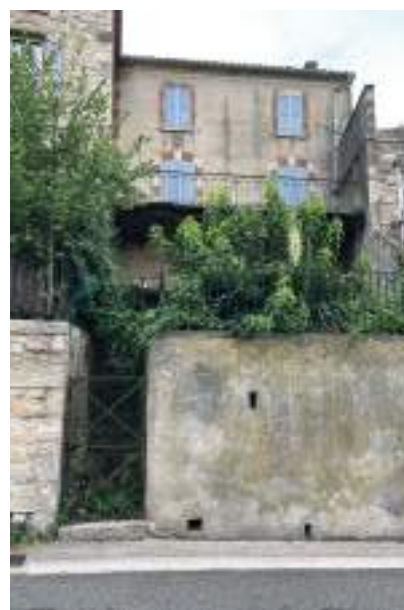
Mur recouvert d'un enduit ciment : proscrit
