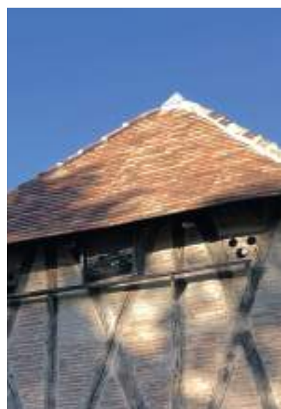
La toiture d'un pigeonnier en tuile plate
