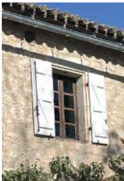
Menuiseries à petits-bois, une finition peinte serait nécessaire
