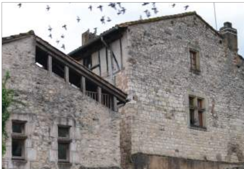
Maçonneries en moellons de pierre équarris, bien assisés
