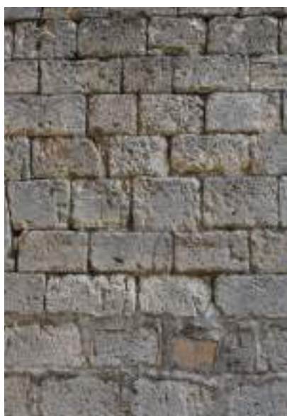
Maçonneries en moellons de pierre équarris bien assisés
