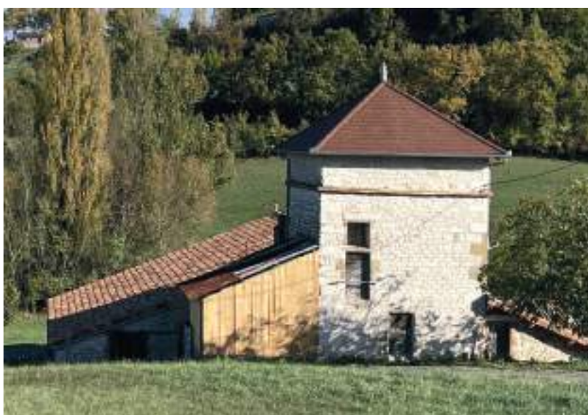
Un toit monopente avec tuile à emboîtement et un pigeonnier avec un toit en tuile plate
