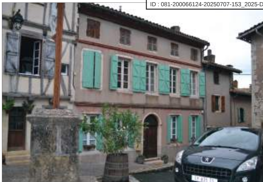
Les façades enduites du centre ancien et des faubourgs. L'enduit vient contourner la pierre de taille pour mettre en valeur les encadrements de baie
