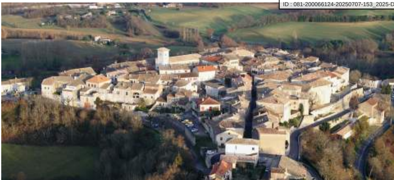
Vue des toitures de Castelnau-de-Montmiral : à double-versants ou à croupe
