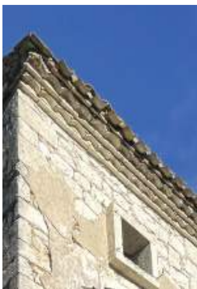
Le traitement du débord de toit par des ouvrages maçonnés, ces génénoises doivent être préservées
