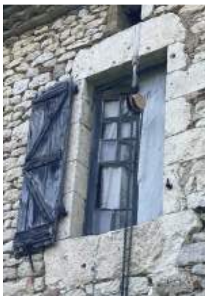
Les menuiseries d'origine à petits-bois, elles nécessitent une restauration
