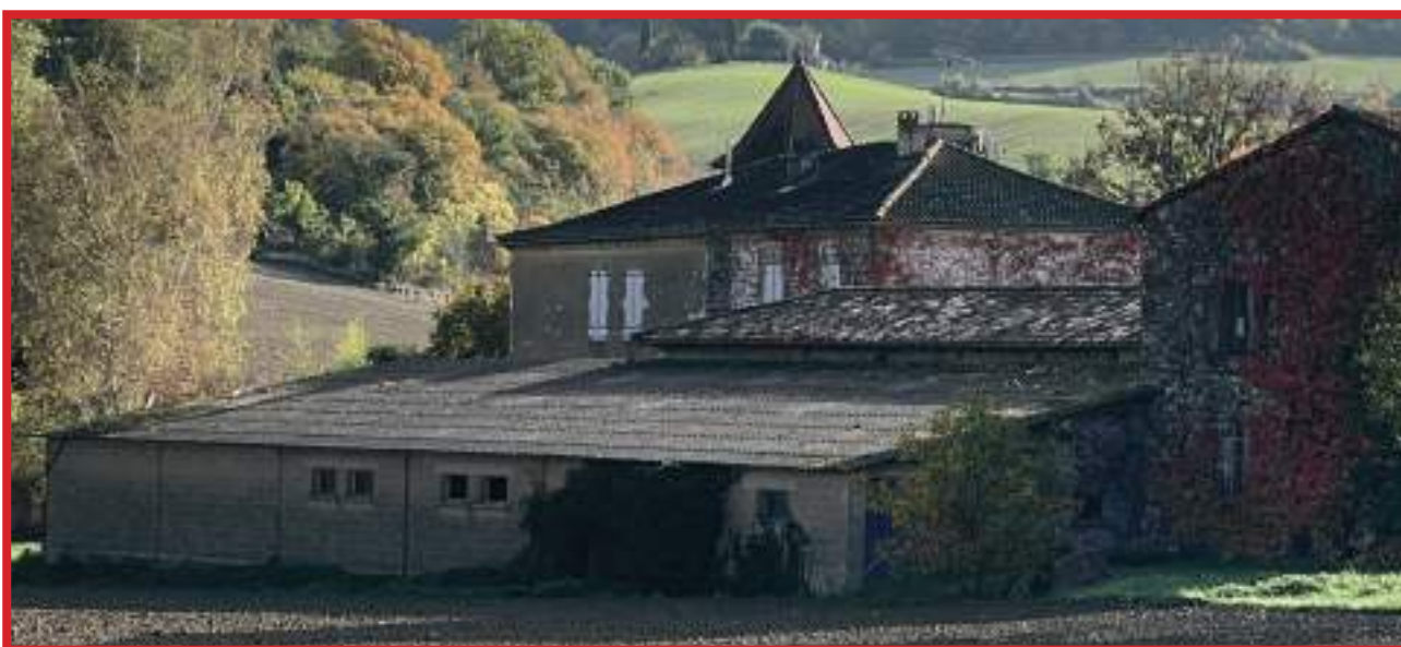
Extension en parpaings et toit en tôle, à éviter
