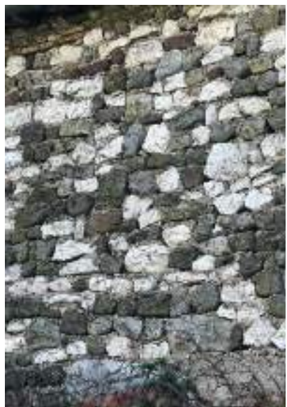
Maçonnerie de moellons de pierre grossièrement équarris
