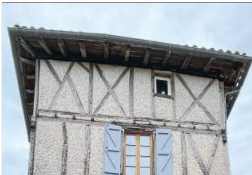
Des débords de toit à préserver
