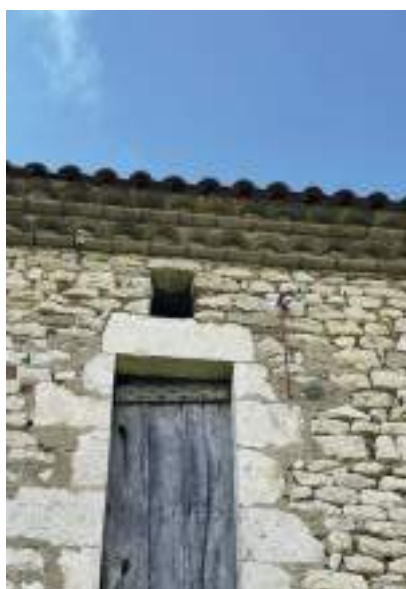
Le traitement du débord de toit par des ouvrages maçonnés, ces génénoises doivent être préservées
