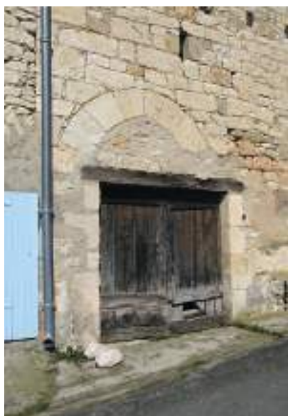
Exemples de baies anciennes comblées ou ayant subi des modifications peu respectueuses, elles pourraient être réouvertes
