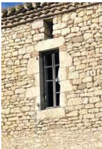
Les menuiseries d'origine à petits-bois, elles nécessitent une restauration
