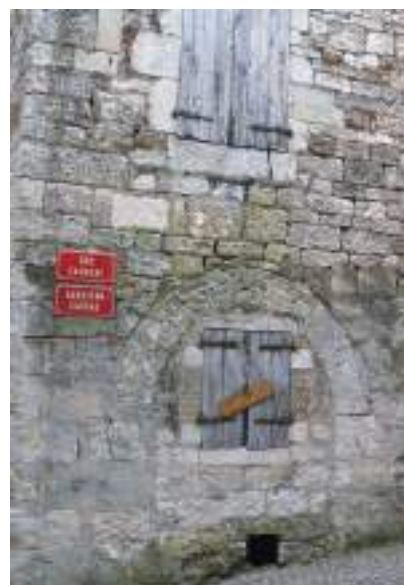
Exemples de baies anciennes comblées ou ayant subi des modifications peu respectueuses, elles pourraient être réouvertes
