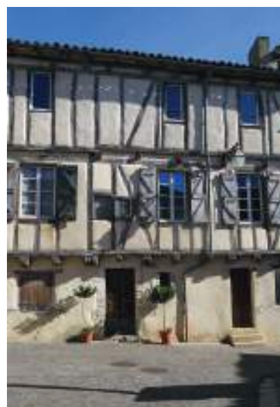
Structure apparente et hourdis enduit
