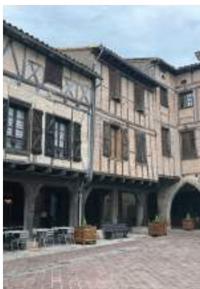
De nombreux exemples de pan de bois, avec hourdis en briques de terre cuite
