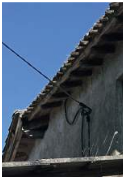
Le traitement du débord de bois par des ouvrages de charpente, ils sont à préserver
