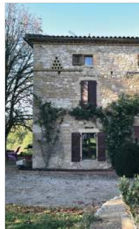
Nadou - Pigeonnier aménagé dans le grenier : le cordon de protections et les trous de la grille d'envol forment un motif décoratif.
