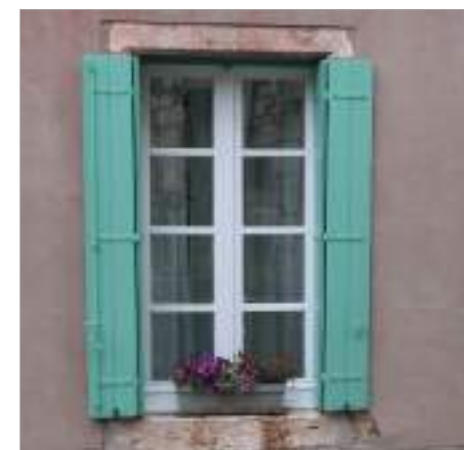
Contrevent se repliant dans l'ébrasement.
