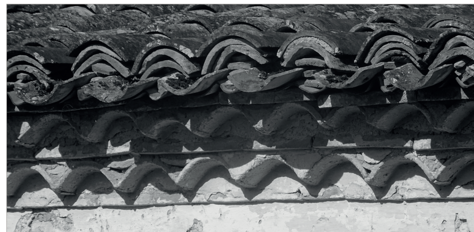
Exemple d'un débord de toit ancien sans gouttière. La génoise est badigeonnée à la chaux comme le bandeau situé dessous.
