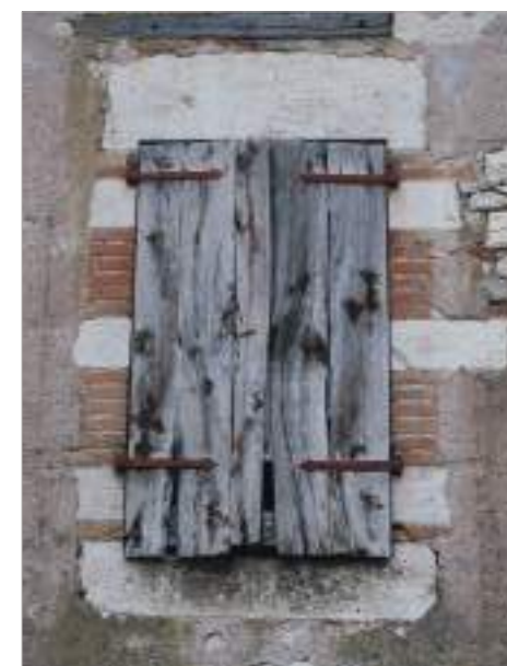
Encadrement droit dessiné avec l'enduit, constructions maçonneries.
