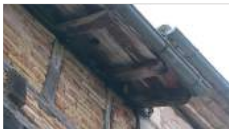
Débord de toit charpenté, abouts de chevrons taillés en bec de flûte.
