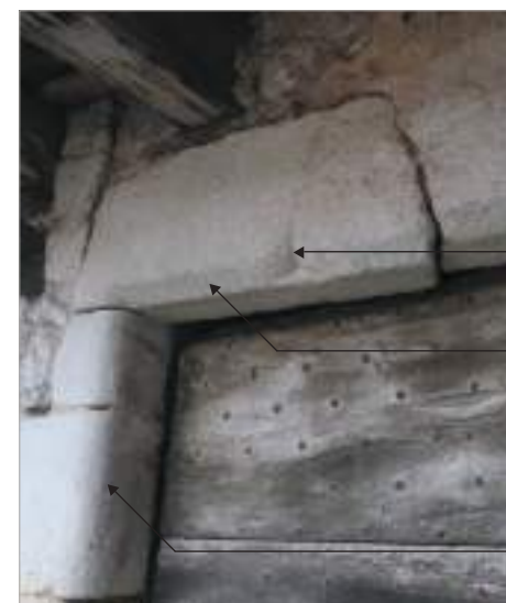
Parcelle 215 - Place Simon Fabre - Porte à linteau droit orné d'une accolade - Les arêtes de l'encadrement sont taillées en quart-de-rond.
