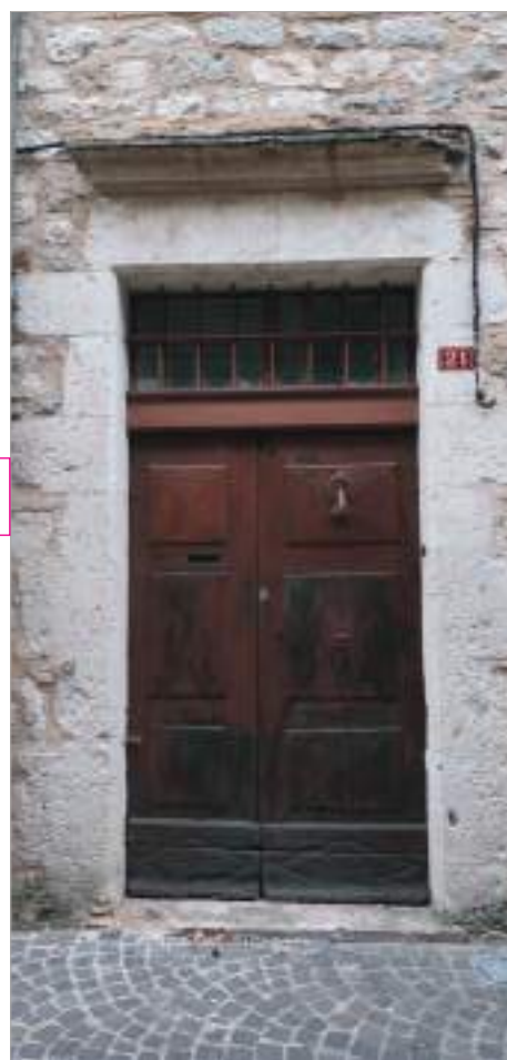
Porte bâtarde d'une maison cossue, les vantaux sont à panneaux et l'imposte vitrée est protégée par une grille en ferronnerie.
