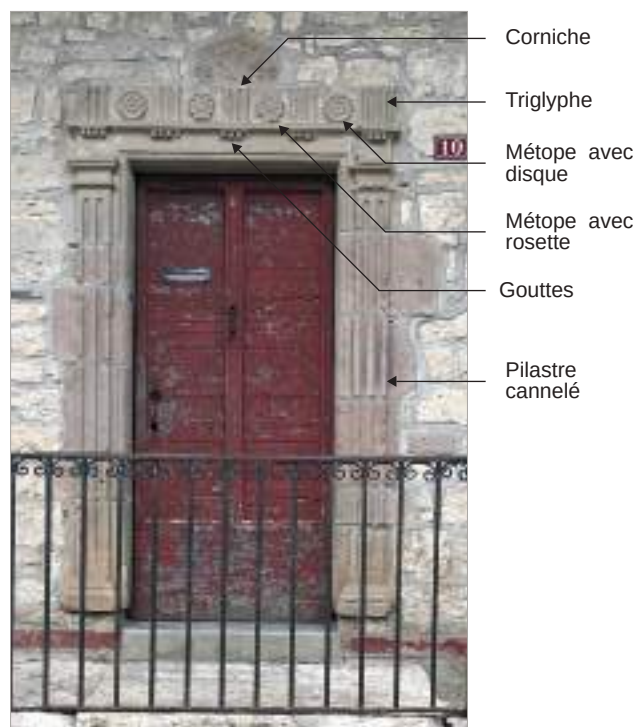
Parcelle 215 - Rue Gambetta - Porte à linteau droit - 1620. Les jambages sont sculptés de pilastres cannelés, ils supportent une corniche à métope et triglyphe.
