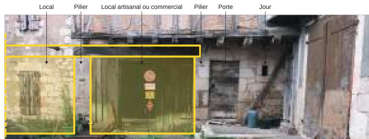
Parcelle 219 - Place Simon Fabre - Au XIX ème siècle, la maison à colombage du Moyen Age (partie de gauche) a été en partie démolie, puis une nouvelle construction a été édifiée à la place. Le système de RDC à pilier devait se prolonger d'au moins une travée.
