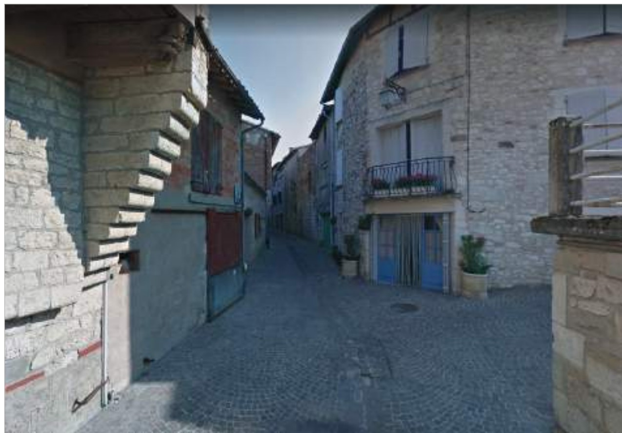
Maisons détruites puis reconstruites aux XIX ème et XX ème siècles.
