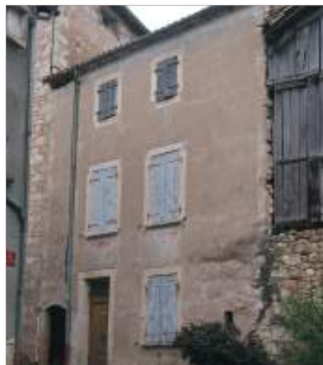
Parcelle 593 - Place Simon Fabre - Enduit à la chaux avec un sable rose. Décor de badigeon blanc cassé sur un enduit à la chaux lissé et teinté avec du sable blond. Le décor est limité aux limites mitoyennes et au couronnement, aux angles un motif de quart-de-rond.
