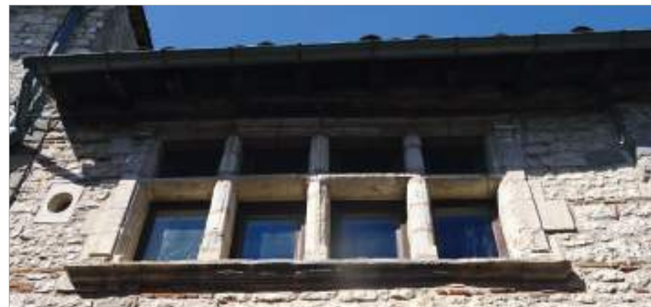
Parcelle 455 - Rue Jean-Baptiste Marcet - Fenêtre à claire-voie délimité par des meneaux. Les piédroits sont ornés de pilastres soutenant une corniche. L'appui saillant est mouluré. A gauche, un oculus ovale.
