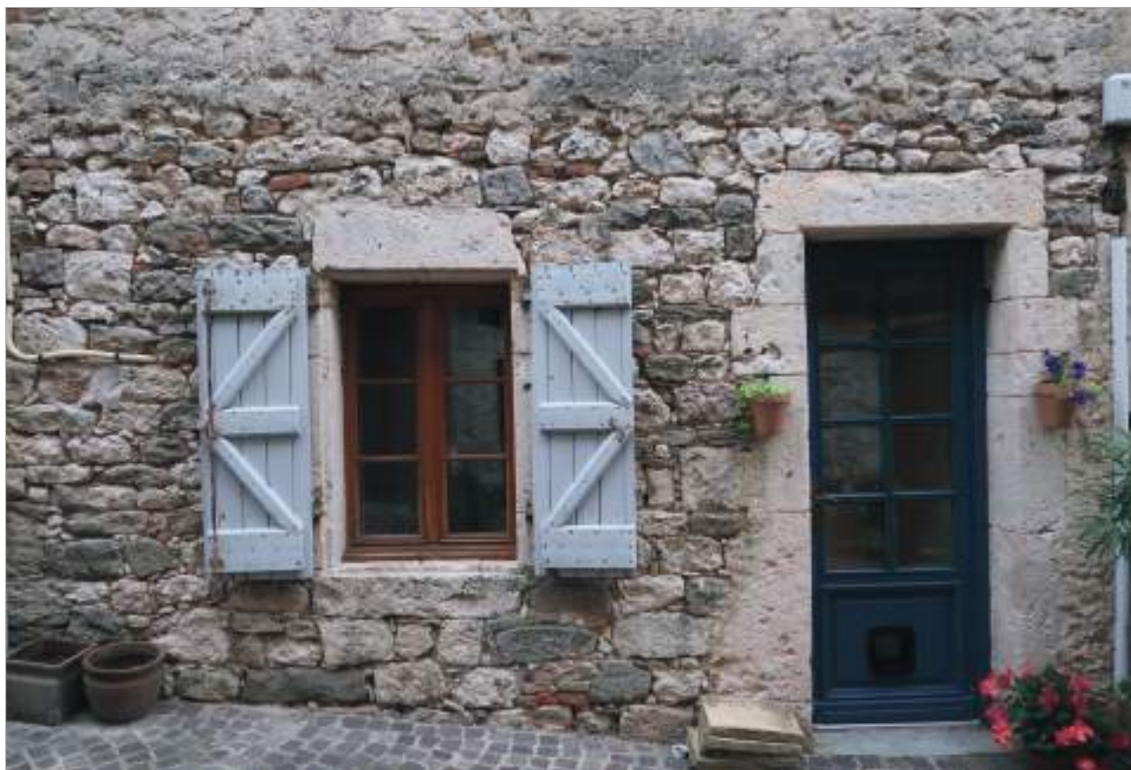
Sur ces deux photographies, les encadrements de percements sont en pierre de taille.
