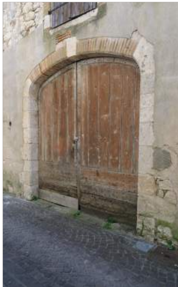
Couvrement en anse de panier en brique foraine - Vantaux à cadre.
