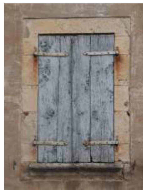
Encadrement droit dessiné avec l'enduit, constructions maçonneries.
