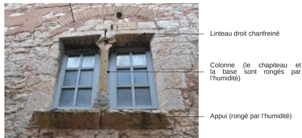
Parcelle 135 - Ouvertures couvertes par un linteau droit.
