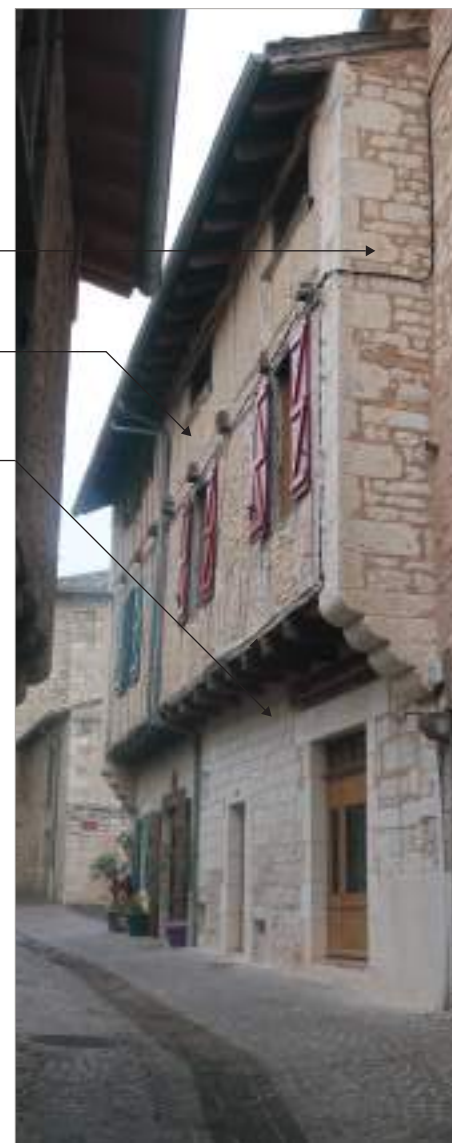
Parcelle 119 - Rue des Chiffonniers - Mur mitoyen en encorbellement et vestige d'un RDC en pierre de taille.
