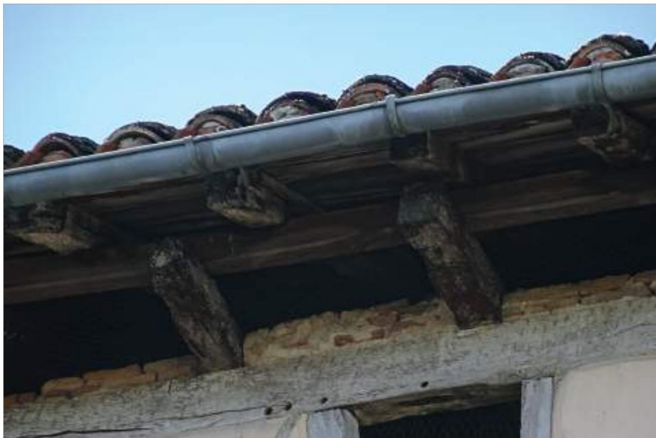
Parcelle 235 - Rue de la Porte Neuve - Débord de toit avec panne sablière en débord soutenue par des poutres.
