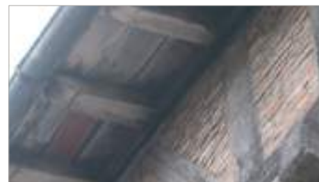
Débord de toit charpenté : abouts de chevrons taillés en quart-de-rond.
