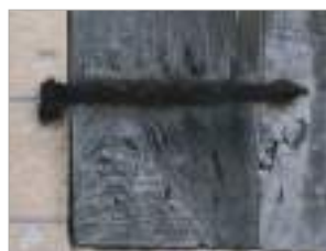
Les deux modèles de pentures (organe de rotation).
