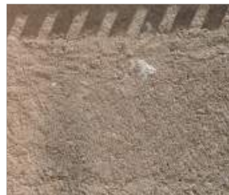
Enduit à la chaux avec un sable blond.
