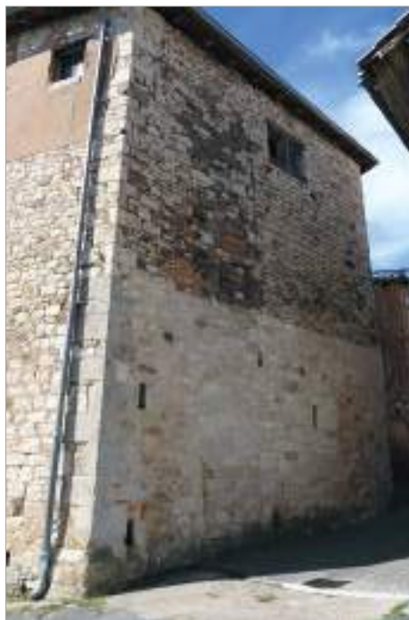
Façade latérale : demi-croisée moulurée d'un chanfrein amorti par un congé droit. L'appui saillant est mouluré.
