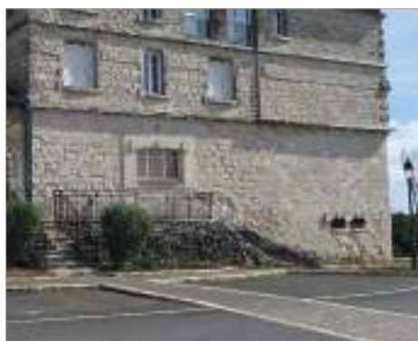
Maçonnerie de gros appareil probablement formant la base du château.
