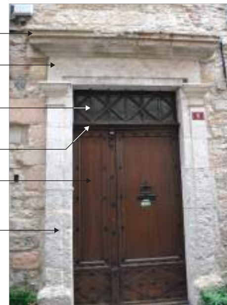
Parcelle 130 - Rue des Chiffonniers - Ce modèle de porte a un linteau droit supporté par des pilastres. Une corniche prend place sur le linteau.
