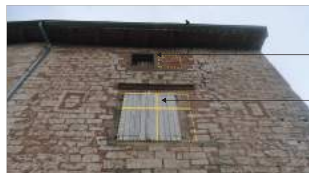
Parcelle 132 - Rue des Chiffonniers - Cette façade présente trois travées à croisée et fenêtre à meneau aujourd'hui partiellement murée.
