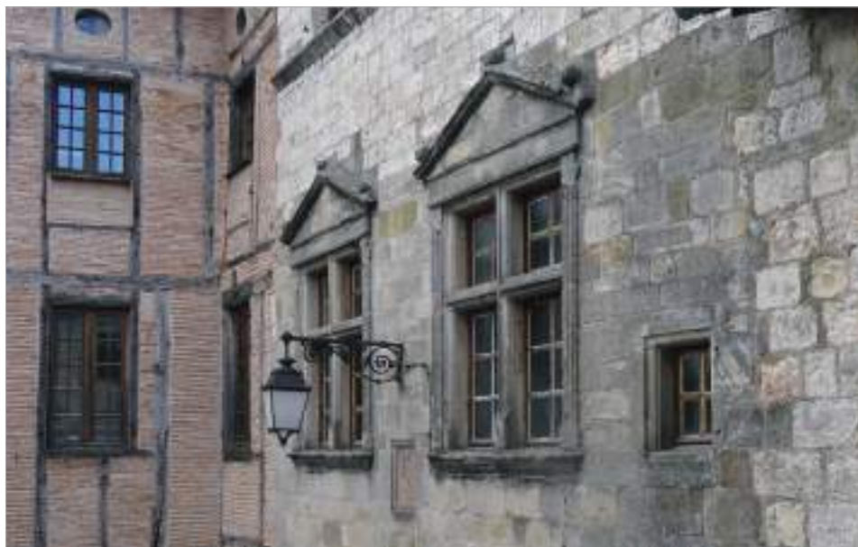
Maison de la place des Arcades (MHI), 1630 - Des pilastres cannelés supportent une corniche, au-dessus un fronton triangulaire orné de boules. L'appui saillant est mouluré.
