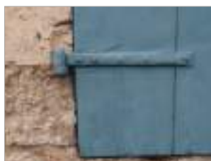
Les deux modèles de pentures (organe de rotation).
