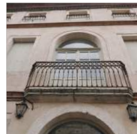
Maison cossue, porte-fenêtre en arc plein cintre réalisé en pierre de taille.
