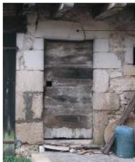
Parcelle 215 - Place Simon Fabre - Porte à linteau droit orné d'une accolade - Les arêtes de l'encadrement sont taillées en quart-de-rond.
