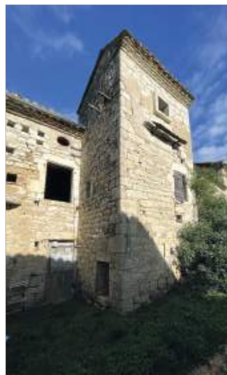
Les dumasses - Le pigeonnier occupe le dernier niveau de la tour. La protection est limitée à un encadrement saillant.
