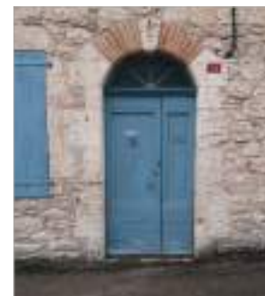
Maison de faubourg (XIX ème ) - Vantaux à panneaux, imposte vitrée, petit-bois rayonnants.
