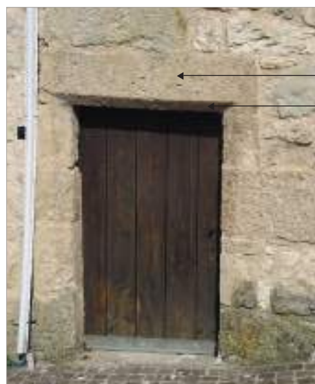
Parcelle 263 - Rue des Anciens Combattants - Porte à linteau - Les arêtes de l'encadrement sont chanfreinées.
