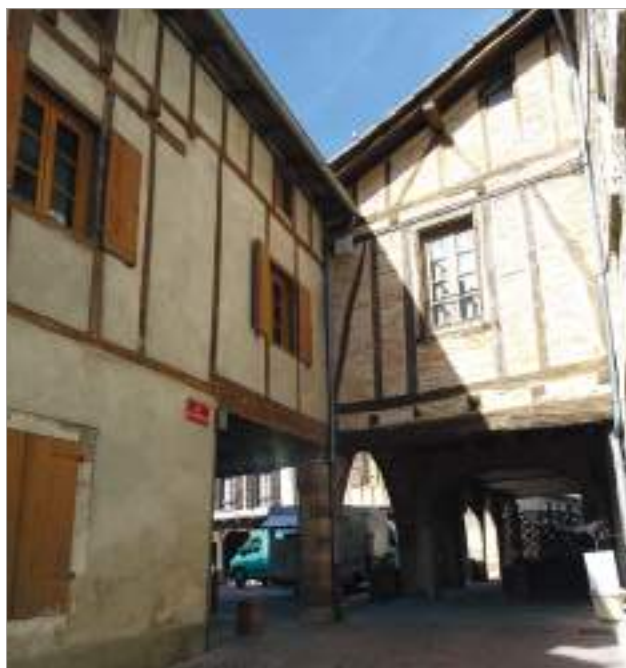
Les cornières conservées.
