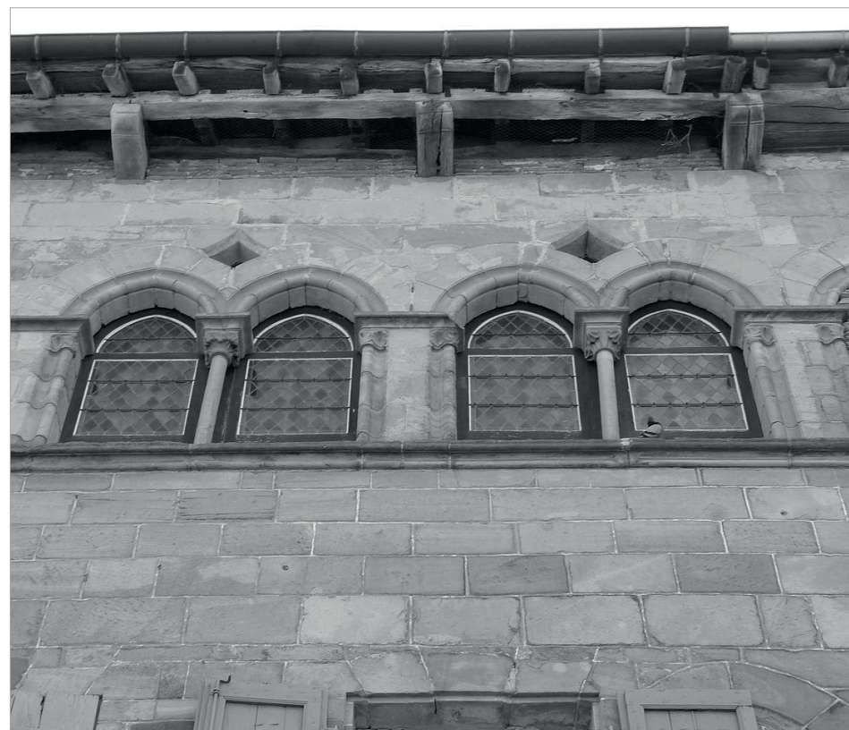
Maison Carrié-Bouvier - Cordes-sur-Ciel - Maison maçonnée : débord de toit avec panne sablière en débord soutenue par des poutres.
