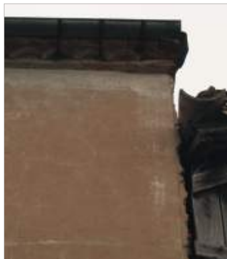
Parcelle 593 - Place Simon Fabre - Enduit à la chaux avec un sable rose. Décor de badigeon blanc cassé sur un enduit à la chaux lissé et teinté avec du sable blond. Le décor est limité aux limites mitoyennes et au couronnement, aux angles un motif de quart-de-rond.
