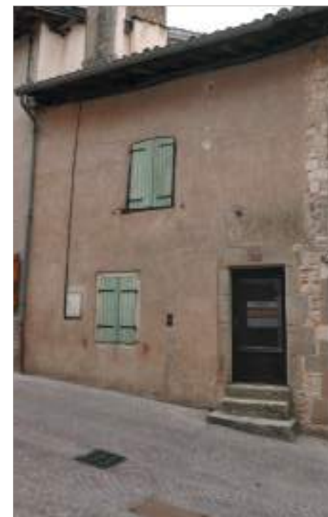
Maison modeste : Parcelle 227 - Rue de la Porte-Neuve - La façade de cette maison médiévale semble avoir été entièrement reconstruite. Le RDC est toujours bâti en maçonnerie et l'étage en pan de bois. L'organisation des percements en élévation est aléatoire.
