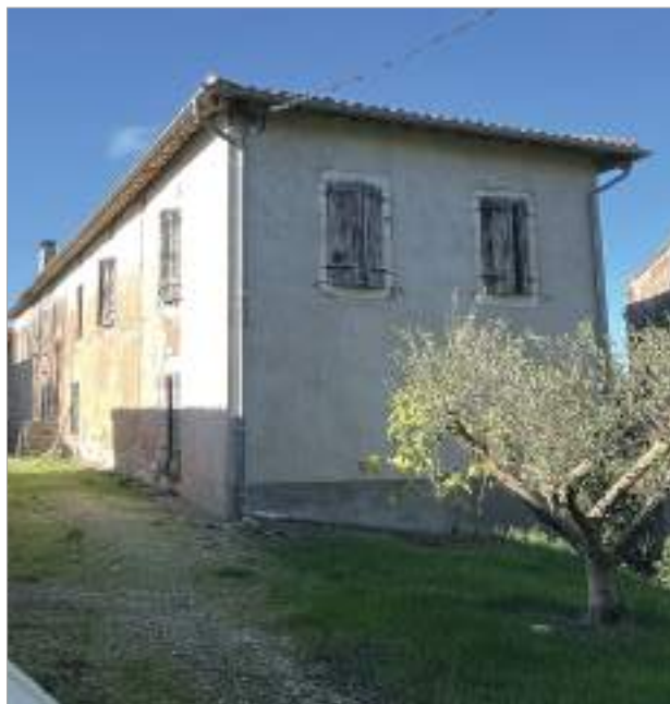
Les Massiottes - Des ressemblances avec les maisons du village (encadrement bicolore en brique de terre cuite et pierre de la porte, abattement de l'arête par un chanfrein, même type de menuiserie à cadre - emploi d'un enduit teinté avec du sable rose).
