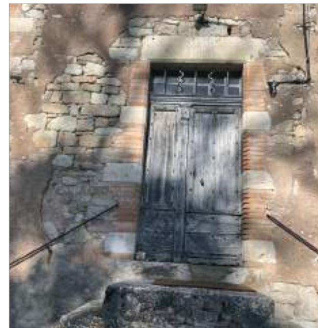
Les Massiottes - Emploi de la brique bourguignonne pour certaines parties de cette ferme réaménagée à la fin du XIX ème siècle.
