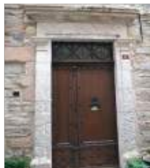
Maison cossue - Vantaux à cadre, imposte vitrée, petit-bois formant des losanges.
