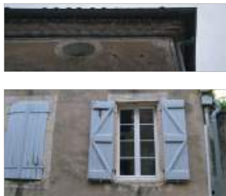
Parcelle 314 - Rue Gambetta - Même type de décor sur cette façade, mais les encadrements sont enduits et badigeonnés.
