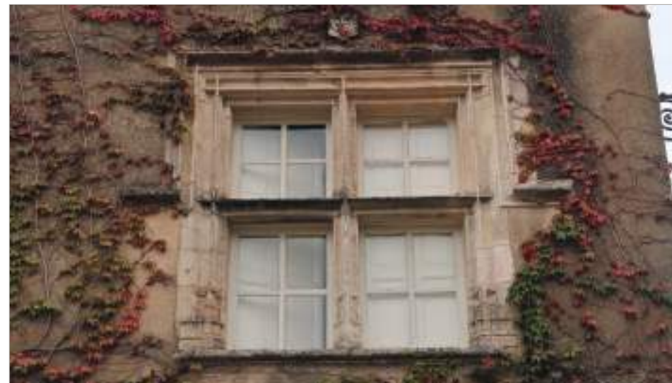
Parcelle 263 - Rue des Anciens Combattants - Croisée à encadrement mouluré à baguettes croisées (peut-être un réemploi).
