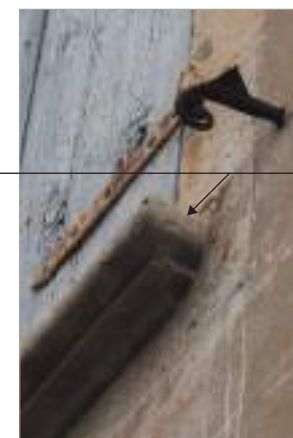
Appui mouluré saillant
