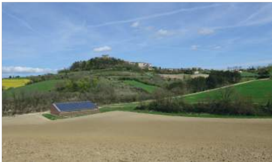
3- Depuis Mandrine, toiture photovoltaïque.
