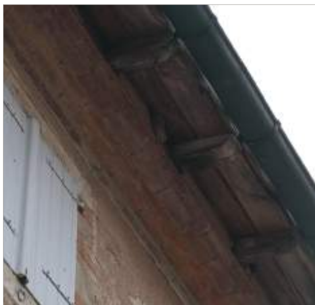
Corniche en brique et chevrons passants.
