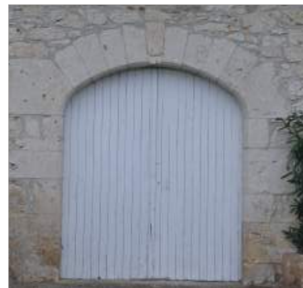
Couvrement en anse de panier en pierre de taille, l'arête est abattue en chanfrein arrêté par des congés droits.
