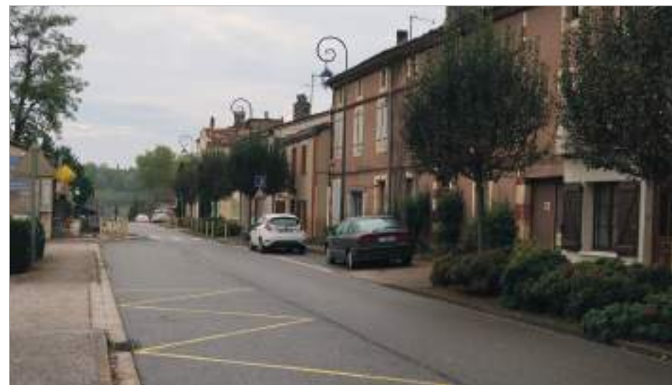
Élévation sud la route de Gaillac : le front bâti avec des maisons à l'alignement est homogène tant par le style des édifices que le mode de bâtir.
