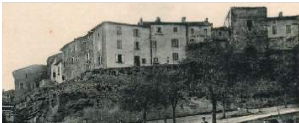
Façades maçonneries enduites.
