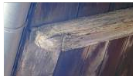
Débord de toit charpenté : abouts de chevrons taillés en quart-de-rond.
