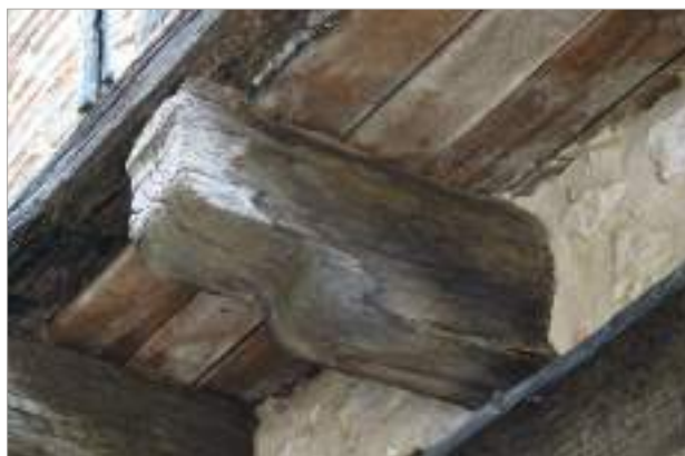
Parcelle 377 - Façade latérale.
