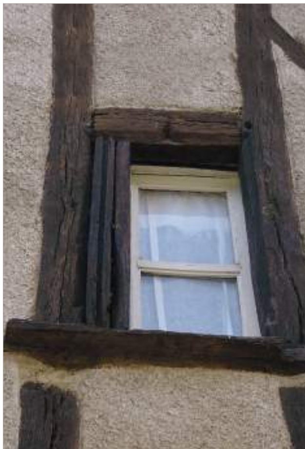
Parcelle 252 - Rue Maximilien Cagnieul - Jour : encadrement chanfreiné, linteau orné d'une accolade, appui saillant taillé en biseau.
