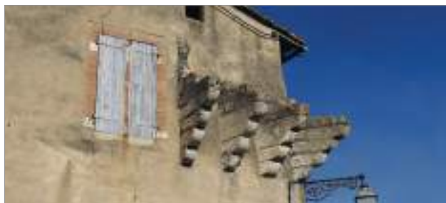
Consoles de pierre d'une échauguette.
