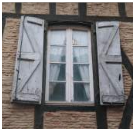
Pan de bois, linteau en arc segmentaire.
