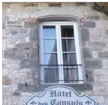
Pierre de taille, linteau en arc segmentaire.
