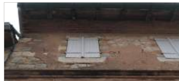
Couronnement constitué d'une corniche en brique foraine et de chevrons en débord.
