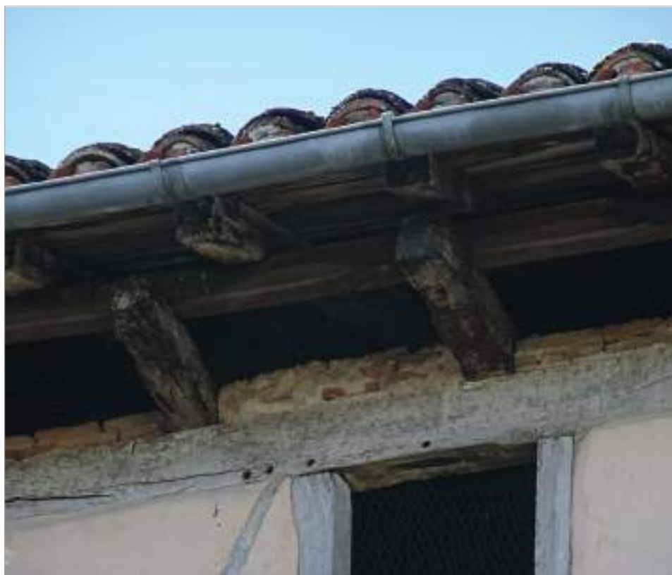
Parcelle 235 - Rue de la Porte Neuve - Maison en pan de bois : débord de toit avec panne sablière en débord soutenue par des poutres.
