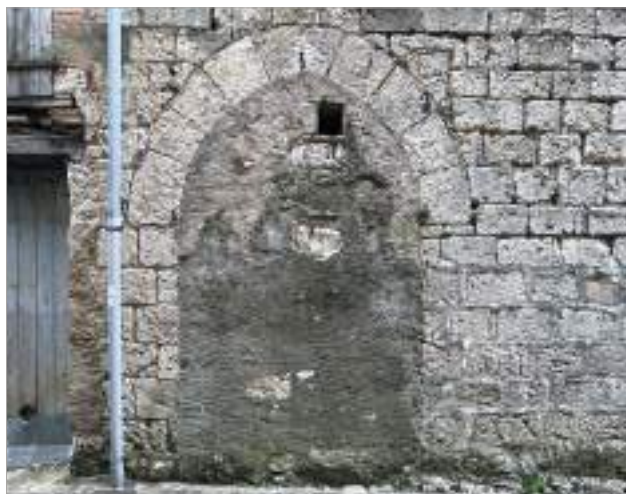
Parcelle 301 - Rue Basse - Arcade en arc brisé en pierre de taille.
