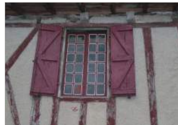
Ici, la taille du vitrage demeure limitée et les châssis sont redécoupés par de nombreux petits bois.
