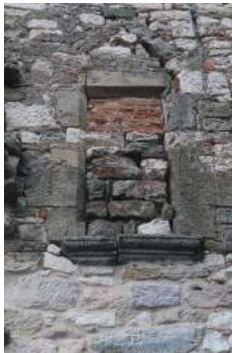
Façade latérale : demi-croisée moulurée d'un chanfrein amorti par un congé droit. L'appui saillant est mouluré.
