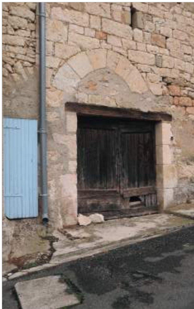
Simple linteau en bois - Vantaux à cadre.
