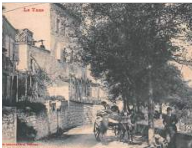
Création d'une route sur le flanc sud (Avenue du 8 mai 1945) avec son alignement d'arbre aujourd'hui disparu.
