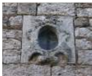
Parcelle 218 - Rue Cahuzac - Oculus situé au dessus de la porte.
