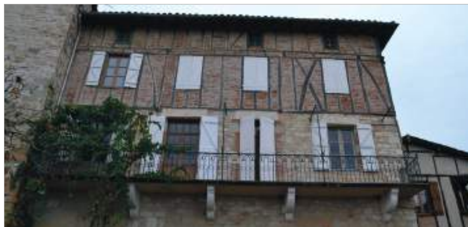
Maisons sur les remparts est - Sur cette carte postale, les façades ont des enduits à la chaux. Aujourd'hui les enduits ont été piqués ou refaits avec du ciment.
