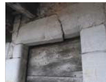
Linteau de la porte avec motif d'accolade.
