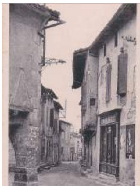
Façades en pan de bois enduites.
