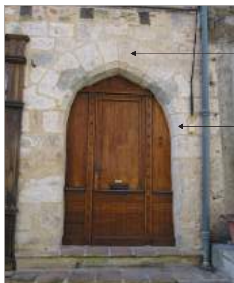
Parcelle 454 - Rue du Commerce - Porte dont le couvrement est en arc brisé - Les arêtes de l'encadrement sont abattues par un chanfrein.
