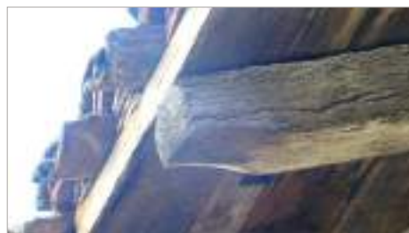
Débord de toit charpenté, abouts de chevrons taillés en bec de flûte.
