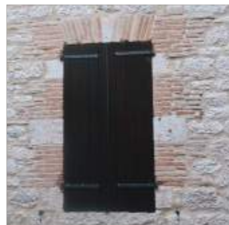
Brique foraine, arc à plate-bande.
