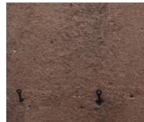
Enduit à la chaux avec un sable rose.
