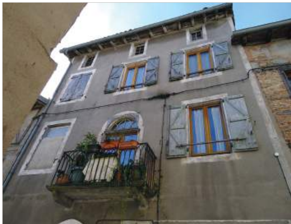
Maison cossue : Parcelle 163 - Rue du Commerce - Le pan de bois de cette maison médiévale date du XIX ème siècle. La composition des percements est régulière avec une travée axiale mise en valeur par la porte-fenêtre et le balcon du premier étage, étage noble. Au RDC, les deux percements couverts par des arcs datent du Moyen Age, la baie rectangulaire du milieu du XX ème siècle. L'enduit ciment, datant également de cette période, s'inspire des décors d'enduit de l'époque classique avec l'emploi d'une peinture blanche pour souligner l'encadrement des baies, les limites mitoyennes et le couronnement.
