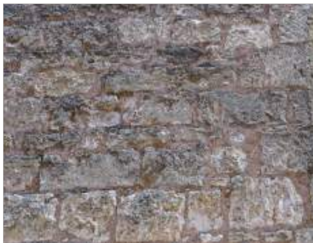
Appareil de moellons équarris assisés.
