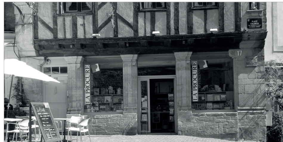
Exemple d'un RDC à piliers en pierre de taille, Vannes, Morbihan.
