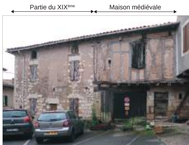
Parcelle 219 - Place Simon Fabre - Au XIX ème siècle, la maison à colombage du Moyen Age (partie de gauche) a été en partie démolie, puis une nouvelle construction a été édifiée à la place. Le système de RDC à pilier devait se prolonger d'au moins une travée.
