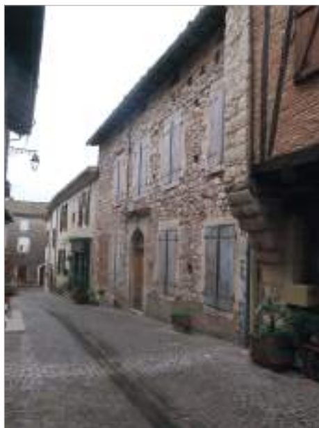
Parcelle 143 - Rue Baptiste Marcet - La façade est à quatre travées. L'habitation se développe sur les deux premiers niveaux, le comble a un usage de stockage. Le tracé du couvrement de la porte batârde est en arc plein cintre avec une clé saillante à volute. La porte est surmontée d'une corniche.
