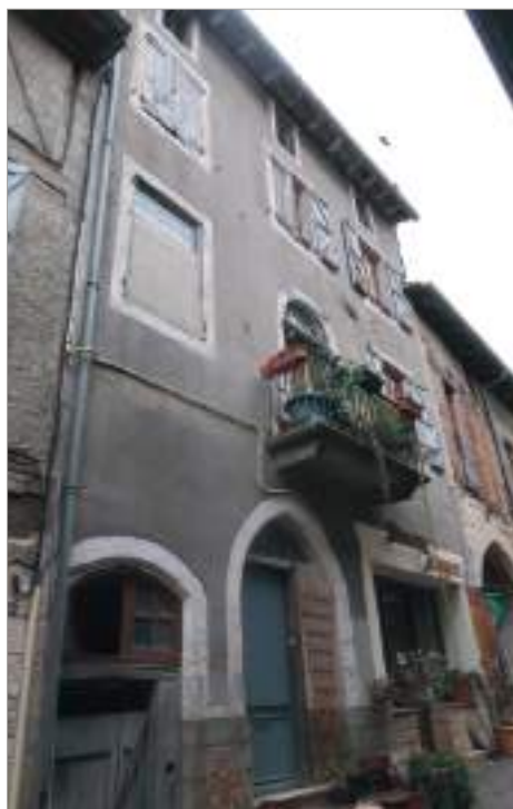
Maison cossue : Parcelle 163 - Rue du Commerce - Le pan de bois de cette maison médiévale date du XIX ème siècle. La composition des percements est régulière avec une travée axiale mise en valeur par la porte-fenêtre et le balcon du premier étage, étage noble. Au RDC, les deux percements couverts par des arcs datent du Moyen Age, la baie rectangulaire du milieu du XX ème siècle. L'enduit ciment, datant également de cette période, s'inspire des décors d'enduit de l'époque classique avec l'emploi d'une peinture blanche pour souligner l'encadrement des baies, les limites mitoyennes et le couronnement.
