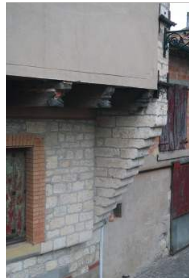
Parcelle 215 - Rue Gambetta - Imposant encorbellement.
