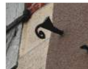
Contrevent se repliant dans l'ébrasement.
