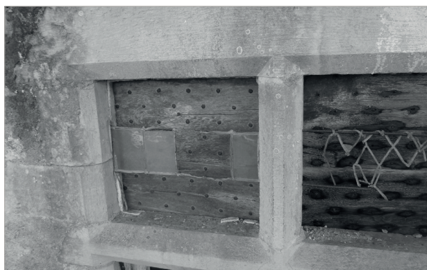
Vestige de vitraux scellés protégés par des volets à lames croisées - Grange de Bargues, Assier, Lot.
