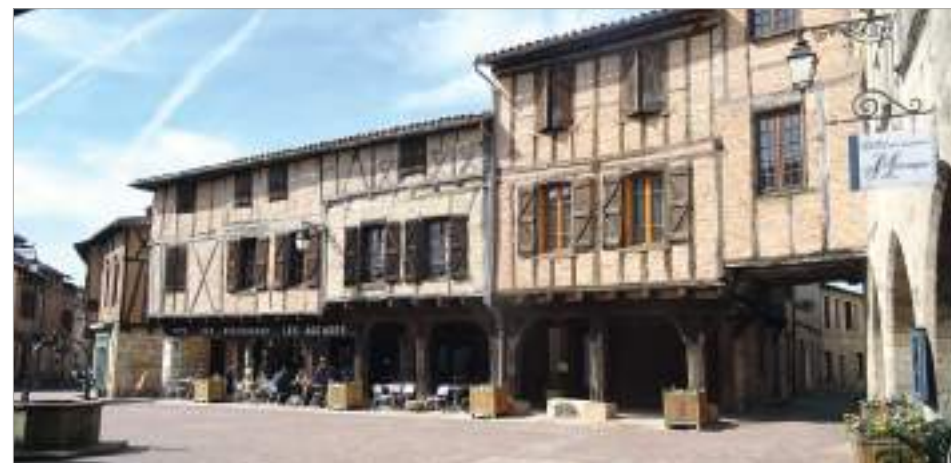
Au milieu de XX ème siècle, les façades de la place sont enduites, les poutres des couverts et les poteaux masqués par du lattis plâtré. Aujourd'hui les enduits ont été piqués et les habillages déposés.
