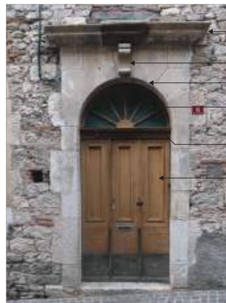
Parcelle 143 - Rue Baptiste Marcet - La façade est à quatre travées. L'habitation se développe sur les deux premiers niveaux, le comble a un usage de stockage. Le tracé du couvrement de la porte batârde est en arc plein cintre avec une clé saillante à volute. La porte est surmontée d'une corniche.
