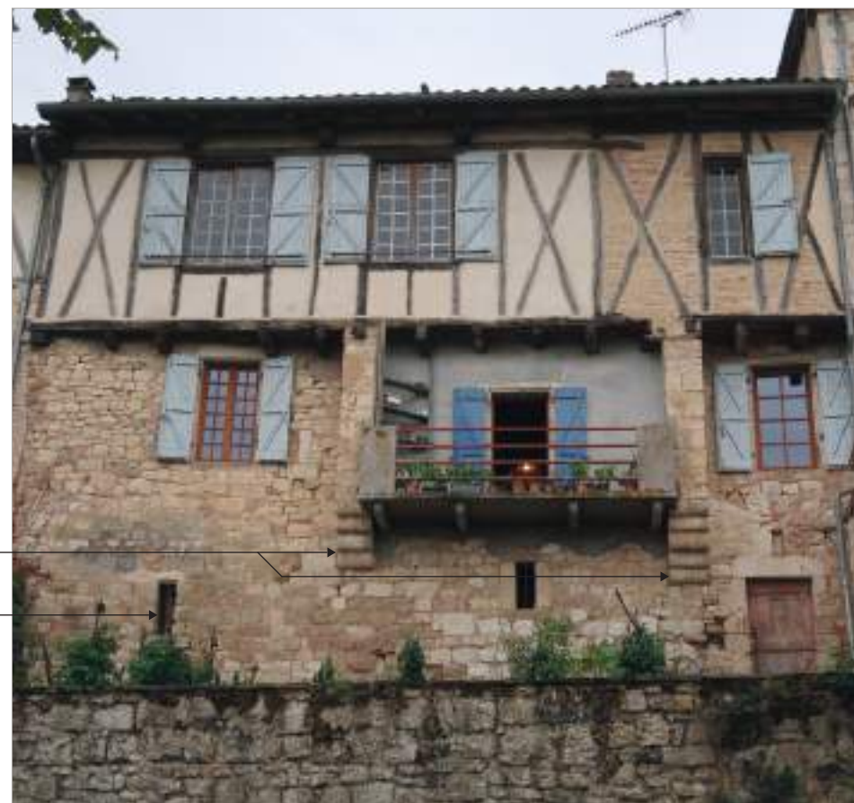
Parcelle 240 - Place Simon Fabre - Encorbellement sur le rempart.
