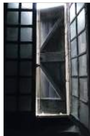
Ici, la taille du vitrage demeure limitée et les châssis sont redécoupés par de nombreux petits bois.
