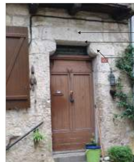
Parcelle 121 - Rue des Chiffonniers - Porte à linteau supporté par des coussinets - Les arêtes de l'encadrement sont chanfreinées.
