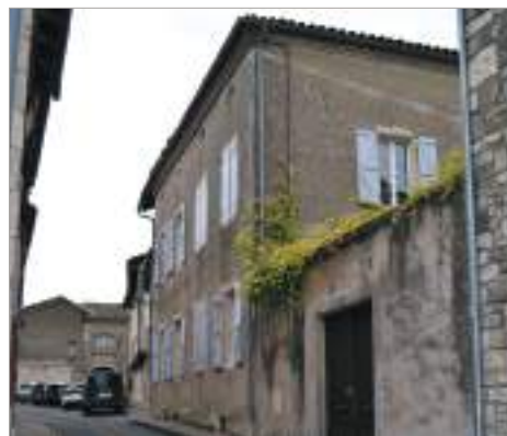
Parcelle 314 - Rue Gambetta - Même type de décor sur cette façade, mais les encadrements sont enduits et badigeonnés.
