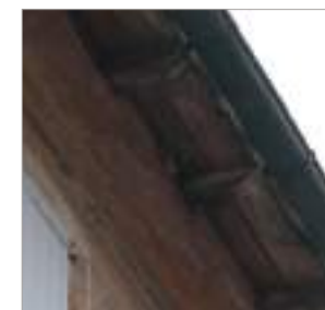
Couronnement constitué d'une corniche en brique foraine et de chevrons en débord.
