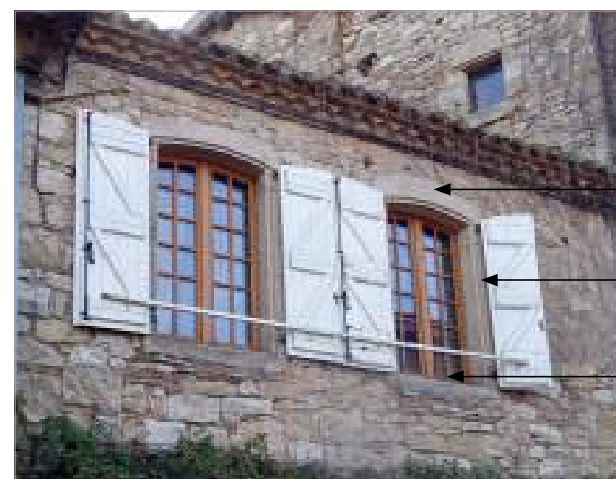
Parcelle 460 - Les fenêtres peuvent aussi avoir des couvrements taillés en arc segmentaire.
