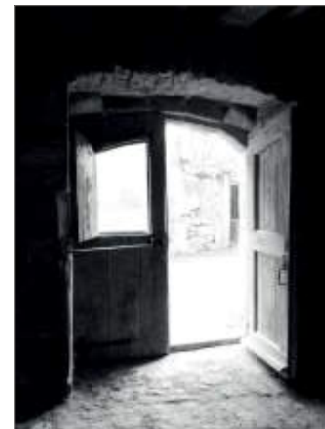
Vantaux à cadres, côté extérieur et intérieur - Grange de Bargues, Assier, Lot.
