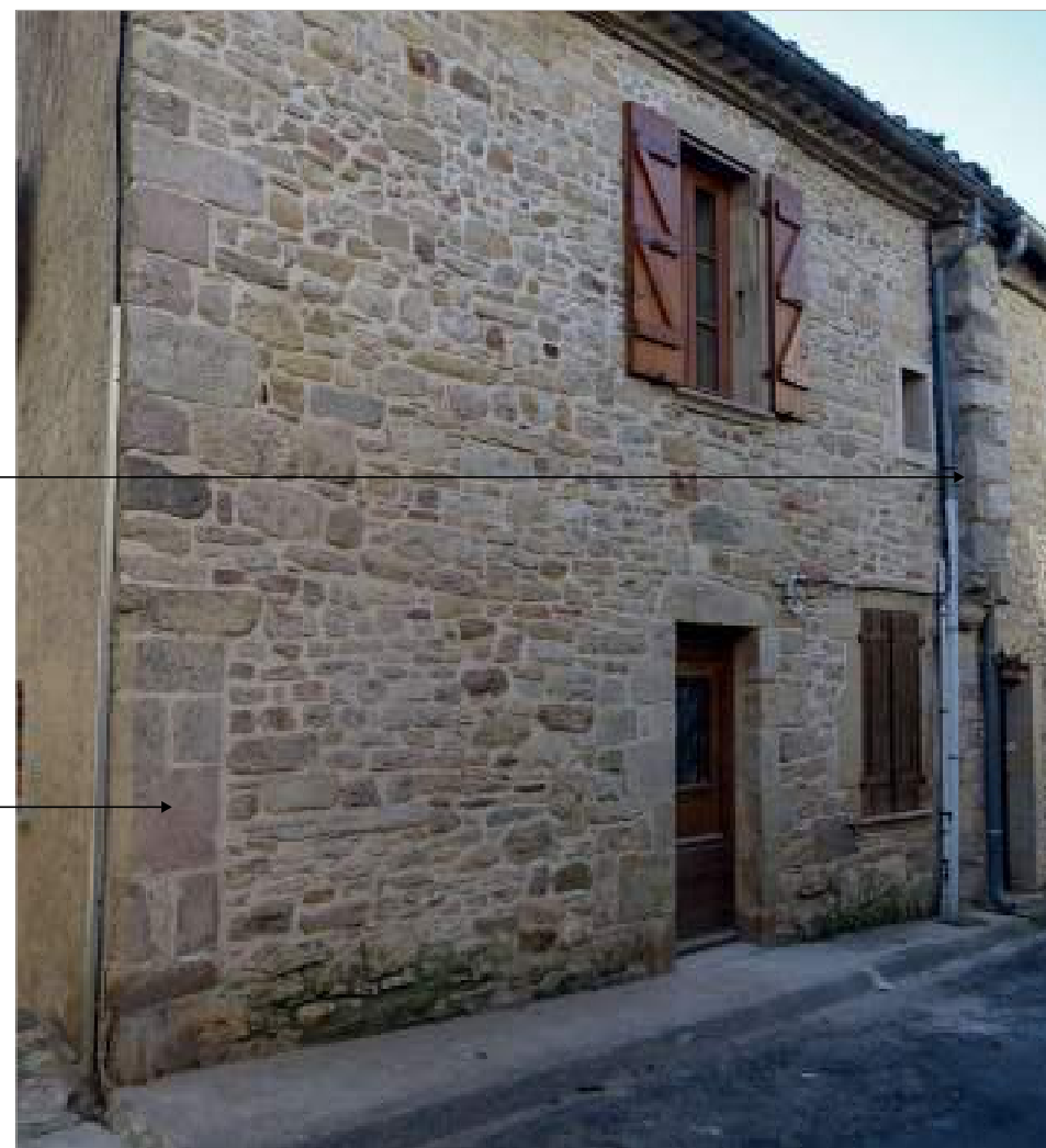
Parcelle 299 - Enchâssé dans une reconstruction du XIX ème siècle, les derniers vestiges d'une maison à pan de bois : pilier à coussinet et tête de mur mitoyen en encorbellement.
