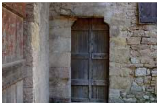
Porte au linteau posé sur coussinets.
