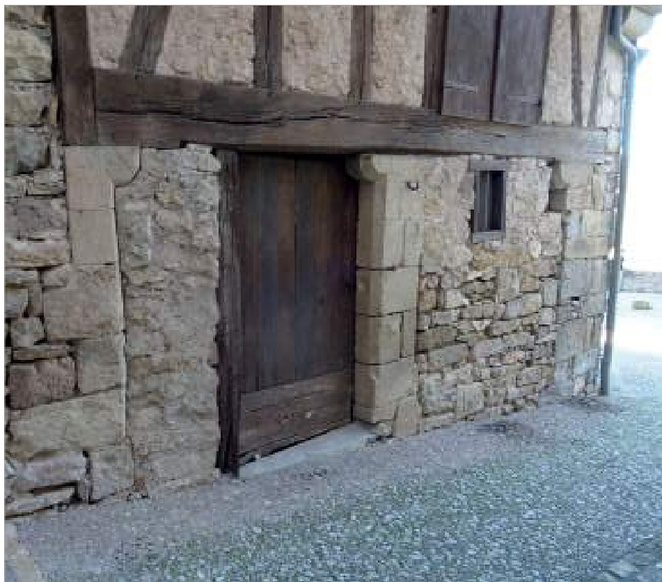
Parcelle 757 - Vestige d'un RdC avec piliers à coussinets, le remplissage entre les piliers date du XIX ème siècle.
