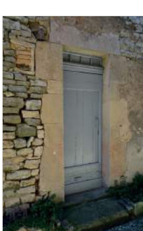
Porte piétonne (maison modeste) à encadrement affleurant et linteau droit.
