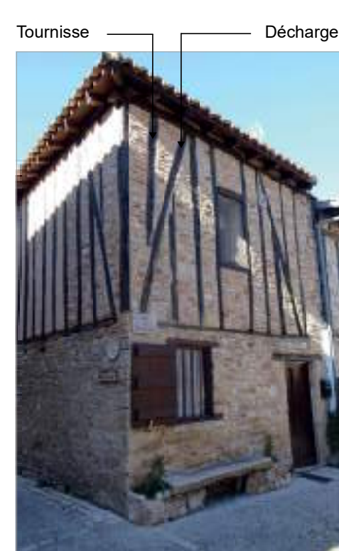
Ossature à grille avec décharges et tournisses, les bois neufs sont reconnaissables : pièces de petites sections et tors.
