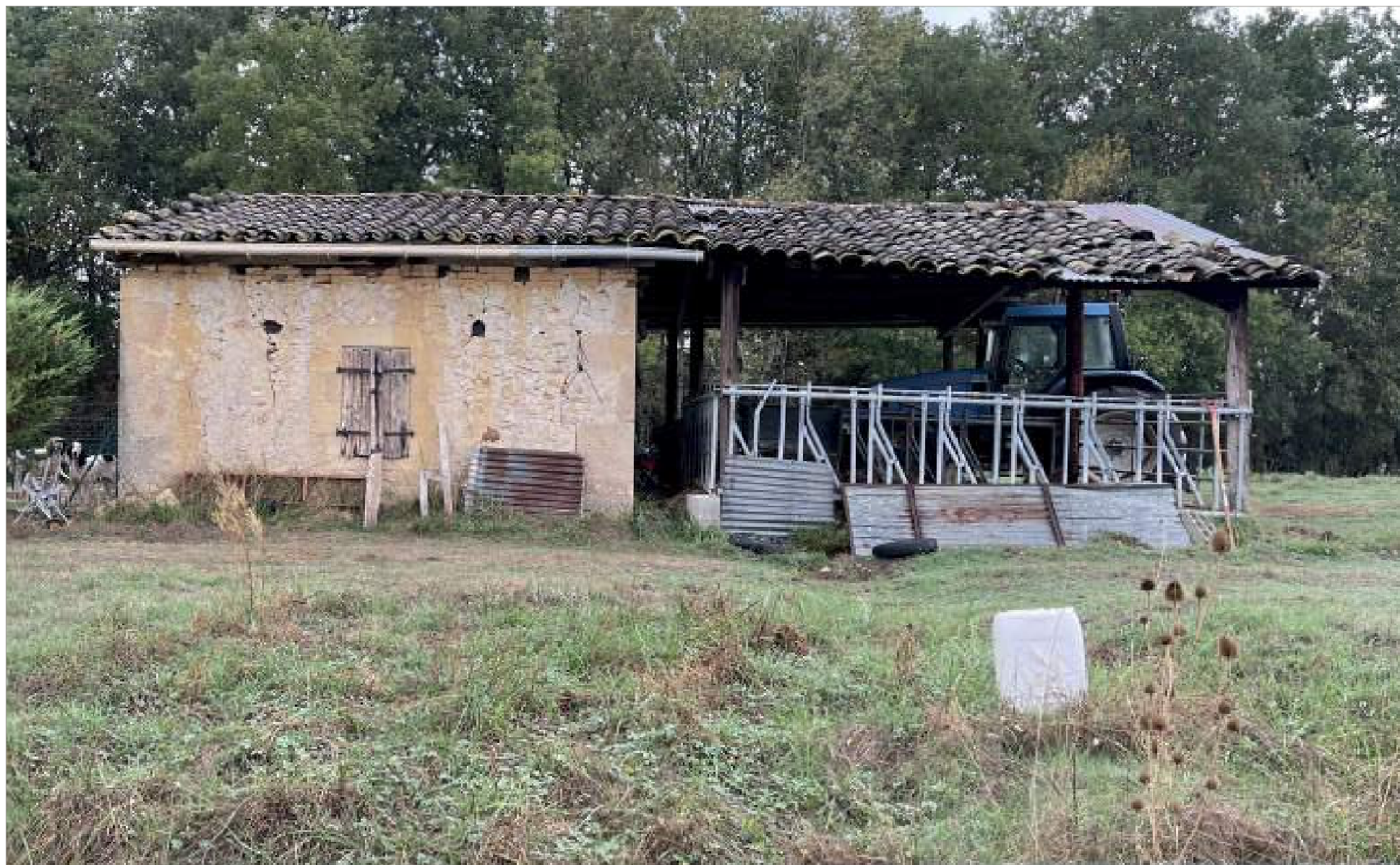
Bâtiment agricole, le hangar est à ossature bois.
