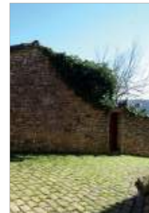
Pavage en pierre récent (joint en herbe ou mortier).
