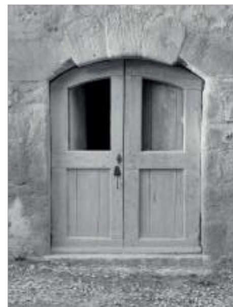
Vantaux à cadres, côté extérieur et intérieur - Grange de Bargues, Assier, Lot.
