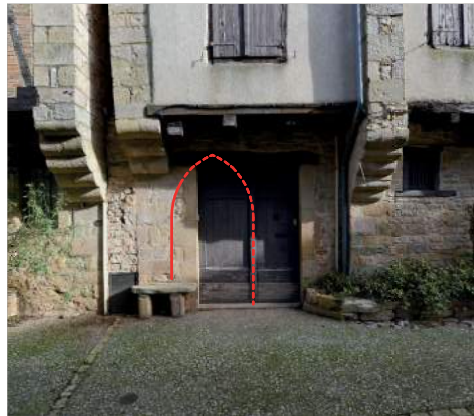
Parcelle 394 - Vestige d'un RdC maçonné avec le vestige d'une arcade en arc brisé.
