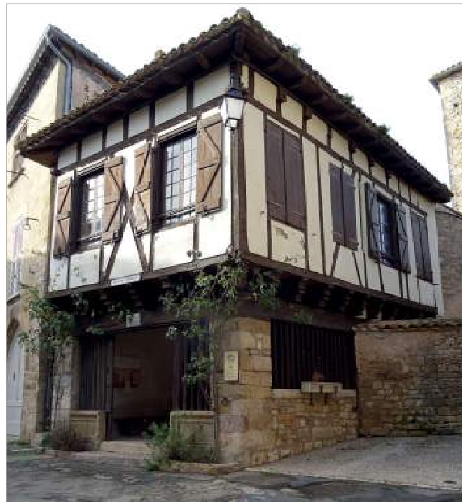
Parcelle 757 - RdC avec piliers en pierre de taille.
