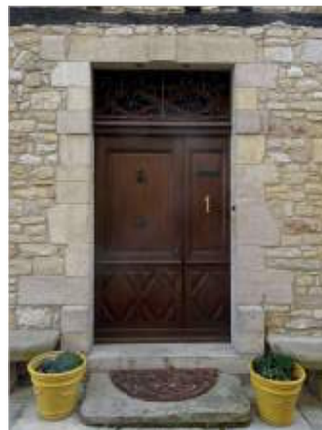
Parcelles ? et 523 - Deux portes bâtarde, les vantaux sont à panneaux.
