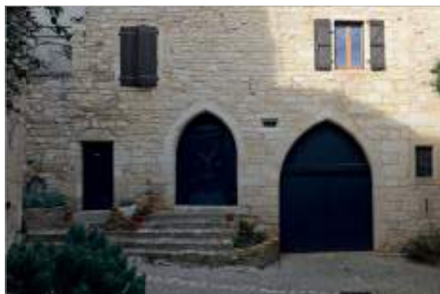
Porte et vitrine couvertes en arc brisé, l'arête est abattue par un chanfrein
