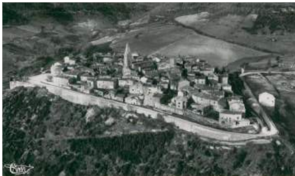
Élévation sud avec la nouvelle route.
