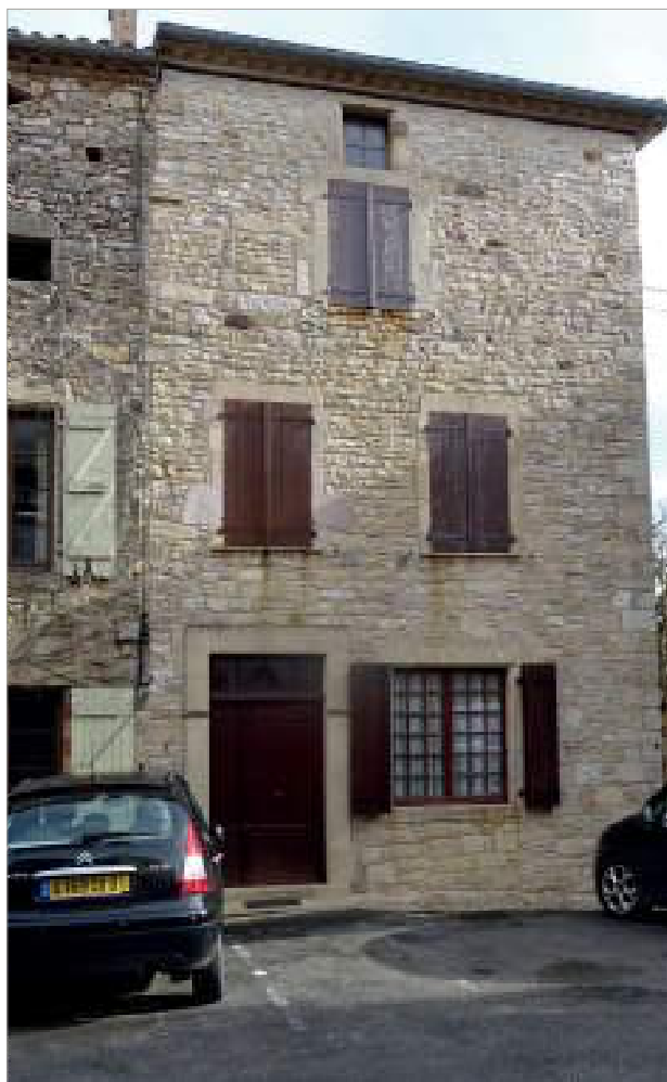
Parcelle 369 - Maison modeste maçonnerie.
