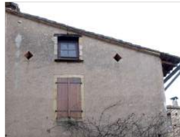
Chaîne d'angle recouverte par l'enduit.
