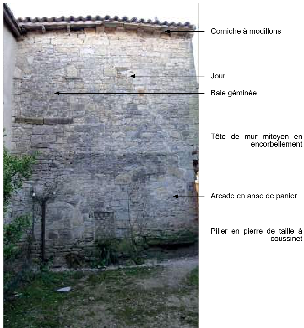
Parcelle 760 - Façade comportant différents vestiges : arcade en anse de panier, baie géminée, jour.
