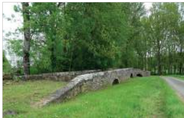
L'ancien pont de Laval - Inscription par arrêté du 27 février 1991 - Propriété de la commune, non cadastré.
