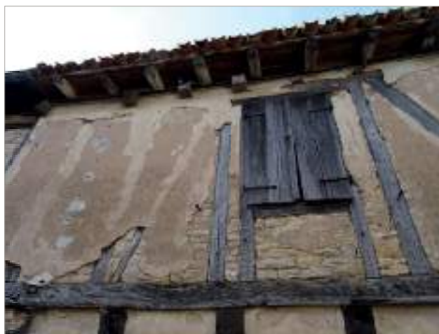
Enduit masquant l'ossature et le hourdis.
