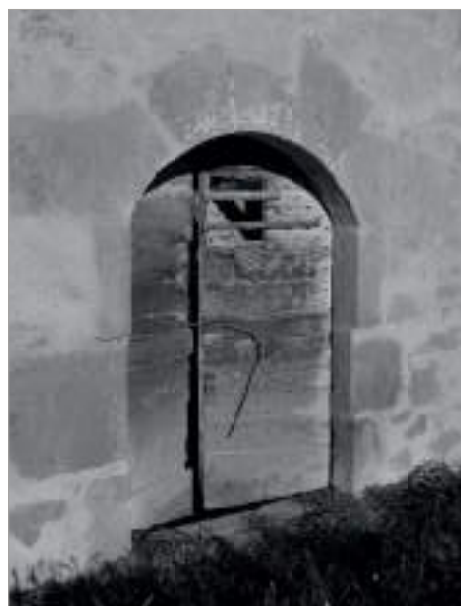
Vantaux à lames croisées, côté extérieur et intérieur - Grange de Bargues, Assier, Lot.
