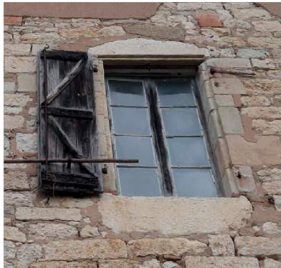
Fenêtre à la française, la taille des vitrages est plus importante. Le format du vitrage reste de proportion carré ou rectangulaire (toujours plus haut que large) - Castelnau-de-Montmirail.
