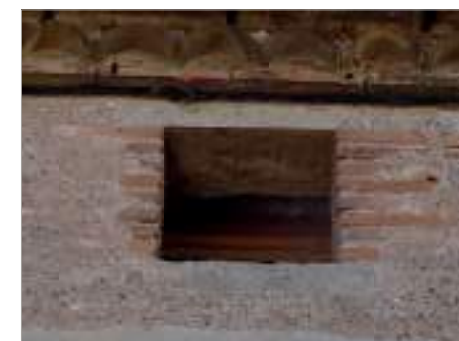
Les baies des combles sont de formes variées : ovale (maisons cossues), rectangulaire, losange. La brique de terre cuite peut-être utilisée.
