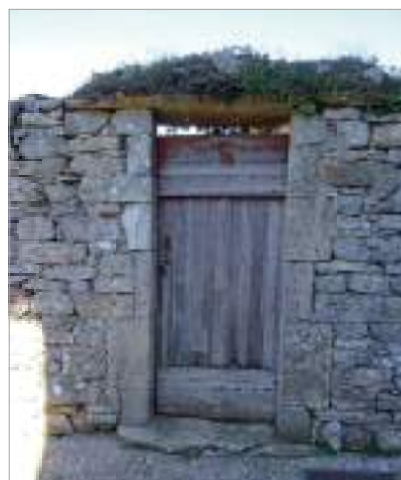
Murets hauts majoritairement protégés par des dalles de pierre. Les linteaux des portes sont également constitués de grandes dalles.
