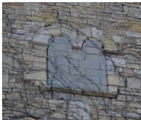
Parcelle 354 - Vestige d'une baie avec imposte (1) et appui (2) moulurés.
