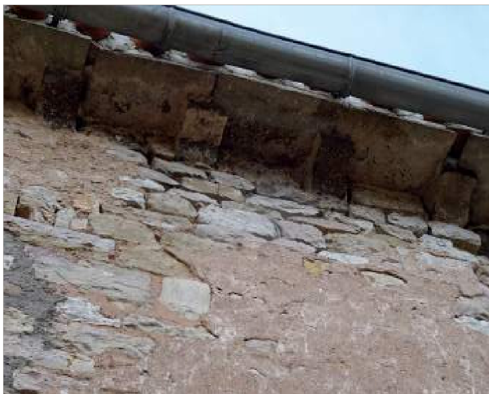
Parcelle 507 - Corniche en pierre de taille du XIII ème ou XIV ème siècle, modillons supportant des dalles.
