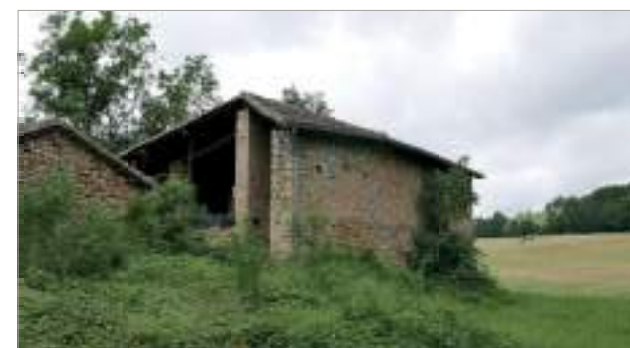
Bâtiments utilitaires côté nord
