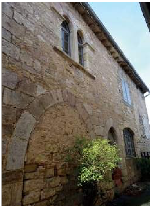
Parcelle 507 - Le couronnement est constitué d'une corniche à modillons (certains sont sculptés). Ce dispositif est caractéristique des maisons de cette période - D'après un relevé Mélanie Chaillou.
