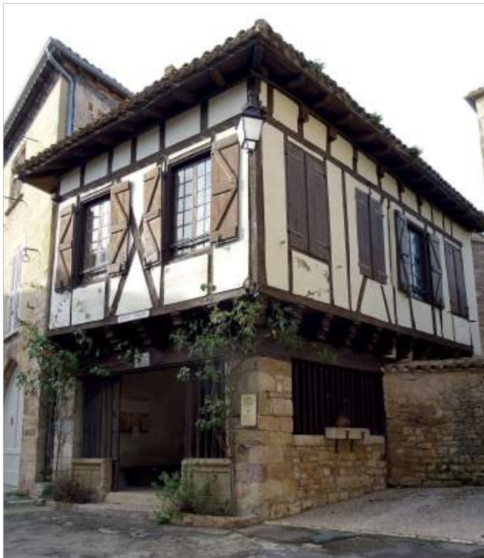
Parcelle 757 - Débord charpenté avec chevrons rayonnants à l'angle.
