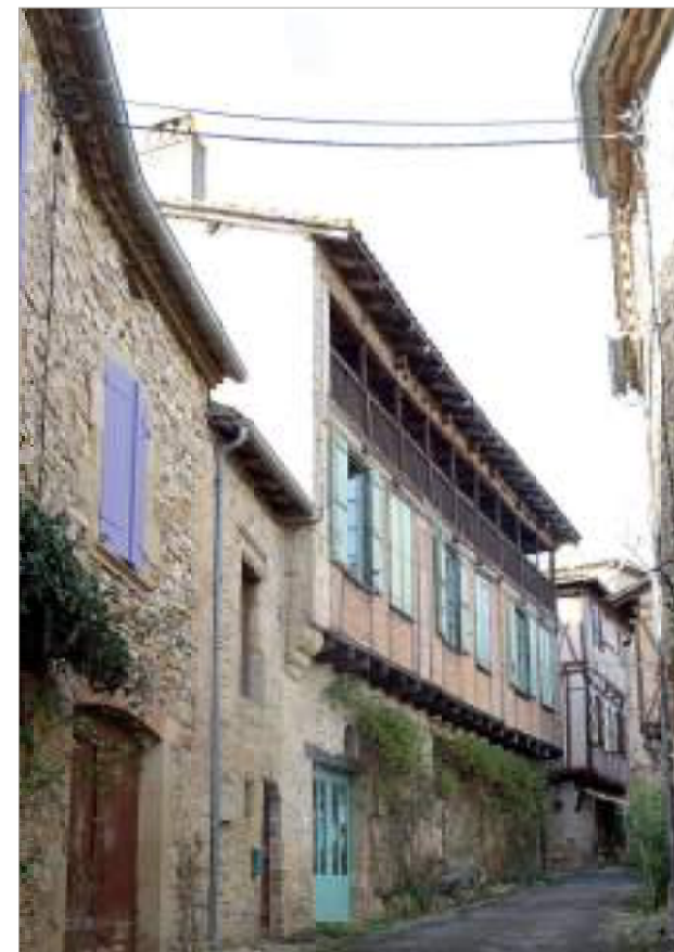
Parcelle 321 - Ancienne gendarmerie aménagée dans une maison médiévale : l'encorbellement a été maintenu et les étages entièrement repris.
