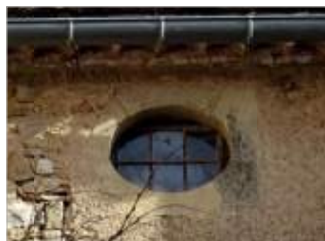
Les baies des combles sont de formes variées : ovale (maisons cossues), rectangulaire, losange. La brique de terre cuite peut-être utilisée.
