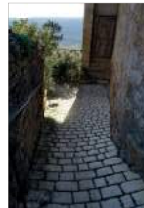
Pavage en pierre récent (joint en herbe ou mortier).
