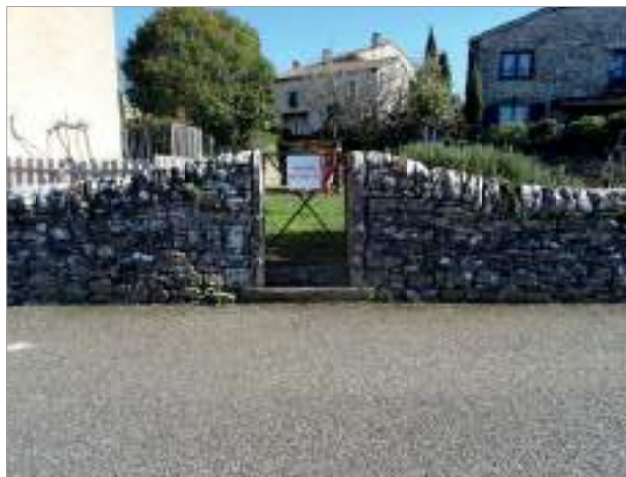
Murets bas couverts de moellons posés à la verticale ou de dalles de pierre. Plusieurs typologies de portes ont été recensées.
