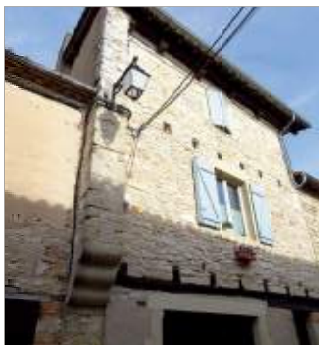
Parcelle 419 - Vestige d'un mur mitoyen en débord.
