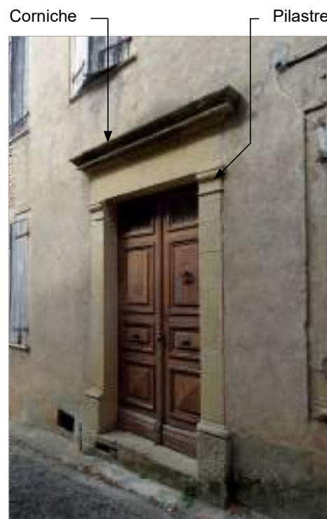
Parcelle 425 - Porte bâtarde (maison cossue) - encadrement constitué de pilastres supportant un linteau droit surmonté d'une corniche.
