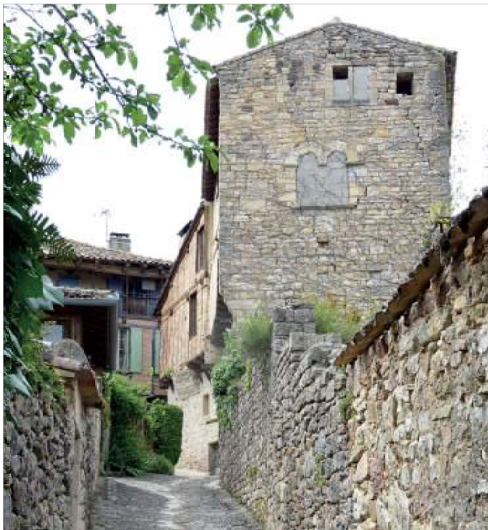
Parcelle 354 - RdC et 1 er étage bâtis en maçonnerie de moellons, le pignon est également maçonné.
