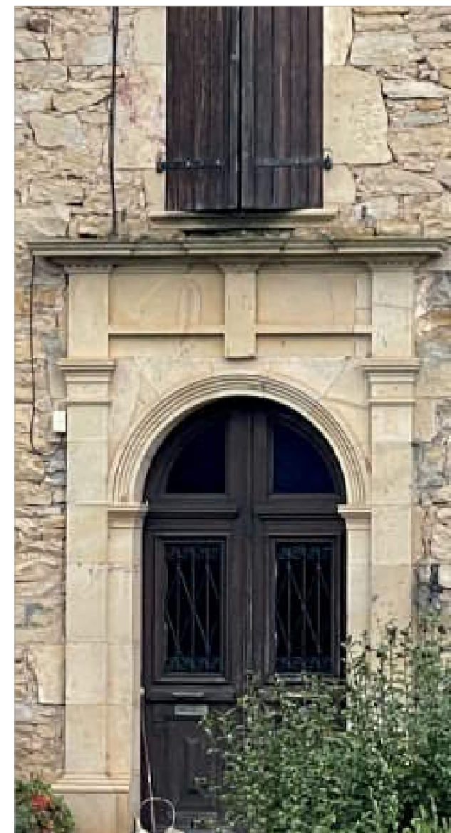
Le Téron - La façade du logis est régulièrement dessinée avec une recherche de symétrie. La porte, au couvrement en arc plein cintre, reçoit un décor sculpté très soigné avec des pilastres supportant une corniche. Les maisons cossues du bourg peuvent avoir ce type de porte.
