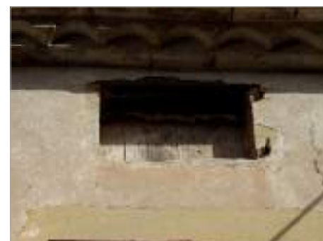
Les baies des combles sont de formes variées : ovale (maisons cossues), rectangulaire, losange. La brique de terre cuite peut-être utilisée.
