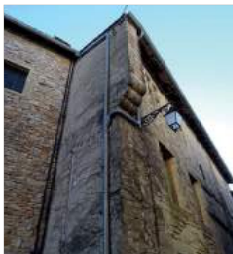
Parcelle 402 - L'encorbellement est au 2 ème étage.
