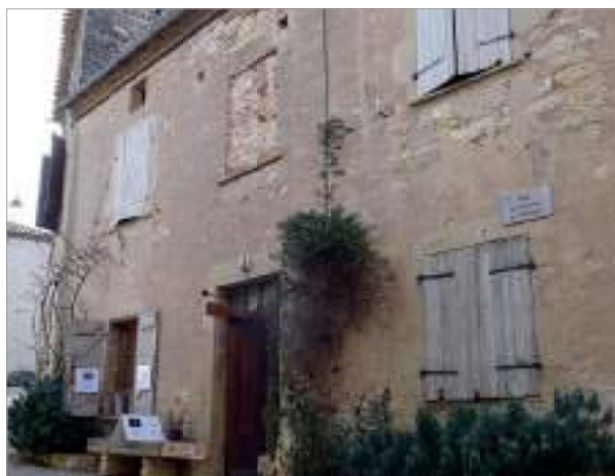
Enduit suivant la forme des pierres.
