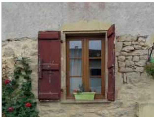
Laval et parcelle 354 - Contrevent rustique et contrevents à écharpes. Ils sont fermés par de simples pièces de bois pivotante.
