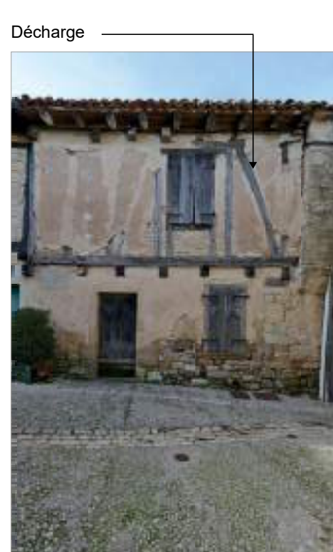
Parcelles 489, 811, 809 - Maison en pan de bois médiévale dont la façade a été reconstruite à l'aplomb comme en atteste la tête de mur en surplomb. L'ossature à grille avec décharges est réalisée avec des bois de remploi.
