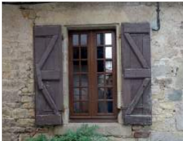
Laval et parcelle 354 - Contrevent rustique et contrevents à écharpes. Ils sont fermés par de simples pièces de bois pivotante.
