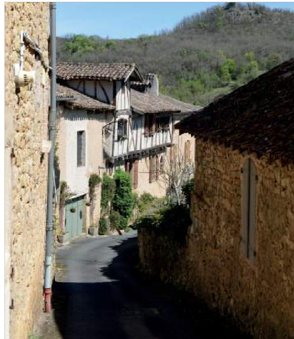
Parcelle 475 - Pan de bois à encorbellement de la fin du Moyen-Âge.
