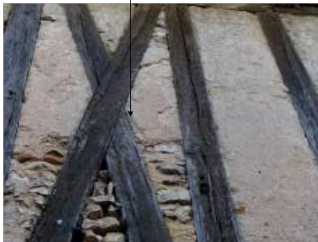
Enduit masquant uniquement le hourdis.
