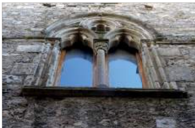
Parcelle 402 - Baie réticulée.
