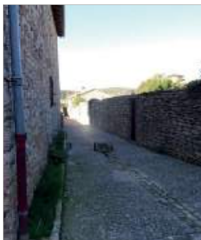
Murets hauts majoritairement protégés par des dalles de pierre. Les linteaux des portes sont également constitués de grandes dalles.
