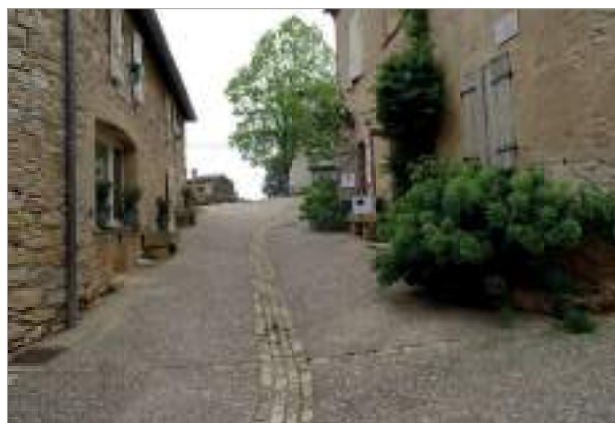
Béton désactivé (agrégats moyens).
