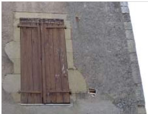
Coupure d'enduit droite : fenêtre et chaîne d'angle.
