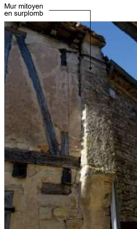
Parcelles 489, 811, 809 - Maison en pan de bois médiévale dont la façade a été reconstruite à l'aplomb comme en atteste la tête de mur en surplomb. L'ossature à grille avec décharges est réalisée avec des bois de remploi.
