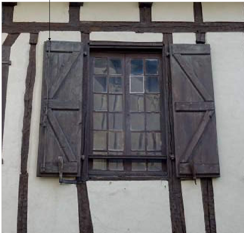
Parcelle 757 - Fenêtre à la française, avec des vitrages de petites tailles et de format carré ou rectangulaire de proportion verticale. Les contrevents à écharpes sont fermés par une espagnolette.
