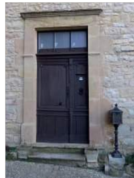
Parcelles ? et 523 - Deux portes bâtarde, les vantaux sont à panneaux.
