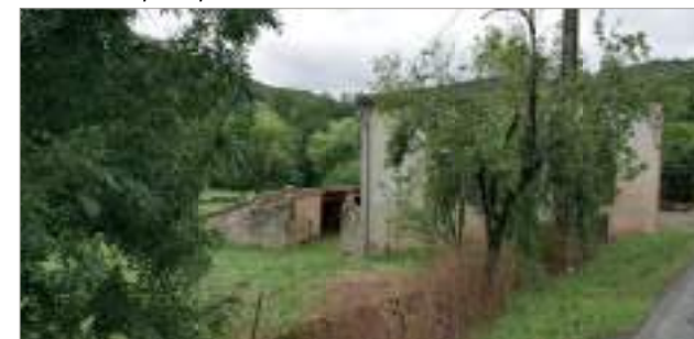
Bâtiments utilitaires et habitation côté nord
