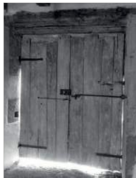
Vantaux à lames croisées, côté extérieur et intérieur - Grange de Bargues, Assier, Lot.
