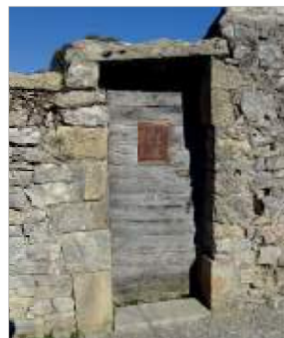
Murets hauts majoritairement protégés par des dalles de pierre. Les linteaux des portes sont également constitués de grandes dalles.
