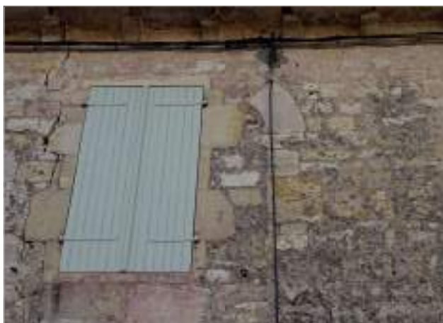
Vestige de la baie géminée.
