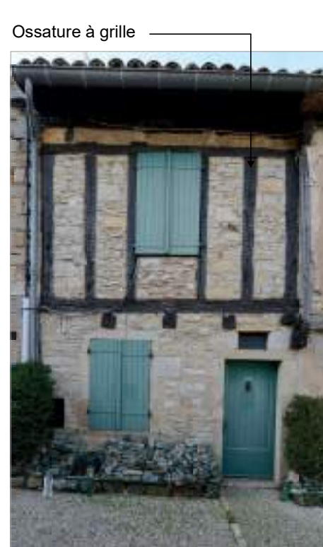
Ossature à grille avec bois en remploi.
