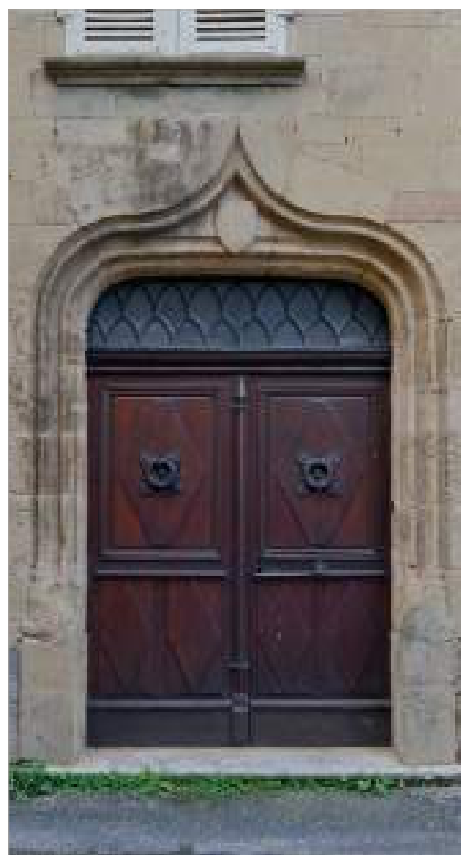
Encadrement mouluré, la plate-bande est ornée d'une accolade.
