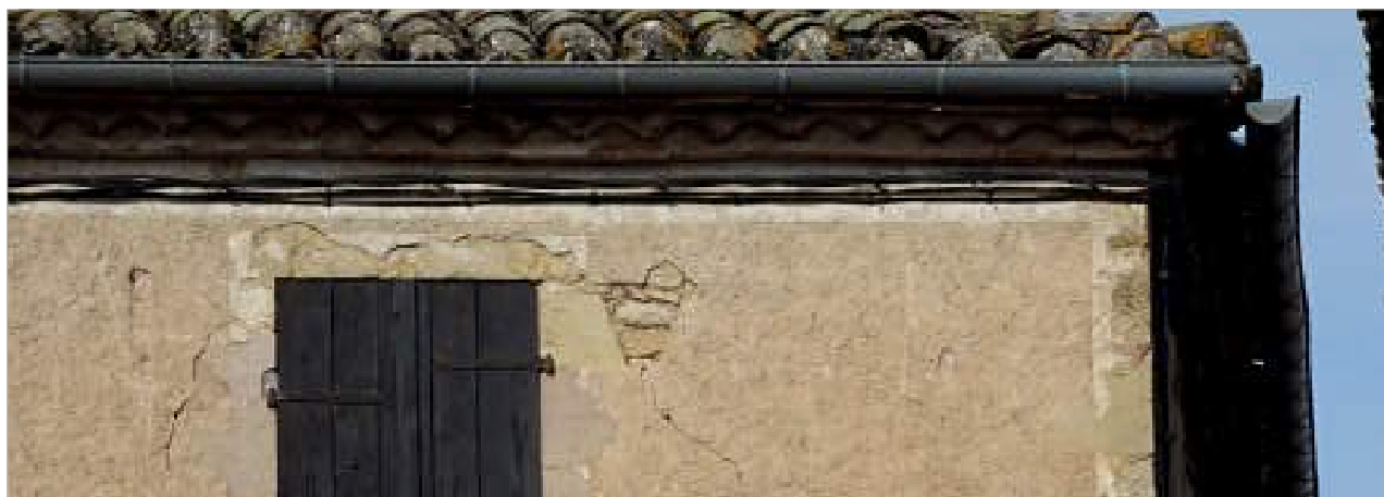
Parcelle 395 - Enduit fin badigeonné en blanc sur la génoise, le bandeau, l'encadrement de la fenêtre et la chaîne d'angle.
