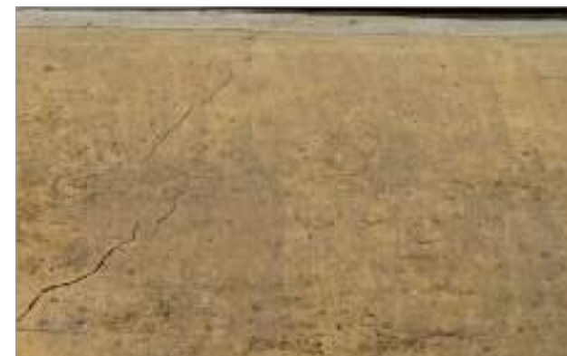
Enduit badigeonné à l'ocre jaune.
