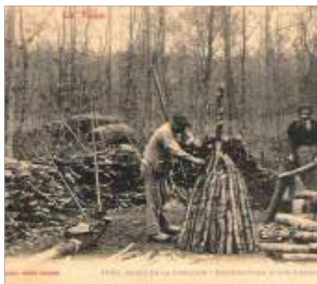
Forêt de Grésigne, construction d'une charbonnière.
