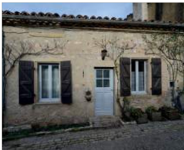
Parcelle ? - Maison modeste maçonnerie.
