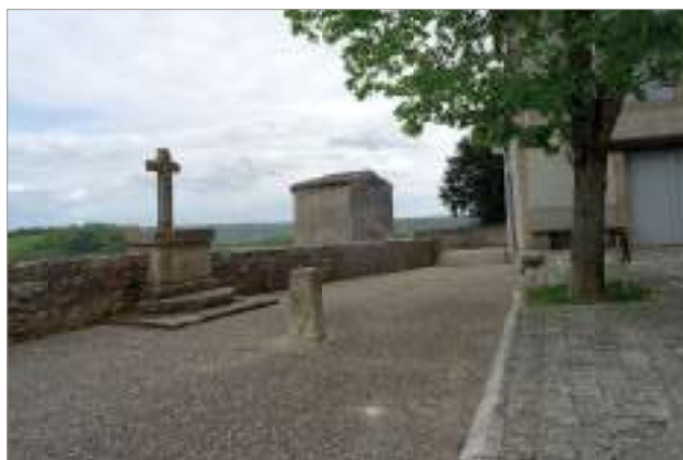
Béton désactivé (agrégats fins).
