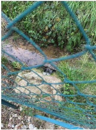
=&gt;Clapet sortie HS
