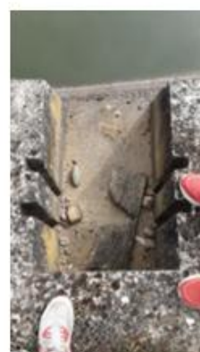
Canal de sortie du deuxième bassin et seuil en V
