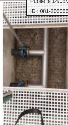
Ouvrage de répartition
