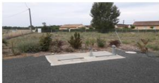
Poste de relevage
