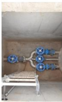
Bache et chambre à vanne du PR
