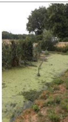
Zone de rejet végétalisée
