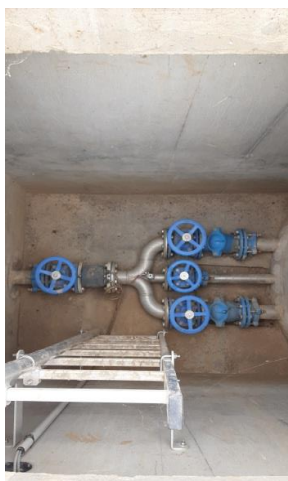
Bache et chambre à vanne du PR
