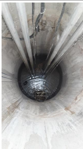
Bache et chambre à vanne du PR
