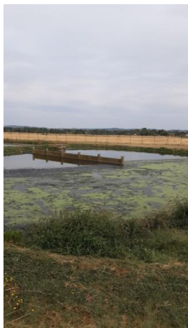
Premier bassin (présence de boues en surface)
