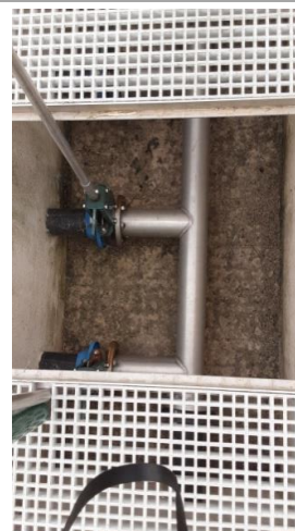
Ouvrage de répartition
