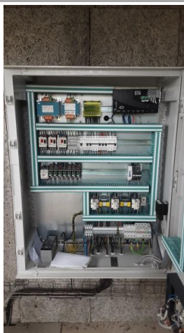
Armoire électrique du PR - S S550
