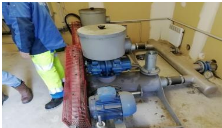
Locaux et aménagements
