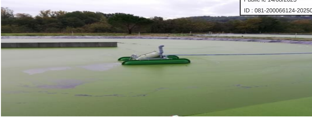
Lagunage naturel - Bassin de finition - Rejet au milieu récepteur
