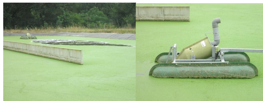
Lagune aérée n°2 Vue d'ensemble (à gauche) Aérateurs flottants à vis hélicoïdale (à droite)
