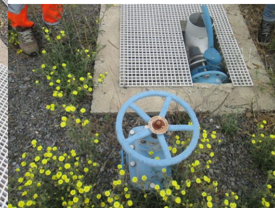
Canal de comptage Vue d'ensemble (à gauche) – Jeu de vanne pour le by-pass (en bas)
