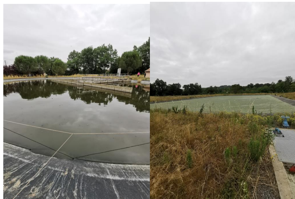
Vue d'ensemble lagune aérée (à gauche) et lagune de finition (à droite)
