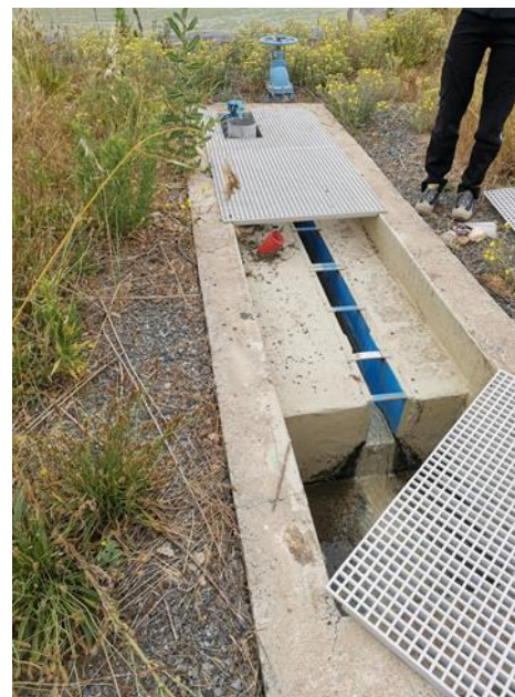
Canal de comptage Vue d'ensemble (à gauche) – Jeu de vanne pour le by-pass (en bas)
