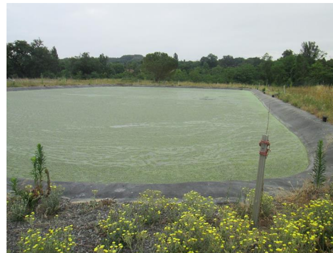
Lagune de finition – lentilles d'eau présentes sur toute la surface
