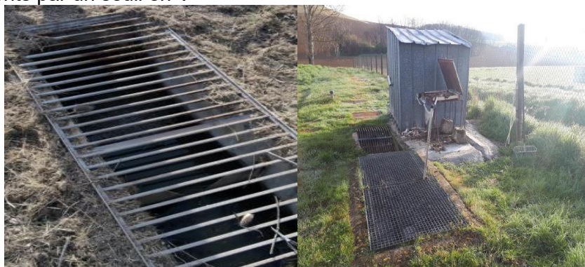
Arrivé effluents par un seuil en V
