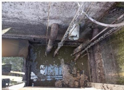
Poste de relevage
