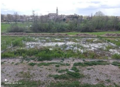
Lit plantés de roseaux - Le lit semble noyé
