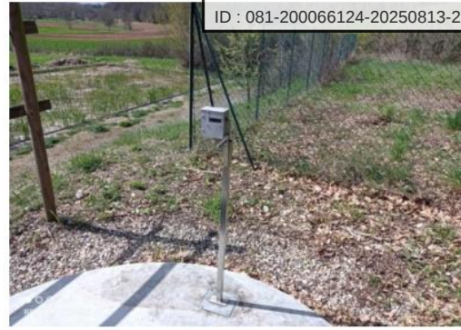
Ouvrage de bâchée
