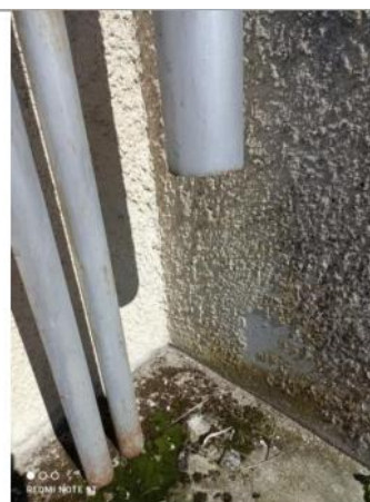
Canalisation extérieure où l'installation d'une vanne est envisagée
