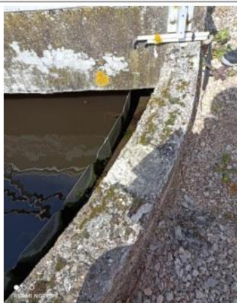
Structure bétonnée vieillissante
