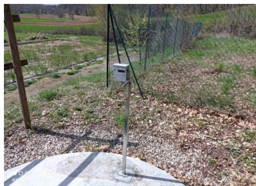
Ouvrage de bâchée
