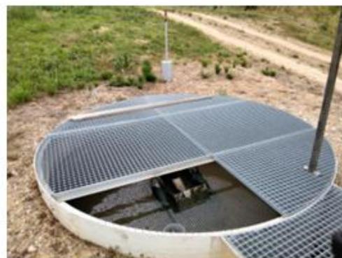
Ouvrage de bâchée et répartition 2nd étage
