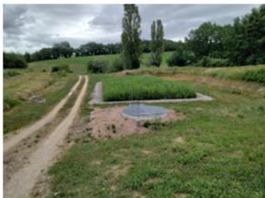
Bassin 2nd étage
