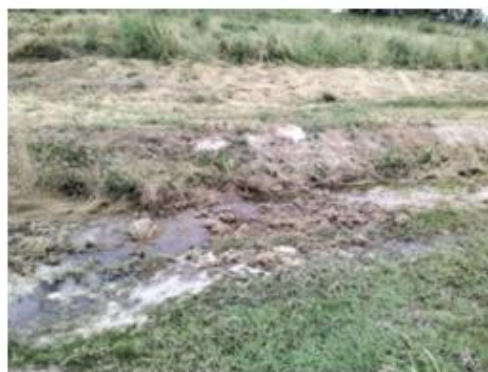
Evacuation difficile des eaux du fossé
