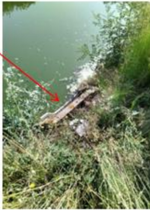
Planche amovible permettant de gérer le passage de l'eau d'un bassin à l'autre
