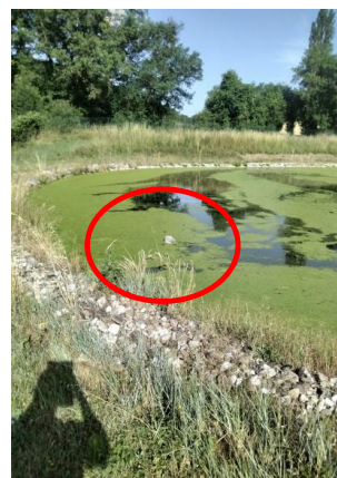
Système de chasse d'eau hydraulique
