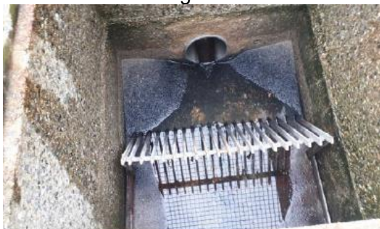
Dégrilleur - Décanteur Digesteur
