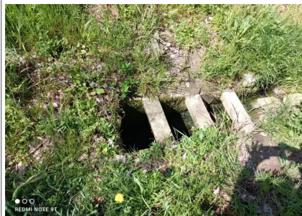
Fossé de rejet
