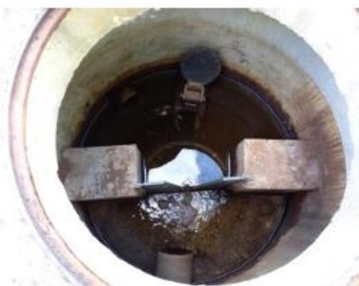
Regard de sortie seuil en V
