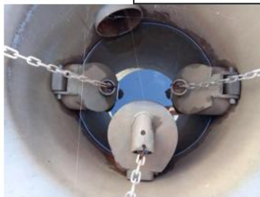
Ouvrage de répartition 2nd étage
