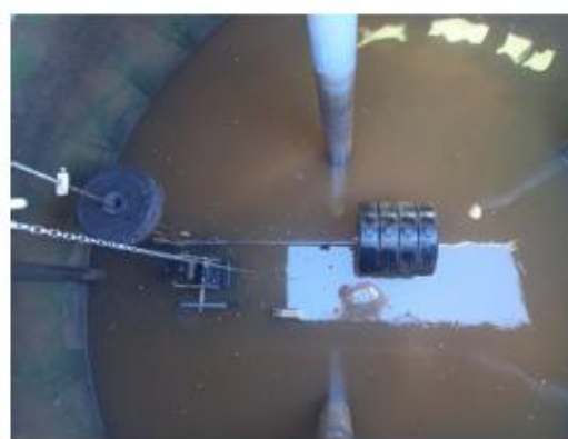
Intérieur de l'ouvrage de bâchée (propre)
