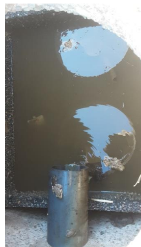
Arrivée de l'eau dans le bac transquiliant du lit bactérien
