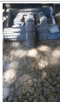
Chasse à auget avec compteur de bâchées
