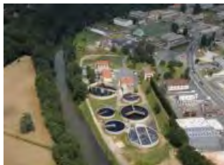
Figure 107 : Station d'épuration mixte de Graulhet, source : fonds communal.
