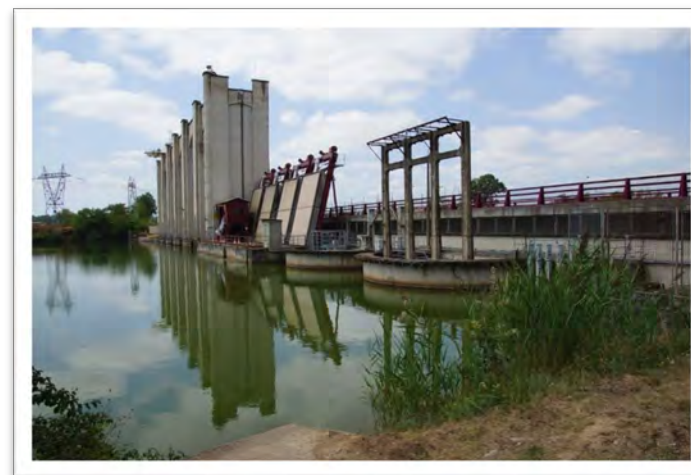
Barrage hydroélectrique de Rivière sur le Tarn
