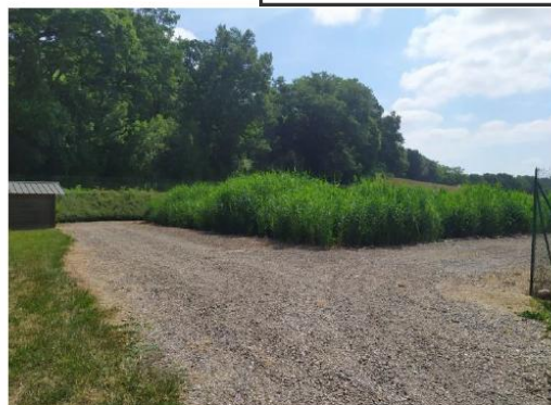
Filtres plantés de roseaux (3) et local technique
