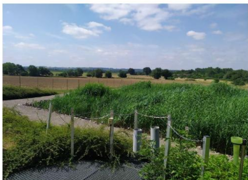
Compteur de bâchée et ouvrage de répartition
