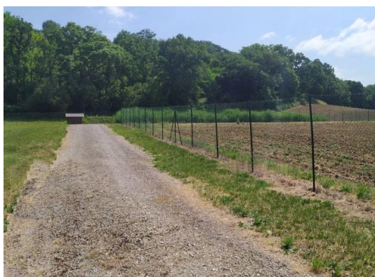
Voirie Accès station
