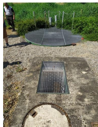
Regard d'arrivée - Dégrillage manuel - Ouvrage bâchée
