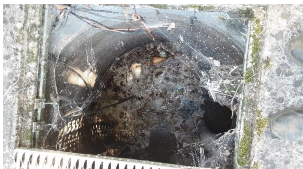
Poste de relevage
