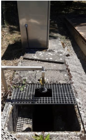
Sonde US et préleveur fixe en sortie de la station
