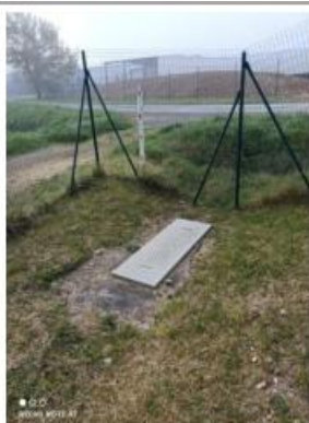
Canal de comptage puis rejet dans le fossé
