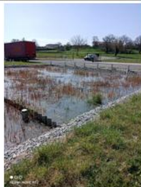
1er étage - 9 lits - Filtres noyés pour éradication des adventices
