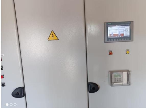
Afficheur/supervision Siemens SIMATIC HMI
