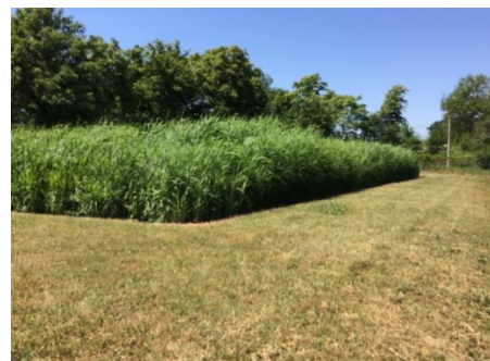
Filtre planté de roseaux (1 étage)
