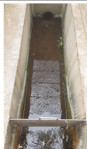
Canal de sortie avec seuil en V
