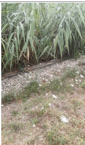
Bâche apparente sur le bord des lits
